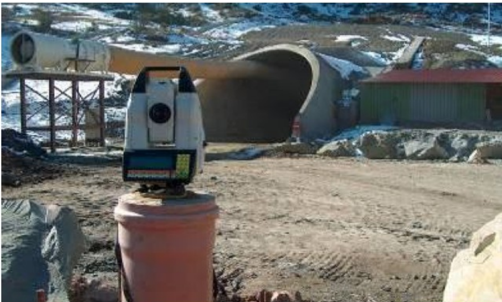
Σχήμα 2.23: Γεωμετρικός έλεγχος της τελικής επένδυσης του στομίου της σήραγγας.
