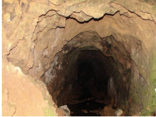
Σχήμα 1.1: Είσοδος μεταλλευτικής σήραγγας.
