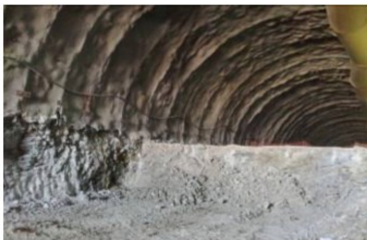
Σχήμα 1.14: Εκσκαφή σήραγγας σε δύο φάσεις.
