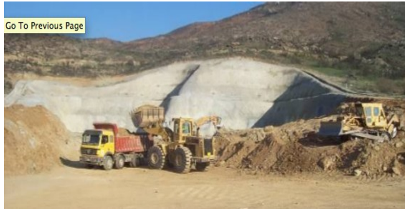
Σχήμα 2.2: Διαμόρφωση μετώπου σήραγγας σε τελικό στάδιο.
