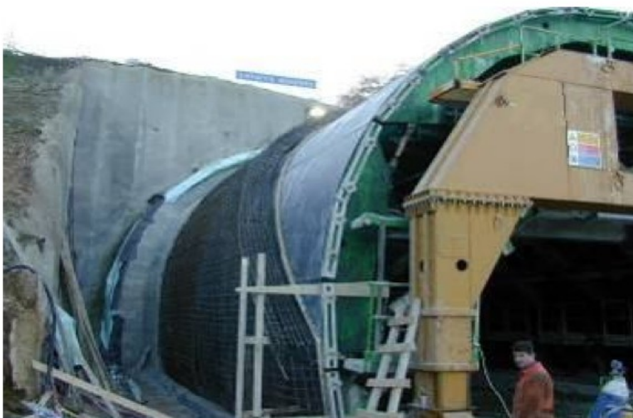
Σχήμα 2.22: Το καλούπι με τον φέροντα οπλισμό του.
