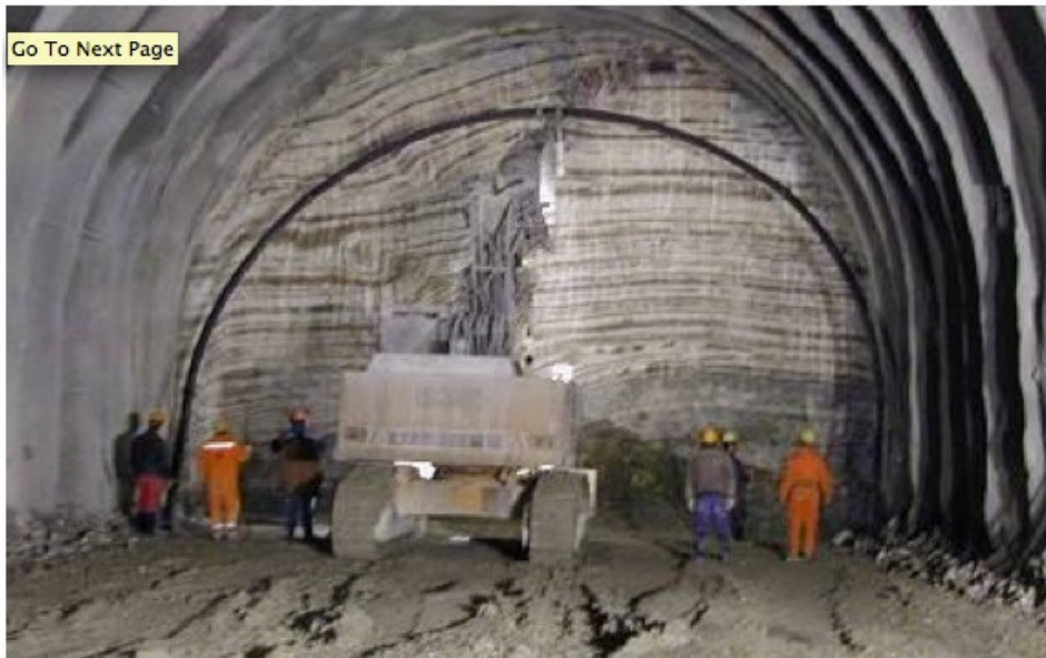
Σχήμα 1.32: Τοποθέτηση χαλύβδινου πλαισίου.
