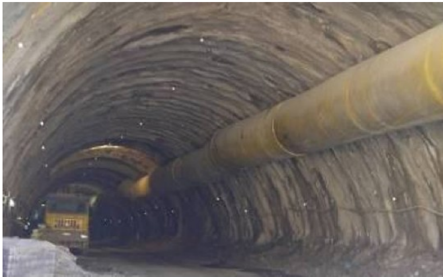
Σχήμα 2.26: Σταθμοί σύγκλισης σε πυκνή διάταξη διατομών ελέγχου.
