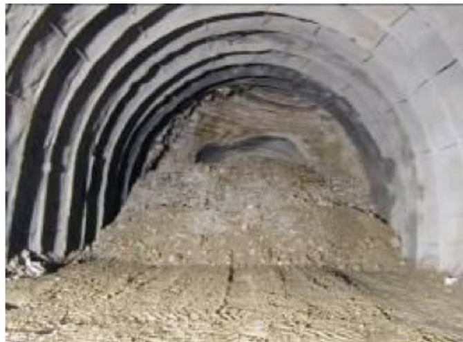
Σχήμα 2.10: Πέρασ διάνοιξης σήραγγας.
