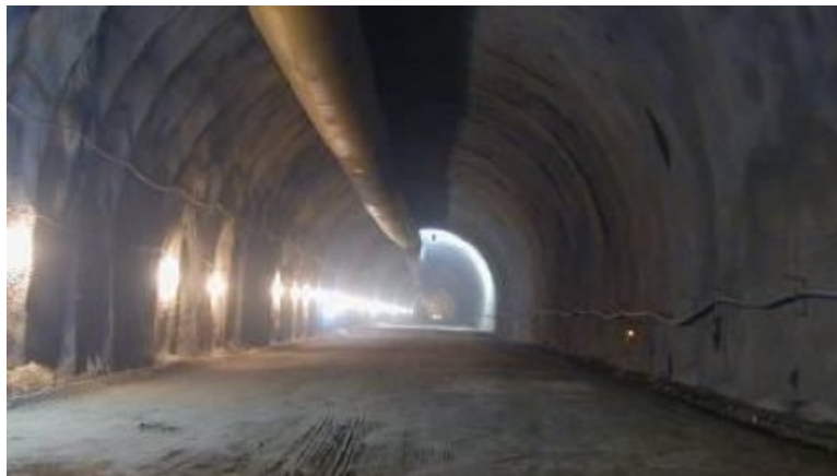
Σχήμα 1.17: Σήραγγα χωρίς ανεστραμμένο τόξο.
