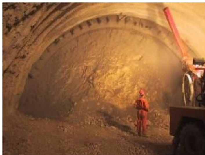
Σχήμα 1.33: Ρίψη εκτοξευόμενου σκυροδέματος.
