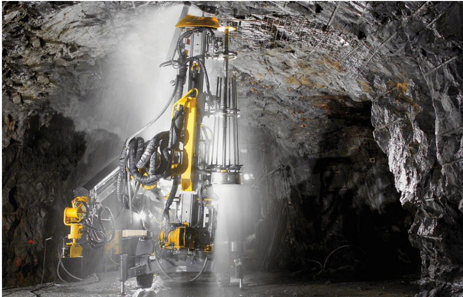
Σχήμα 1.23: Μηχάνημα τοποθέτησης αγκυρίων με laser.
