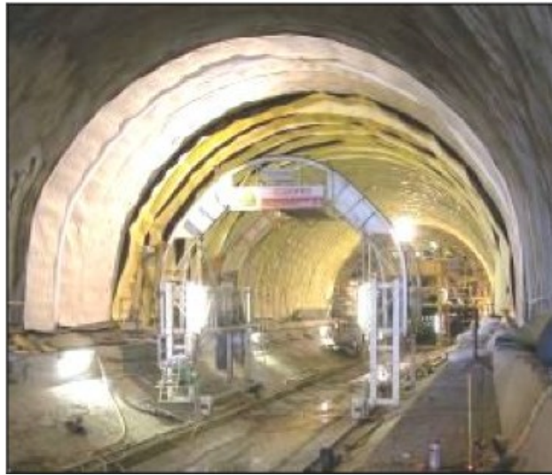
Σχήμα 4.5: Τοποθέτηση αποστραγγιστικής μεμβράνης.
