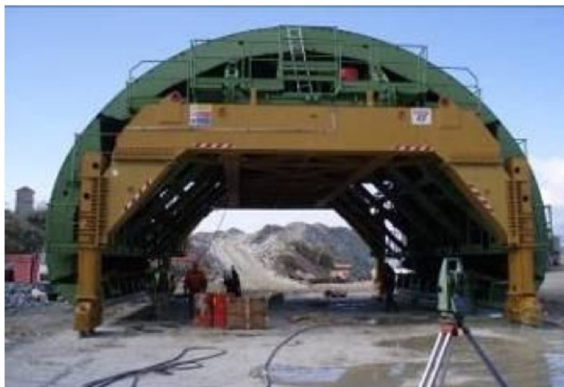
Σχήμα 2.20: Μεταλλότυπος θόλου.
