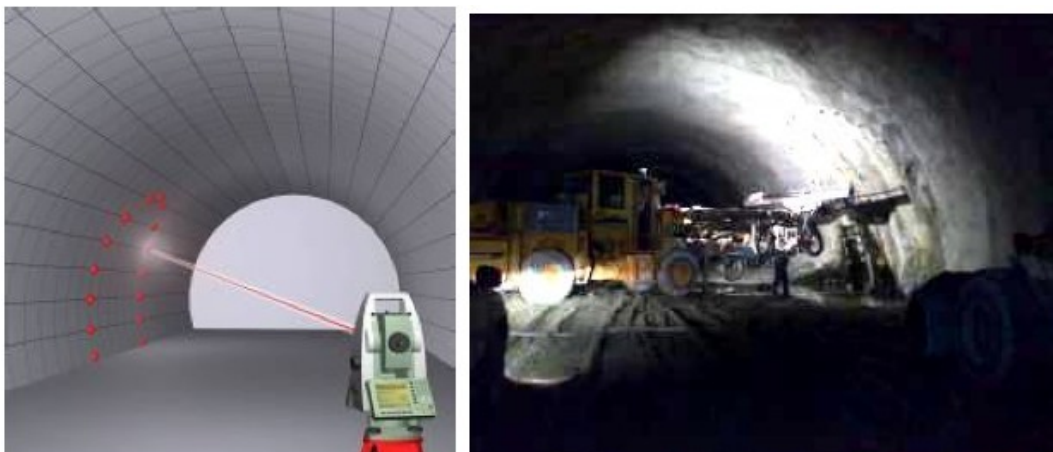
Σχήμα 4.11: Αριστερά: Σχεδιάγραμμα χάραξης καμπύλης εκσκαφής / Δεξιά: Διάτρηση εγκάρσιου διαδρόμου.
