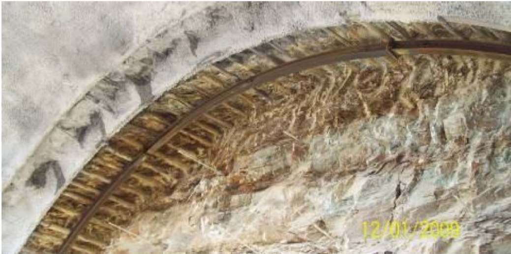
Σχήμα 2.12: Σωστή εφαρμογή δοκών προπορείας, οι οποίες εφάπτονται στο πλαίσιο.
