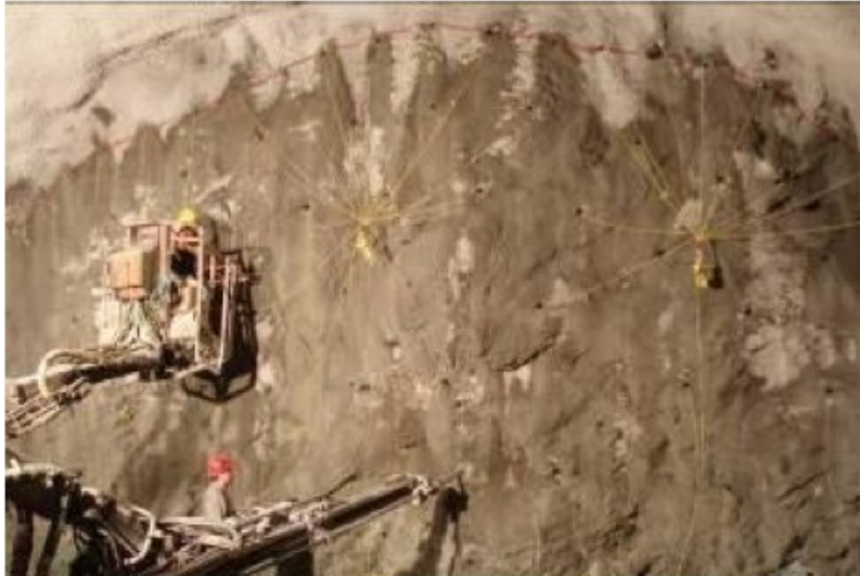
Σχήμα 1.28: Γόμωση εκρηκτικών υλών.
