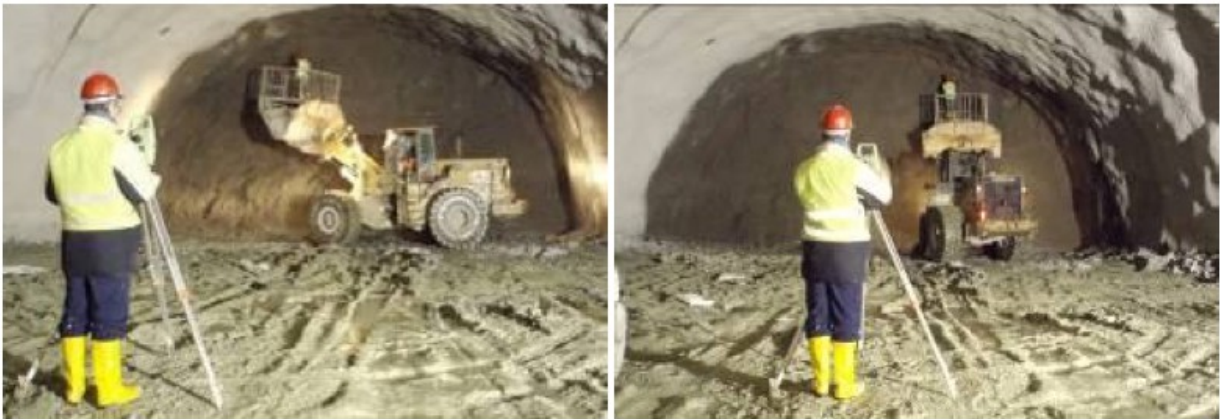
Σχήμα 2.18: Φάσεις χάραξης γραμμής διάτρησης. Διακρίνεται η κόκκινη γραμμή εκσκαφής.
