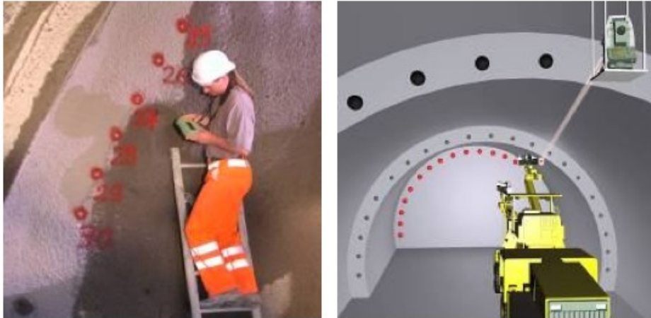
Σχήμα 4.8: (α) Χάραξη σημείων διάτρησης / (β) προσανατολισμός στελέχους.
