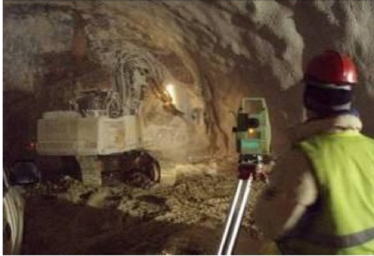
Σχήμα 2.16: Έλεγχος της διατομής εκσκαφής.
