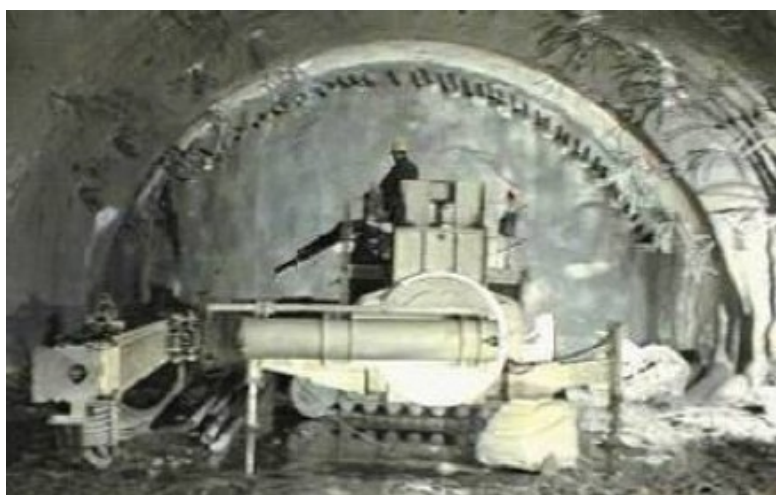
Σχήμα 1.18: Εφαρμογή δοκών προπορείας (κατασκευή ομπρέλας).
