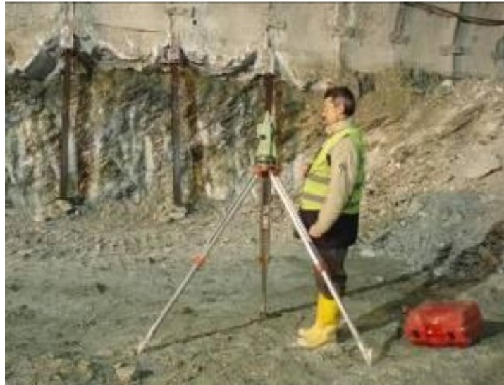
Σχήμα 2.19: Έλεγχος εκσκαφής και ποδαρικών στη Β' Φάση.
