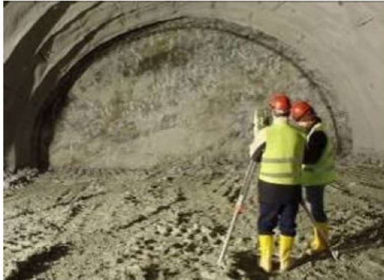
Σχήμα 2.15: Παραλαβή πλαισίου και εκσκαφής.
