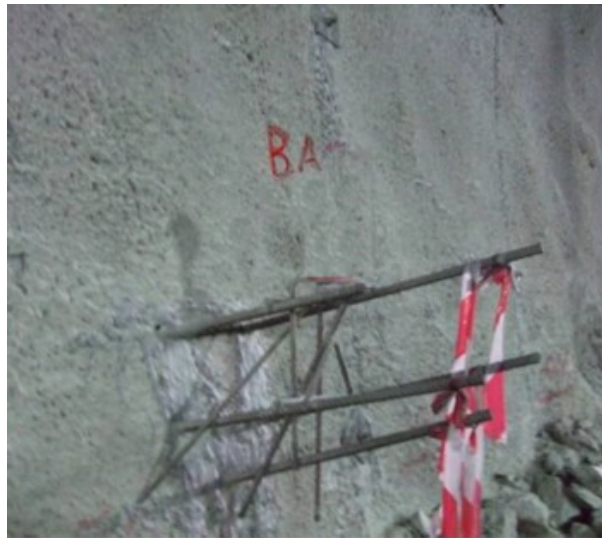
Σχήμα 2.5: Στάση με αγκυρωμένες ράβδους χάλυβα και ενεματώσεις τσιμέντου.
