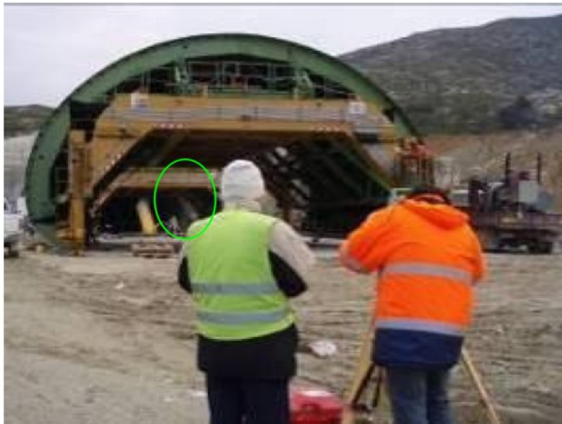
Σχήμα 2.21: Ταυτόχρονος γεωμετρικός έλεγχος μεταλλοτύπου και στα δύο άκρα του.
