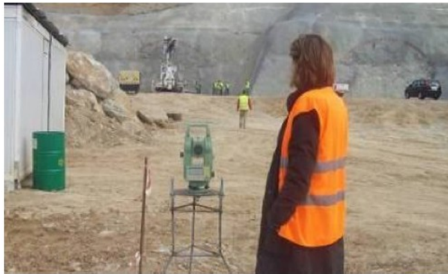
Σχήμα 2.11: Δίνοντας τη σωστή κατεύθυνση των δοκών προπορείας.
