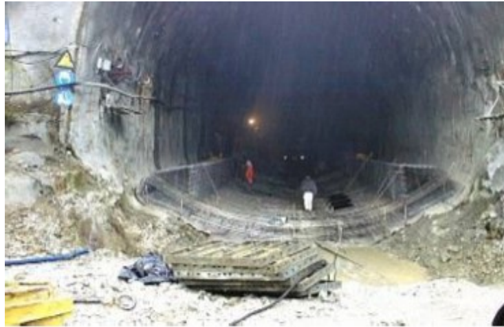
Σχήμα 1.16: Τοποθέτηση οπλισμού ανεστραμμένου τόξου.
