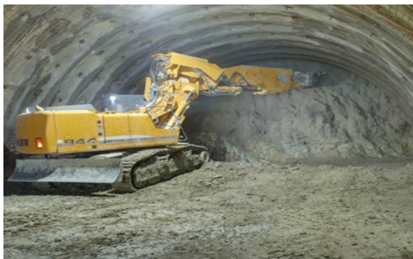
Σχήμα 1.31: Ξεσκάρωμα.
