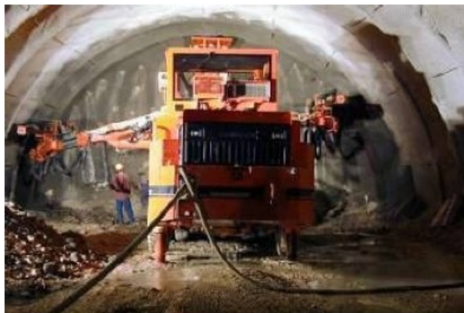
Σχήμα 1.27: Διάτρηση με διατρητικό τύπου Jumbo.
