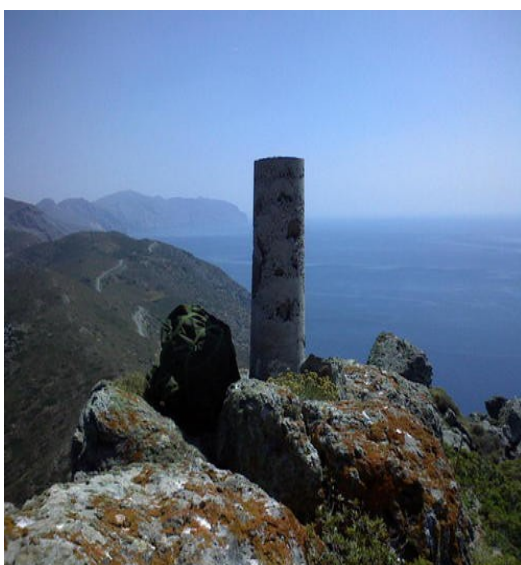
Σχήμα 2.3: Φωτογραφίες τριγωνομετρικών βάθρων.
