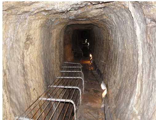
Σχήμα 1.2: Σήραγγα που εξυπηρετούσε ως αγωγός υδάτων κατά τον 6ο αι. π.χ.(Ευπαλίνειο Όρυγμα).
