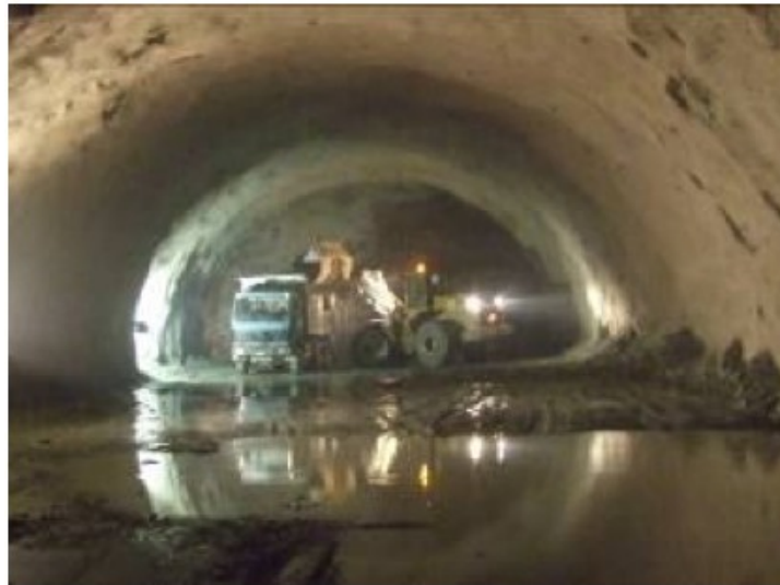
Σχήμα 1.30: Απομάκρυνση αδρανών υλικών .
