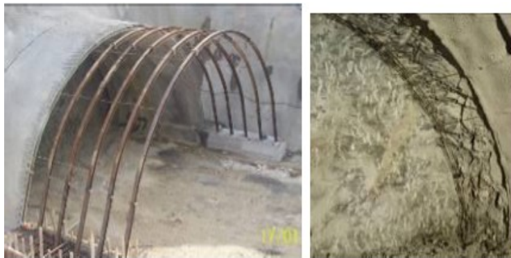
Σχήμα 1.25: Αριστερά: Χαλύβδινες νευρώσεις, Δεξιά: Δικτυωτό πλαίσιο.
