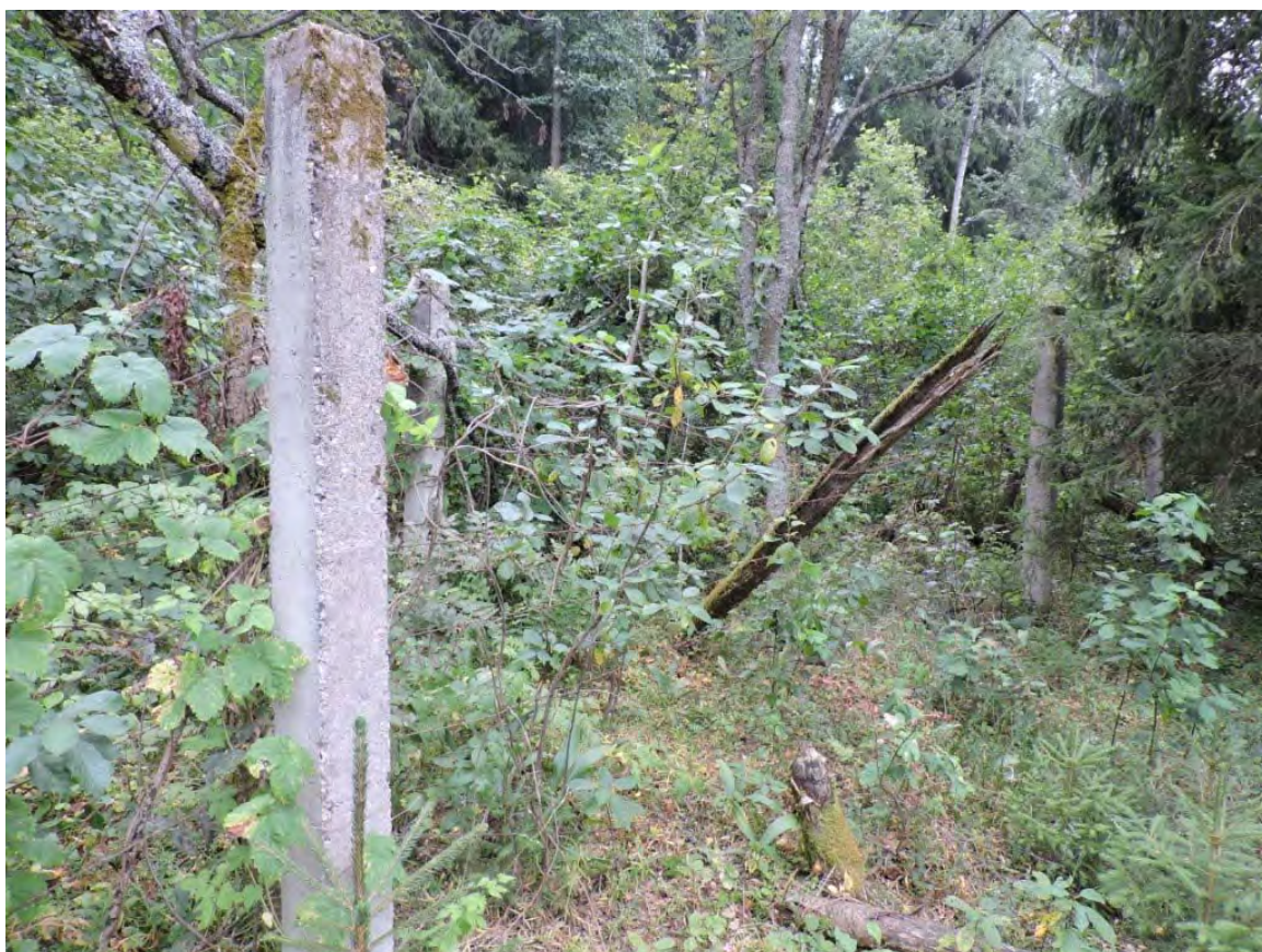
Рис. 38. Старая ограда испытательного полигона на краю долины р. Мелёжи (западная часть полигона)
