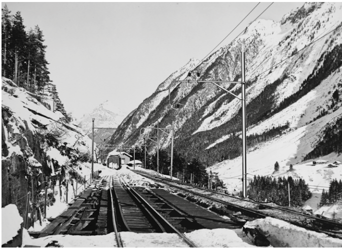
1 – Begutachtung von Schäden an der Rohrbachbrücke nach Lawinenniedergängen am 19. und 22. April 1917. Die Lawine hat das Bachbett fast aufgefüllt. (Foto: SBB Historic)
