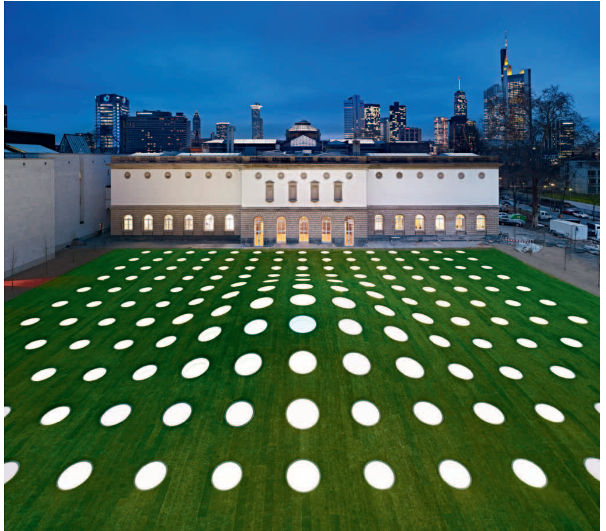
Außenansicht des Erweiterungsbaus
