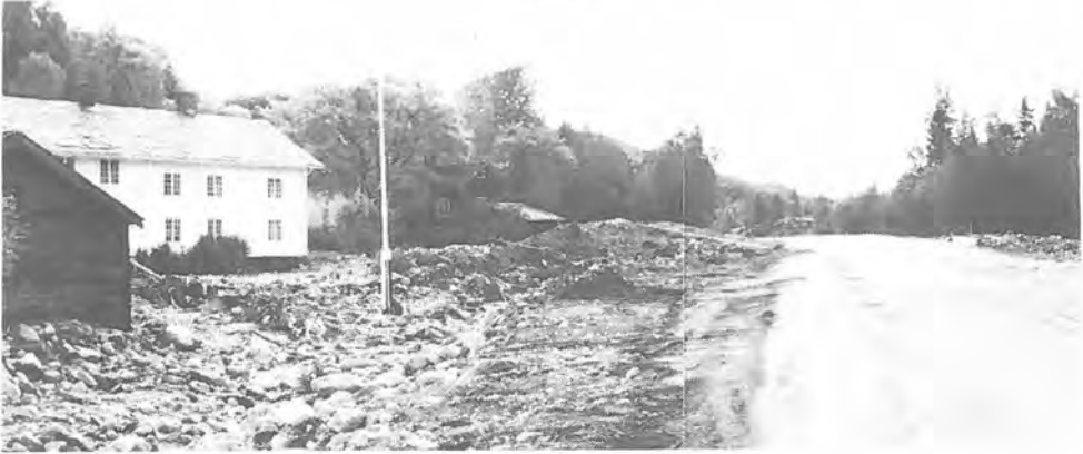
Figur 5. Elva Rolla tok nytt løp langs E6 ved Mageli
