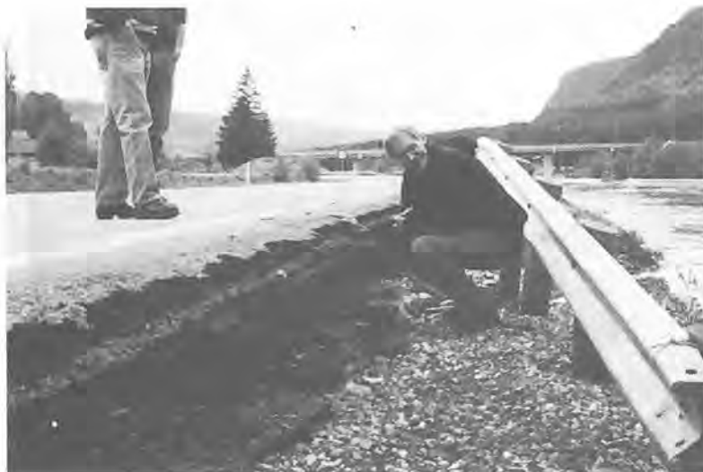
Figur 9. Kantskade på E6 ved Tingberg i Gudbrandsdalen.
