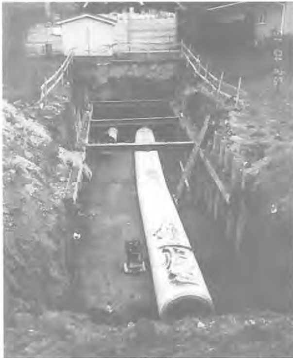
Figur 5 Fullførelse av et rørtrykkingsprosjekt som har vært ute av kontroll
