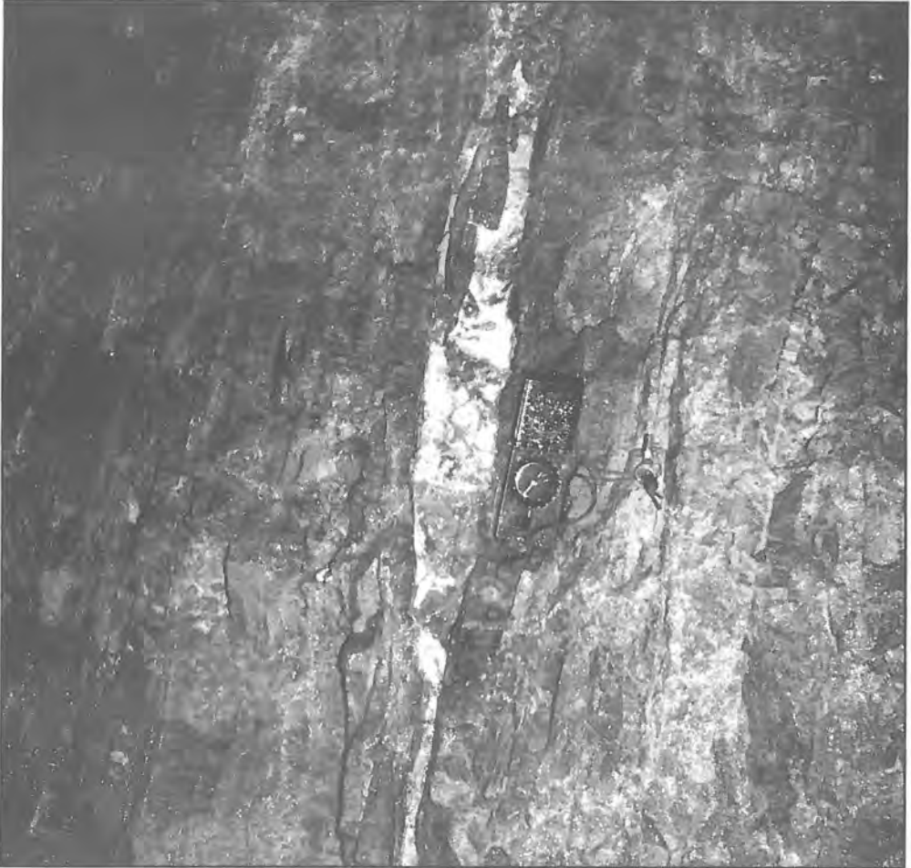
Figur 9. Injeksjon i svakt berg. Foto av utgående på stufflaten av injisert sprekk på stufflaten pel 1505. Sprekkeåpningen er i sin helhet fylt med sement (lyst materiale).
