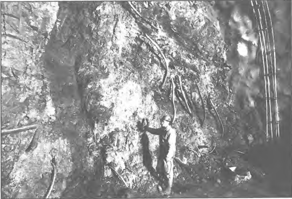
Figur 6. Problemsone Bjørøy. Foto av stuff ved pel 1486. Sand og silt ses som det mørke feltet litt til venstre for midten av bildet.
