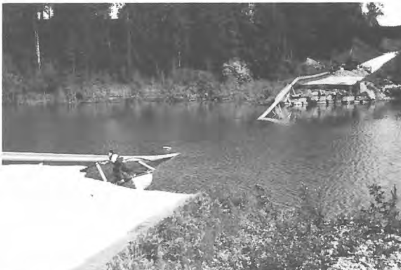
Figur 8. Gjennombrudd i vegfylling på fv. 434 ved Arneberg bru i Hedmark.
