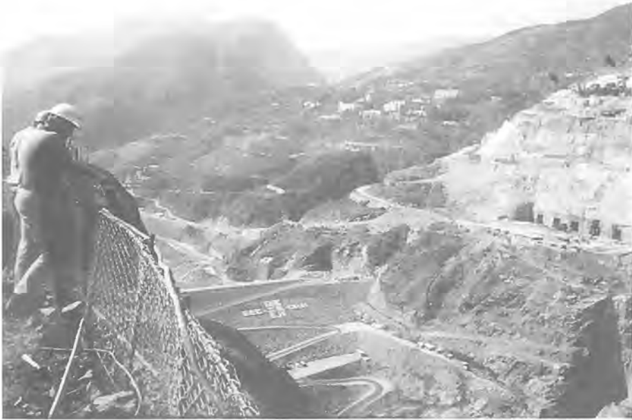
Fig. 3. Oversikt mot "Left Bank" med inntakstunnelen og høye skjæringer i forbindelse med adkomstveier, betongstasjon etc.
