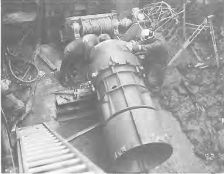
Figur 3 Eksempel på styrbart frontskjold. Det vridbare skjæret (nederst) opereres hydraulisk
