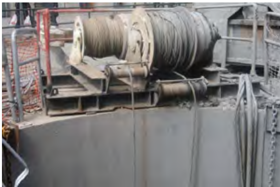
Figur 11 a Sjakt S2. Merk vinsjer for trekking av skuff for masser.
