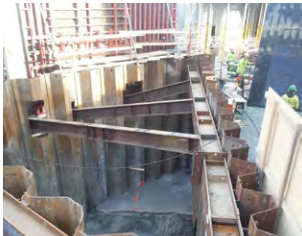
Figur 10 Trinn 5c – Avstiving mot kjellerdekke
