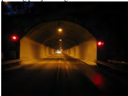
Figur 24. Tunnel med hvite vegger
