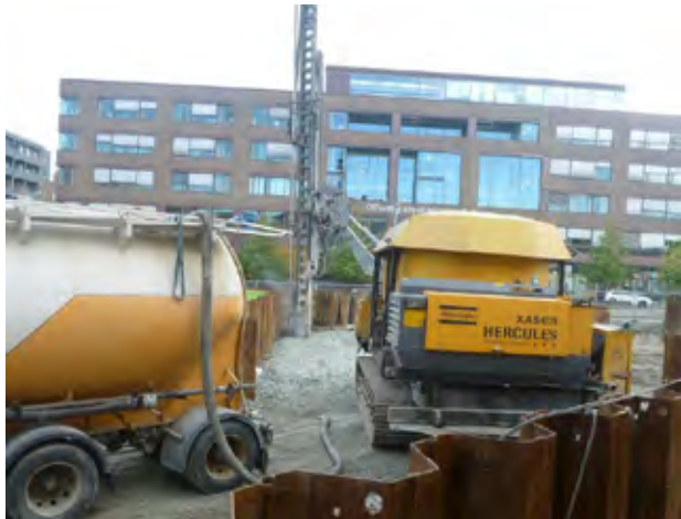
Figur 8 Trinn 3 – Installasjon av kalk-sementpeler
