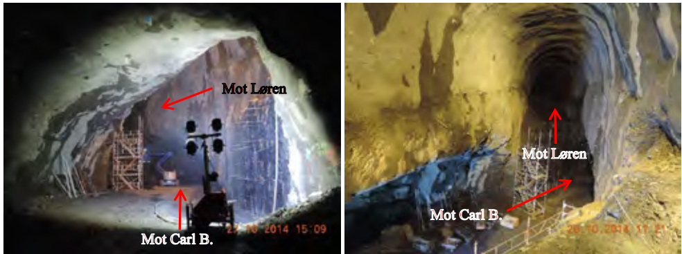
Figur 24 Tilrigging for betongarbeider – bro over Centrumstunnelen.
