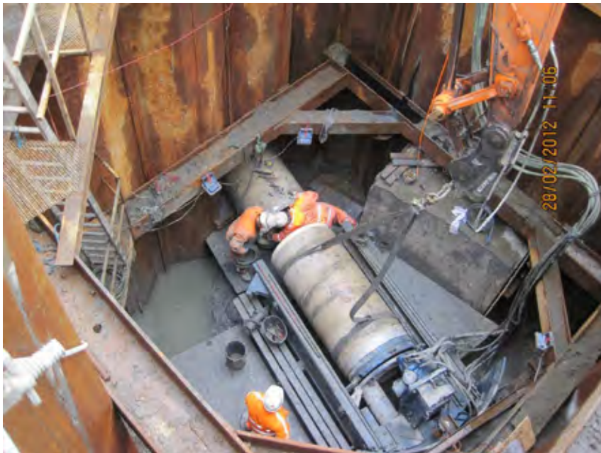
Figur 5 Sjakt S26 ved Tollbugata. Røret kobles sammen med det foregående og gjøres klart for pressing mot sjakt S3.
