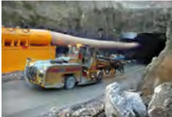
Figur 8. Forskjæring og påhugg.
