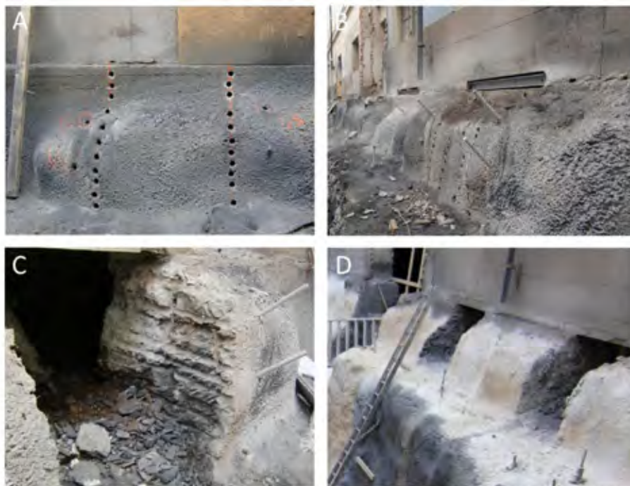
Figur 12: (A) Kanal klar til pigging etter boring av horisontale sømhull. (B) Sikring av sidevegger, utveksling under fundament. (C) Ferdig pigget kanal. (D) Ferdig sikrede kanaler, påføring av membran undervegs.
