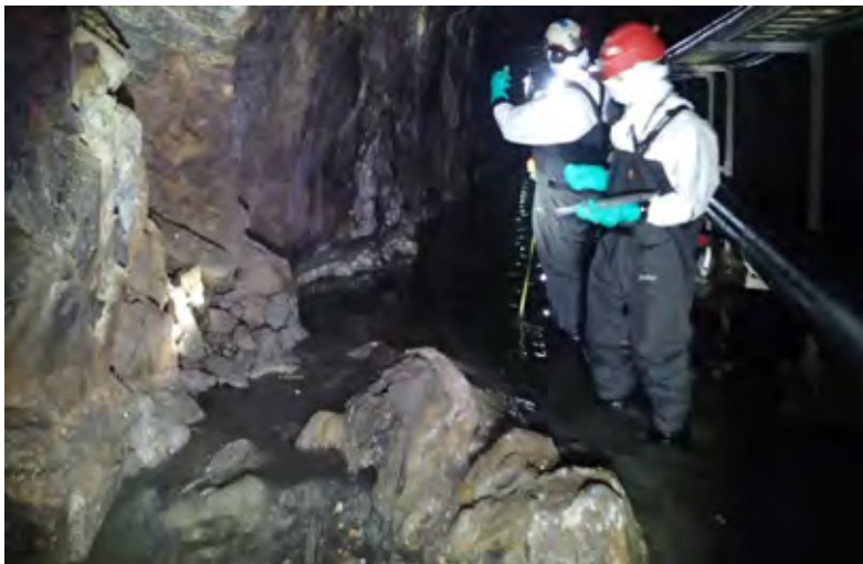
Foto 5 Registrering av sone med blokkutfall
