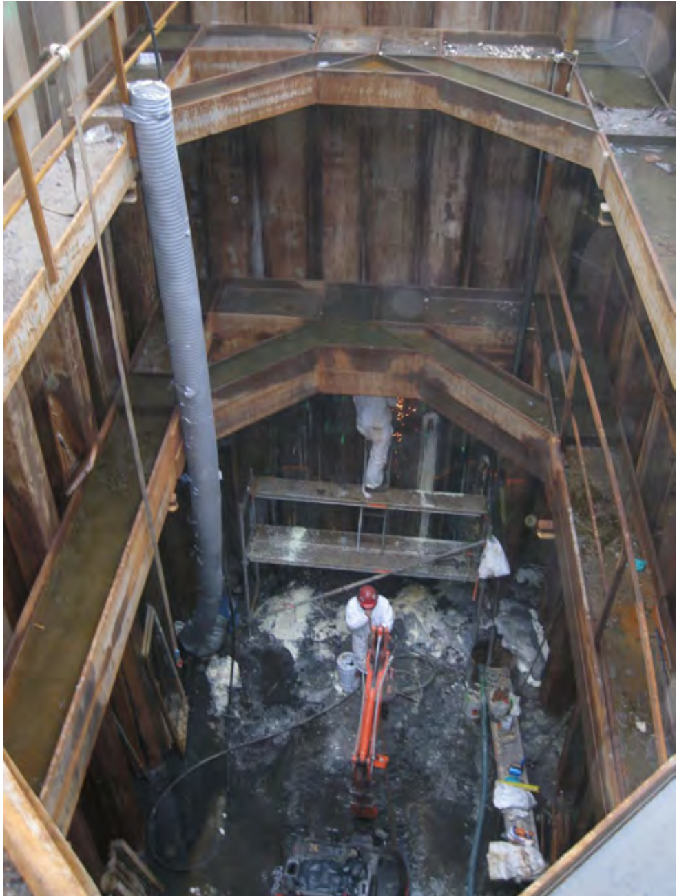
Figur 7 Sjakt S4. Dybde 9,9 m.
