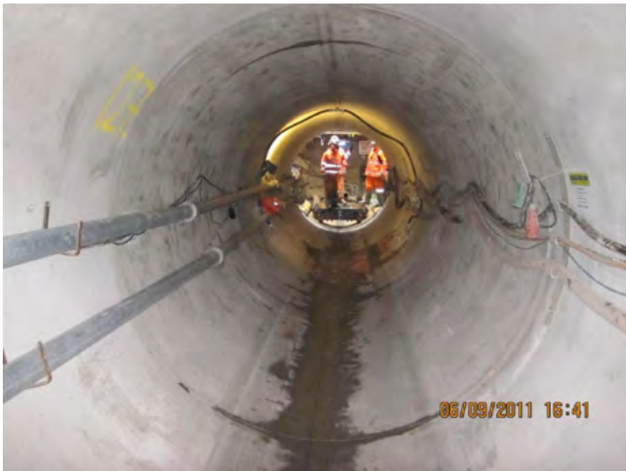
Figur 33 Midgardsormen mellom S9 og S7 med trykkluse og mannskaper innerst. Rørdiameter 2,4 m.
