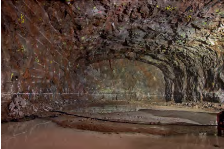
Figur 8-Resultat efter sprängning i experimenttunneln TAS08. Tunneln är idag förstärkt med sprutbetong.
