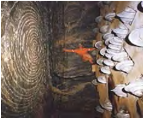
Figur 22. TBM under arbeid i Fløyfjellstunnelen i 1984..
