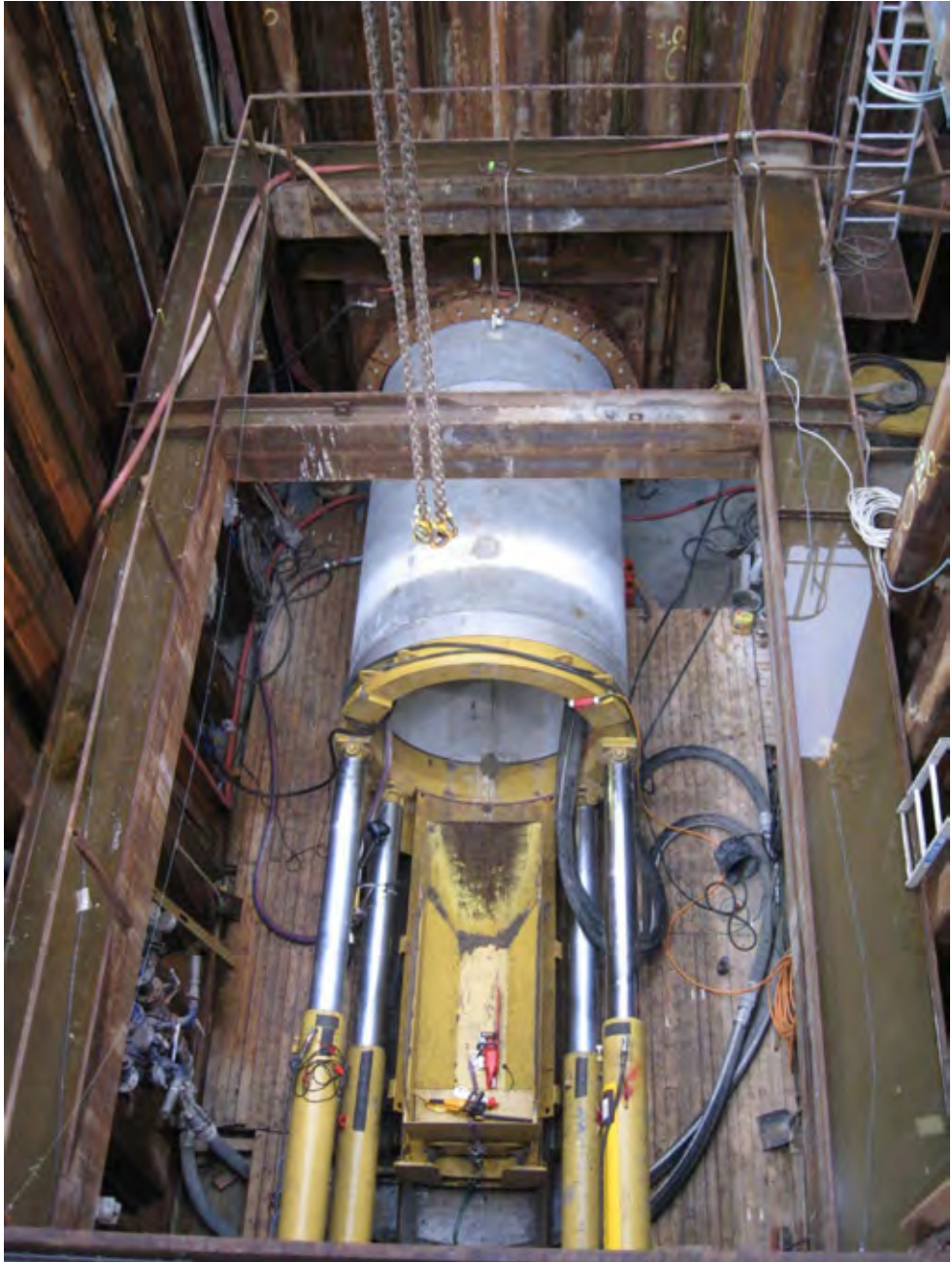
Figur 19 Spuntgrop S6 med hydrauliske jekker for pressing mot S4. Rørdiameter 2,0 m.
