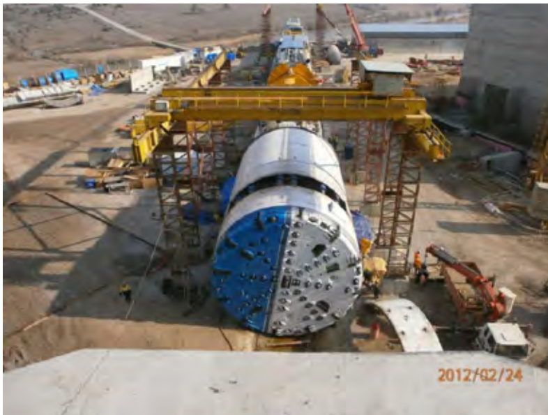
Foto 3 TBM under sluttmontasje
