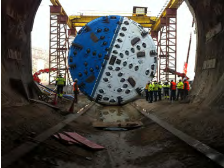
Foto 4 TBM på vei inn i tunnelen
