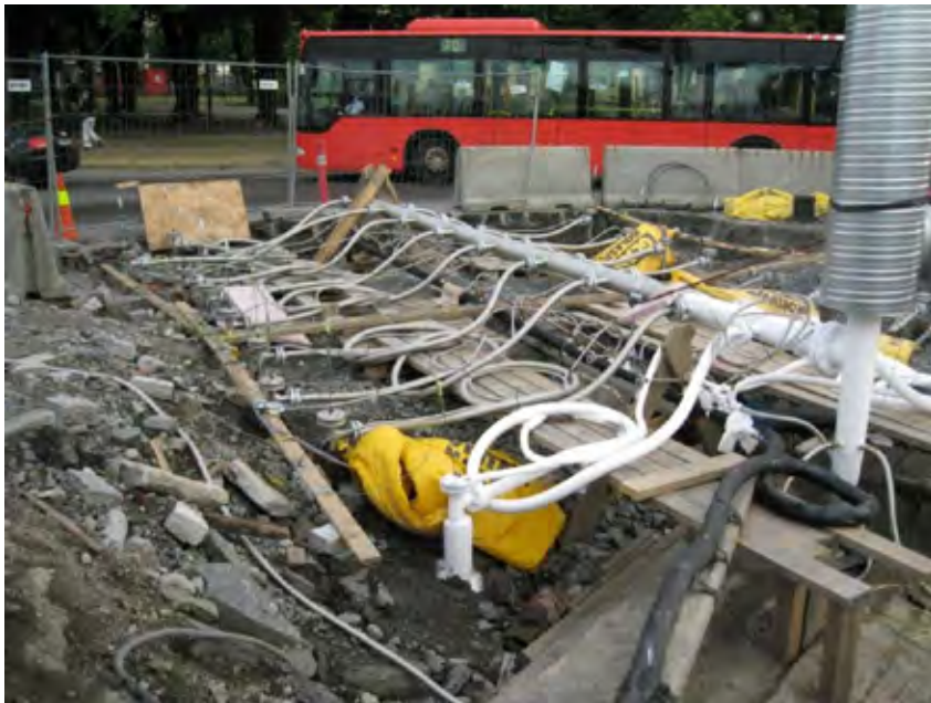
Figur 13 Grunnfrysing ved sjakt S3 i retning mot S2.
