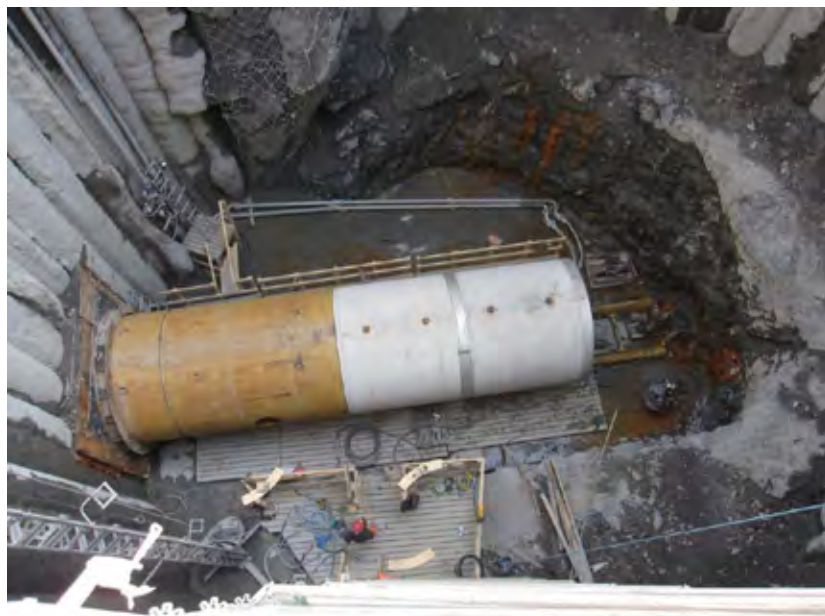
Figur 30 Sjakt S9. Fronten er montert i sjaktveggen og trykklusen er lagt på plass. Største gravedybde var ca. 25 m. I bunnen er det delvis sprengt ut (til høyre i bildet). Herfra går bergtunnelen til renseanlegget på Bekkelaget.
