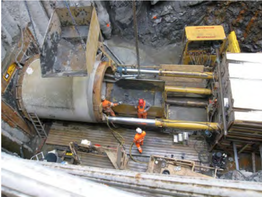
Figur 32 Sjakt S9. Pressing mot S7 pågår. Merk skuffene for materialtransport.
