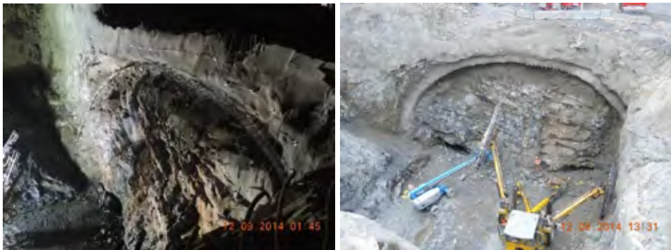
Figur 14 «Rulletrappsjakta» - toppen av de to pilottunnelene skimtes i bunn
