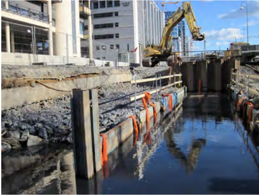
Figur 22 Rørlegging mellom sjakt S4 i bakgrunnen og S3. Dykkerne som monterte rørene hadde null sikt, og alt arbeidet måtte skje ved at de følte seg frem.
