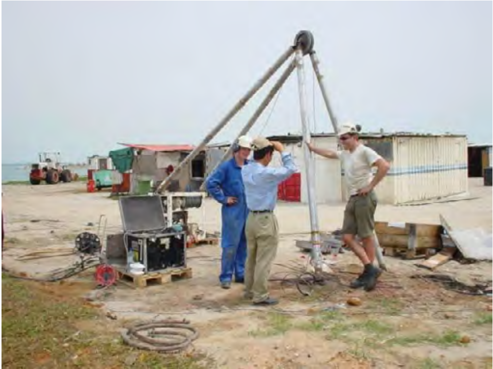
Figur 4 Utførelse av hydraulisk splitting (SINTEF Byggforsk)
