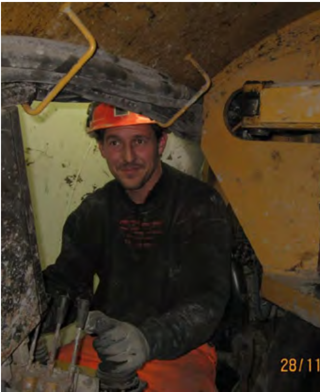
Figur 26 Operatør som betjener gravemaskinen. Han styrer frontens bevegelser, inkl. de fire styresylindrene og portene som kan stenges for å holde massene ute.
