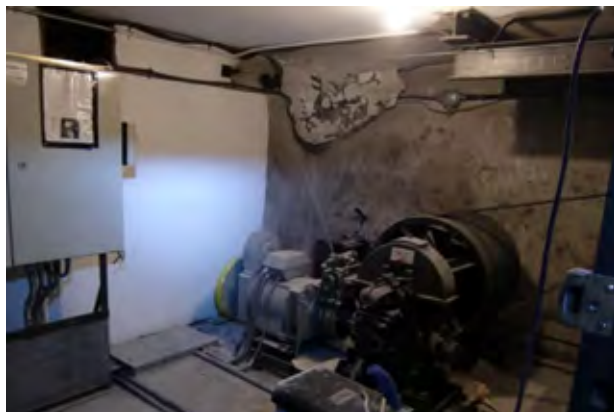
Figur 14: Kunstindustrimuseets heismaskinrom etter mislykket prøvegraving i etasjeskiller.
