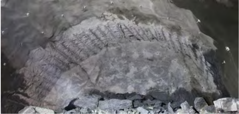
Figur 5 Bilde tatt før lasting. Slett kontur. Alle borpiper synlige. Lav røys.
