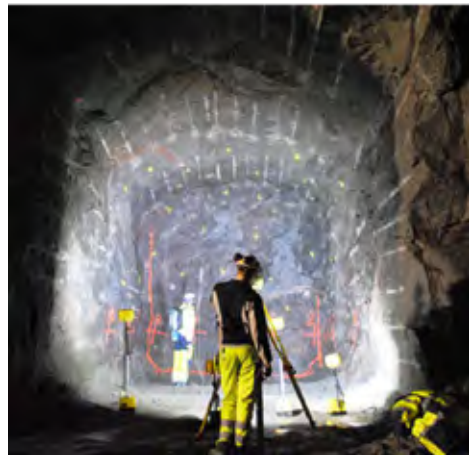
Figur 5-Exempel på visualisering av MWD-data från borrhoggen och inmätning av borrhålsbottnar under projektet.
