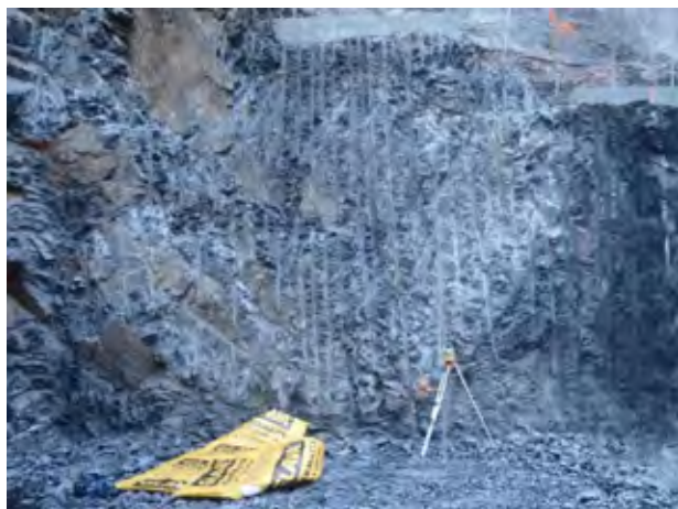
Figur 2: Foldede skifre i skjæring i en nærliggende byggegrop.
