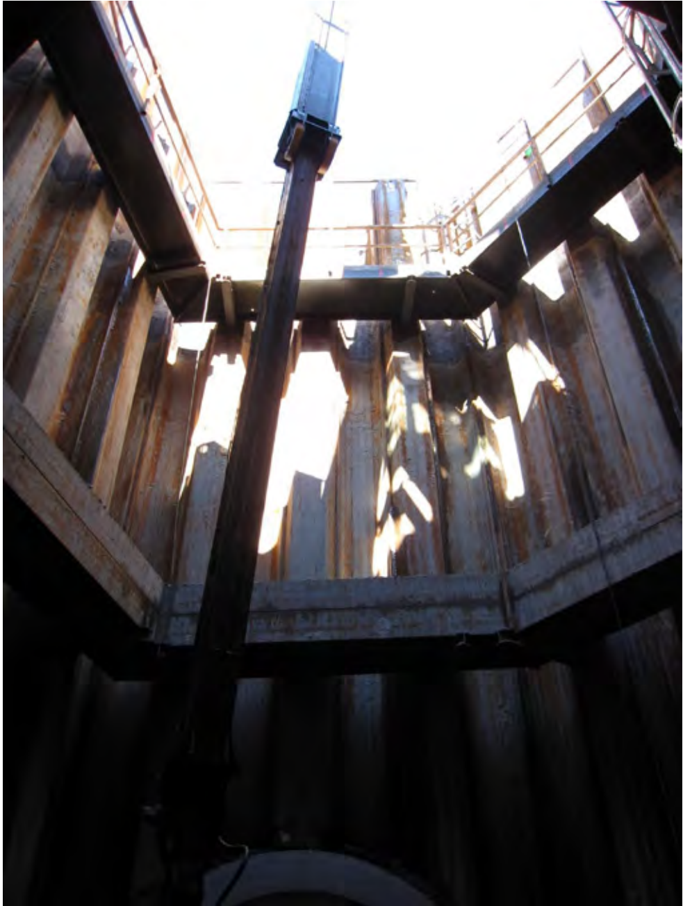
Figur 6 Sjakt S7. Gravedybde 15,8. Sjakten er mottakssjakt for røret fra hhv. S6 og S9.
