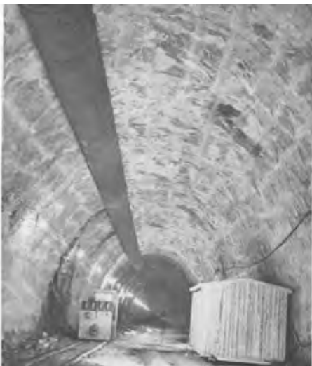
Figur 4: Tunnel på Tokkeanlegget i 1960-årene
