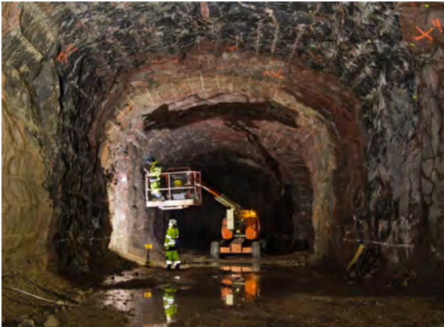
Figur 9-Resultat efter sprängning i huvudtunneln TASP. Bilden visar utsättning av selektivbult. Tunneln är idag förstärkt med sprutbetong.
