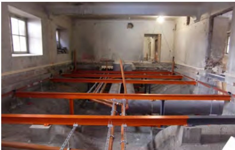
Figur 9: Ferdig etablert bæring for nytt dekke.
