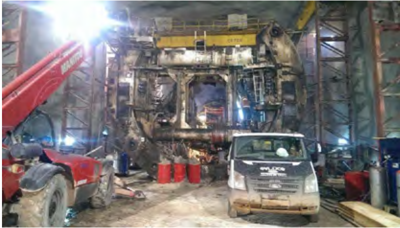
Demontering av TBM
