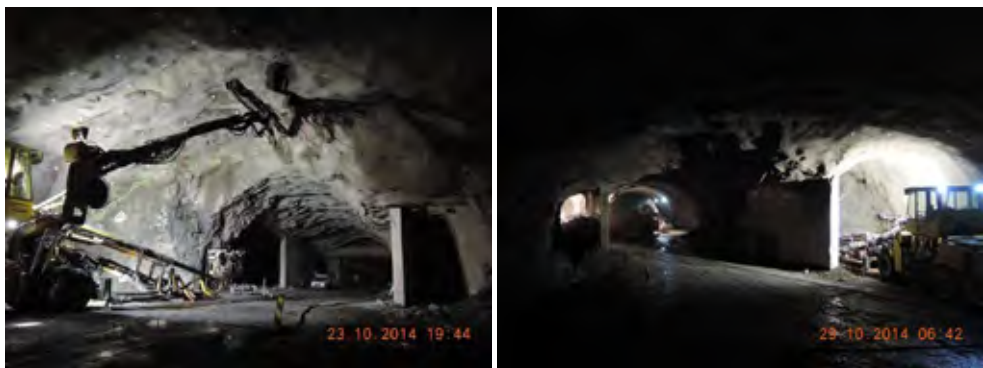
Figur 20 Betongvegg i utvidelsen fra Centrumstunnelen
