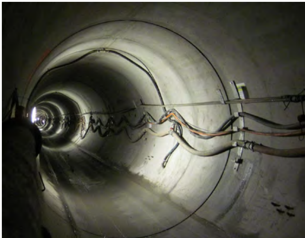
Figur 34 Midgardsormen i retning fra S9 mot S7. Merk at røret har en sving til høyre.
