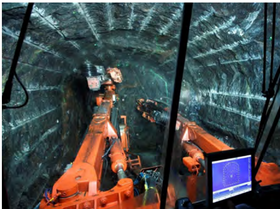
Figur 10-Borrning i TAS04 under utbyggnadsprojektet.
