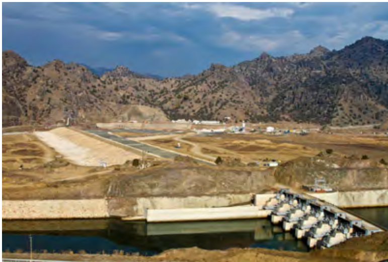
Foto 2 Kargi, inntaksområde, dam og flomløp
