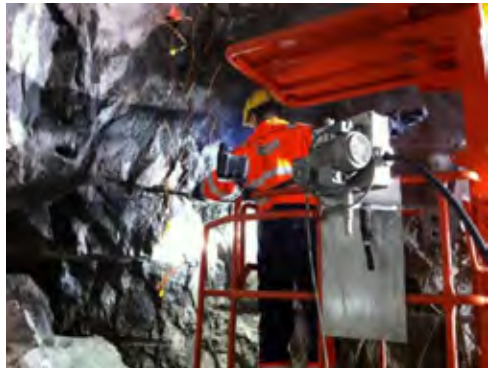
Figur 3-Forcit Laddenhet 201 och laddning med slangdragare i TASJ.
