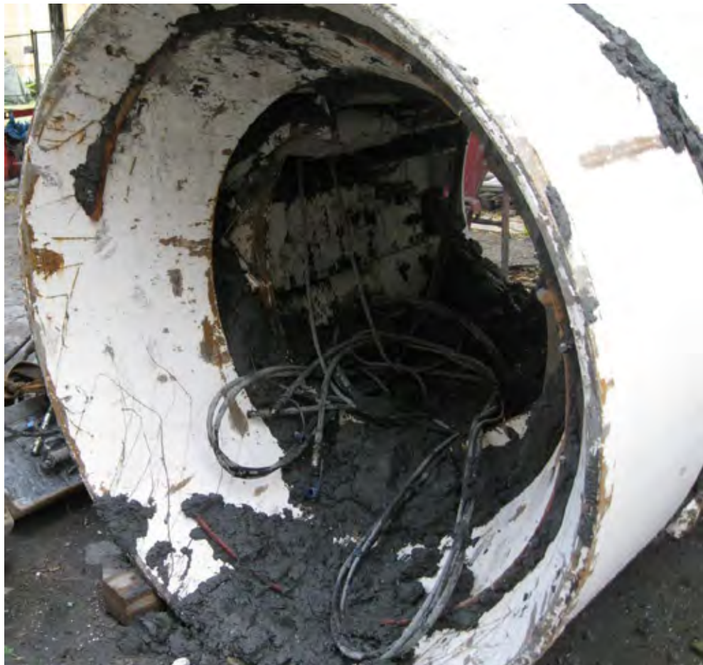
Figur 24 Fronten på maskinen brukt mellom S2 og S3. Merk innsvringen av tverrsnittet.
