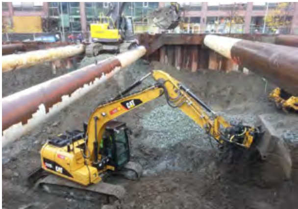
Figur 9 Trinn 5a/5b - Utgraving
