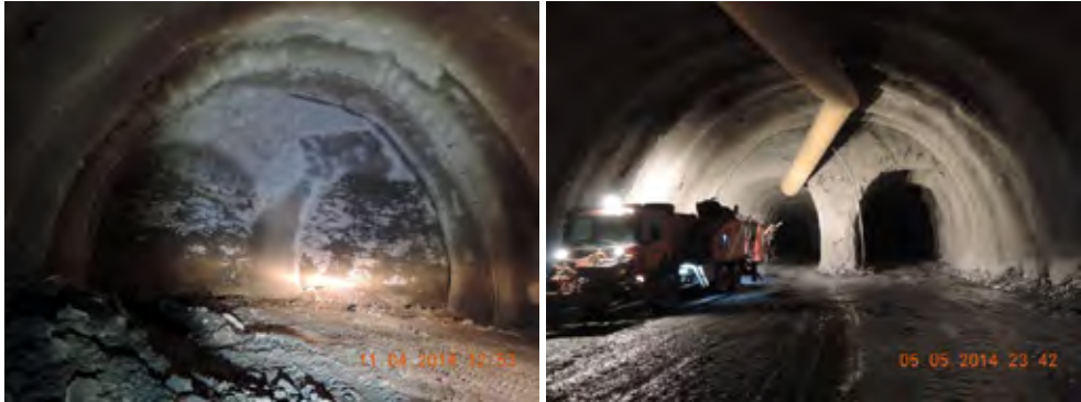
Figur 21 Dobbeltarmerte sprøytebetongbuer i overgangen dobbeltspor/enkeltspor
