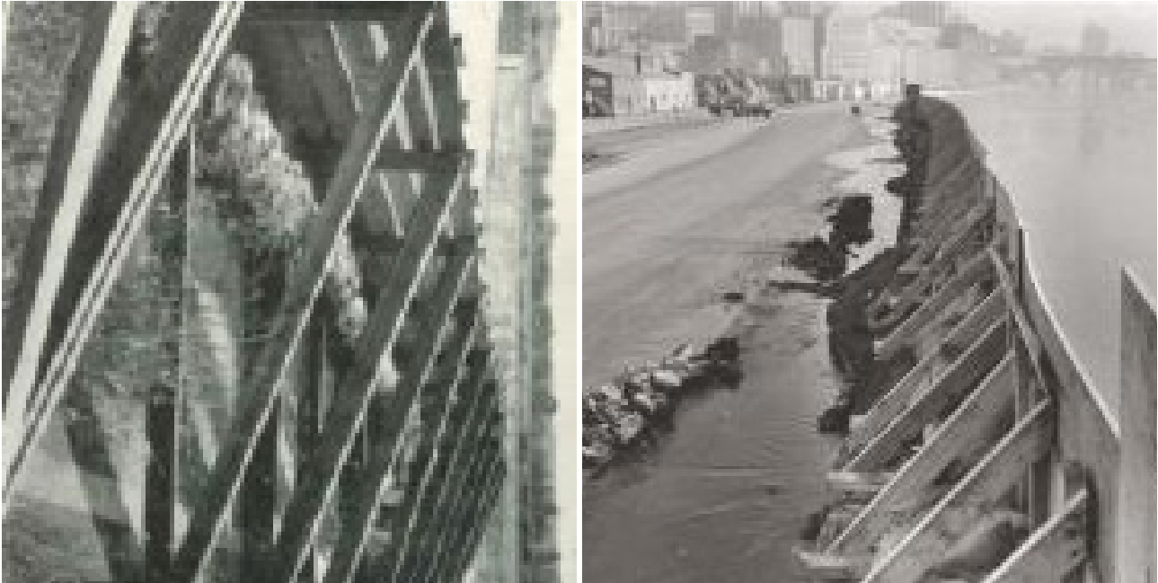
1-2. sz. képek: Faácsolatú fóliás ellennyomó medence a Mohács alatti Duna szakaszon Forrás: Nagy Dunai Árvíz 1965. Vízgazdálkodás melléklete 1966, és a Szent Pál folyón Amerikában (Pioneer Press file: St Paul's Shepard road 2011. 03. 15-16.)
