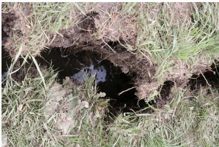
66. kép: A koronán a húzási repedésben azonnal megjelent a víz
