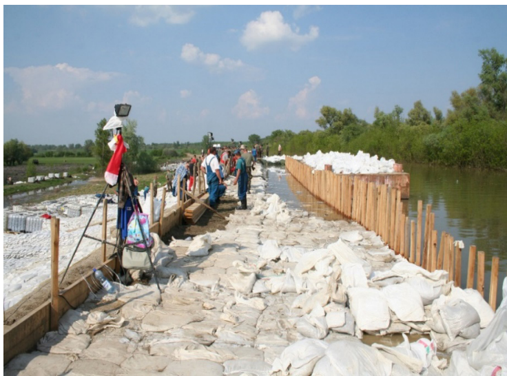
69. kép: Vízdali védekezés oldalsó megtámasztással
