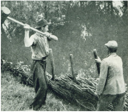
29. kép: Futó rőzsesor készítése a víz színére
