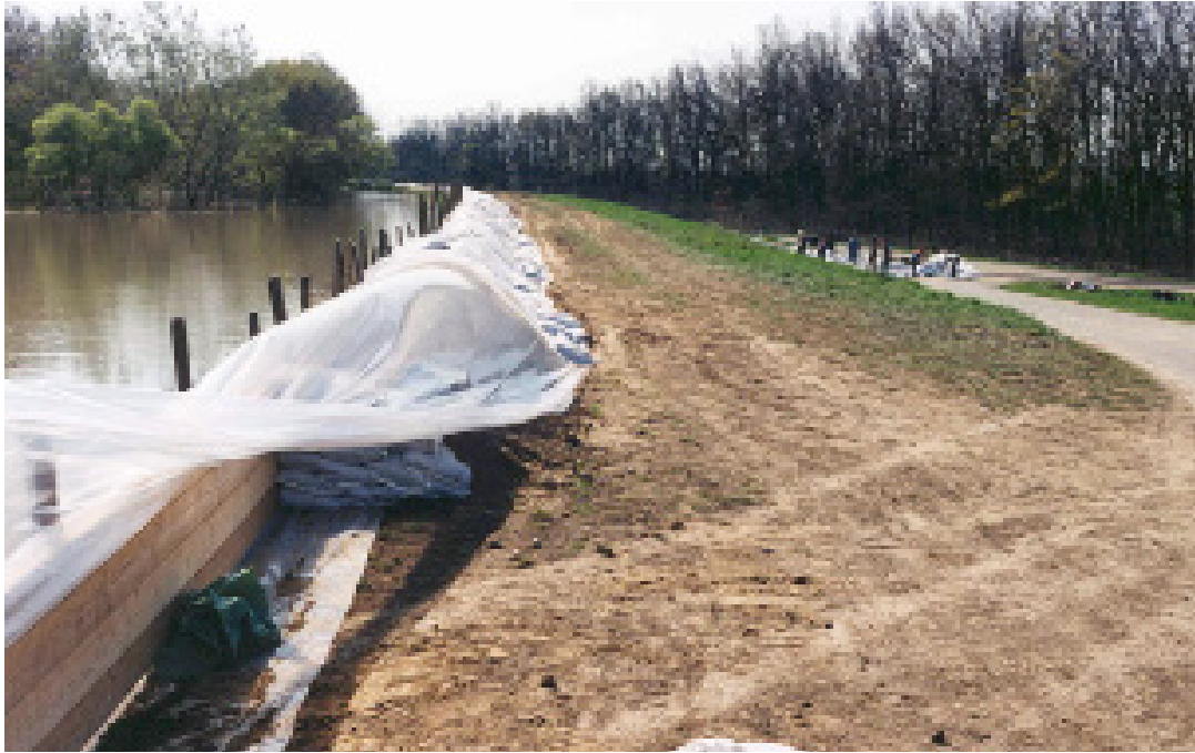
11. kép: Négy palló magasságú nyúlgát épül 2000-ben Tisasülynél
