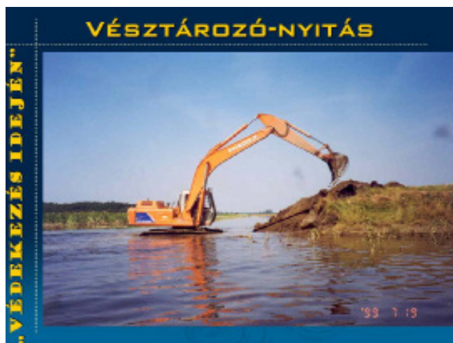
Véztározónyitás kotróval 3.
