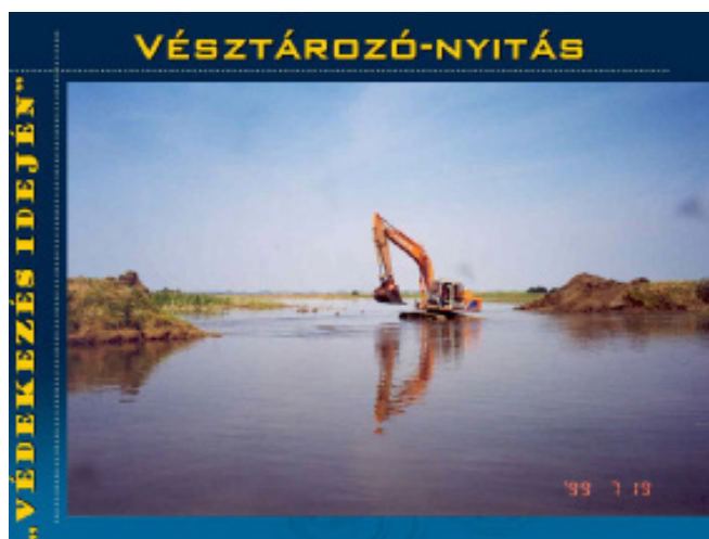
Vésztározónyitás kotróval 2.
