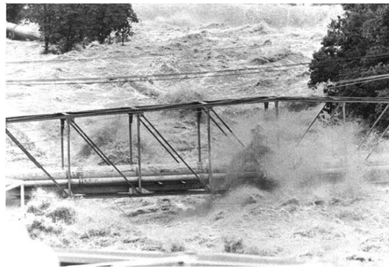
109. kép: A víz nyomására a híd leugorhat a sarukról, el is viheti a hidat a víz
