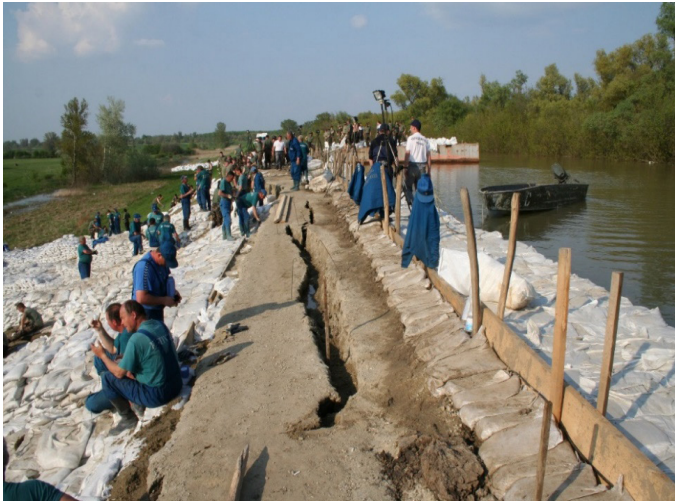
73. kép: A korona elvékonyodása a folyamatosan hátrarágódó suvadásnál.
