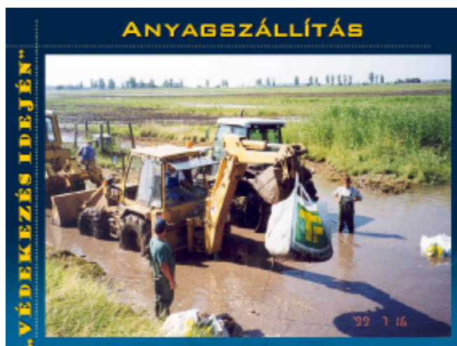
Anyagszállítás fakadóvízes töltéselőtérben 1.
