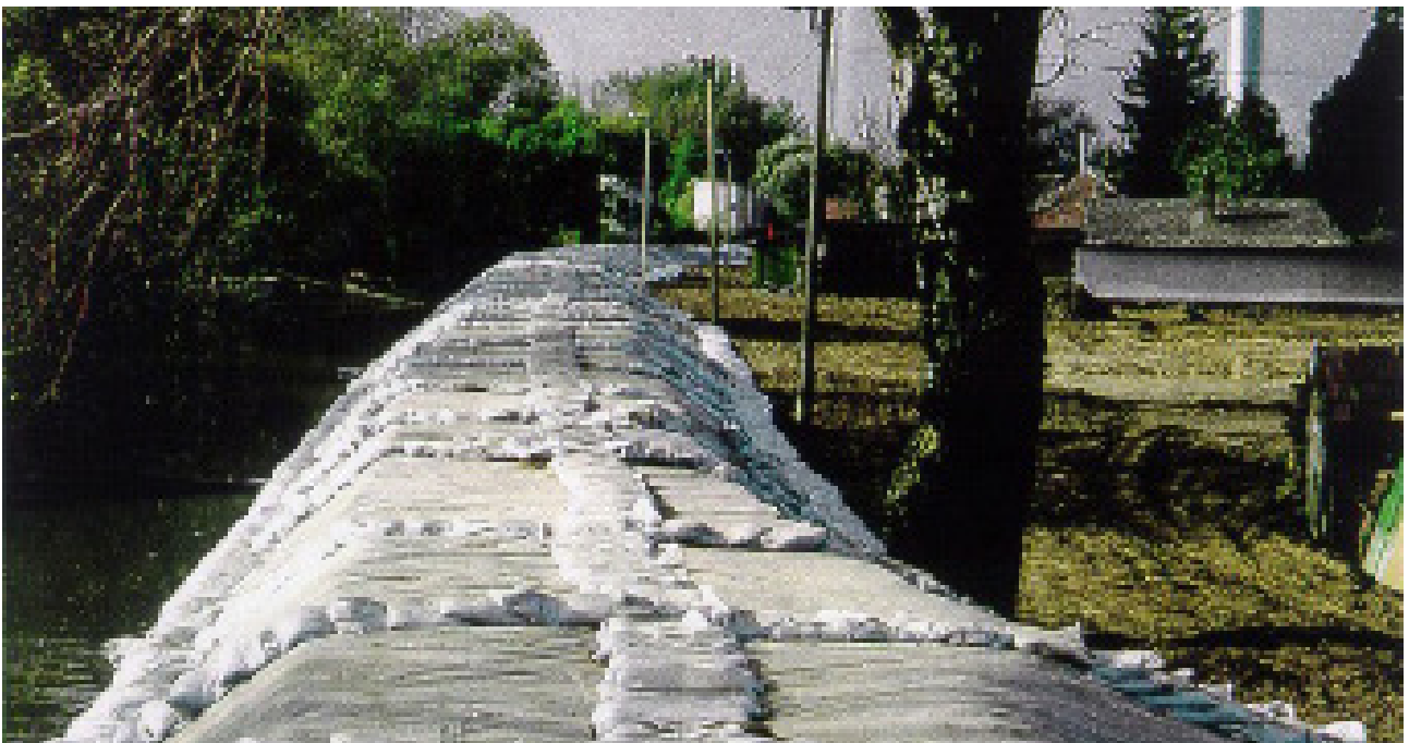
16. kép: Árvizvédelmi fal magasítása Szolnokon 2000-ben
