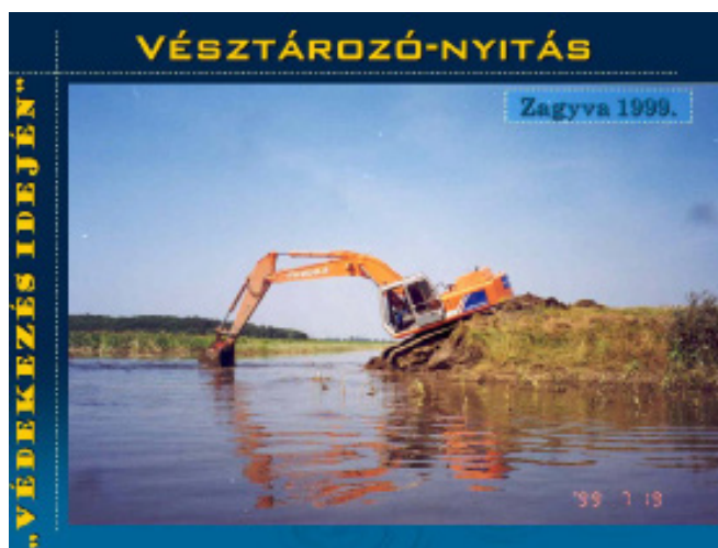
Vésztározónyitás kotróval 1.
