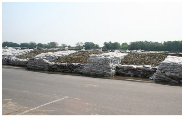
72. kép: Bordás megtámasztások köze zúzottkővel feltöltve Szentendrén (kőszekrény)
