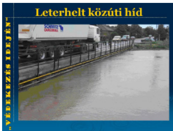
Leterhelt közúti híd
