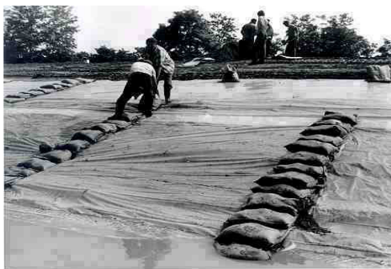
38. kép: Rézsűburkolat épülő fólia védelemmel
