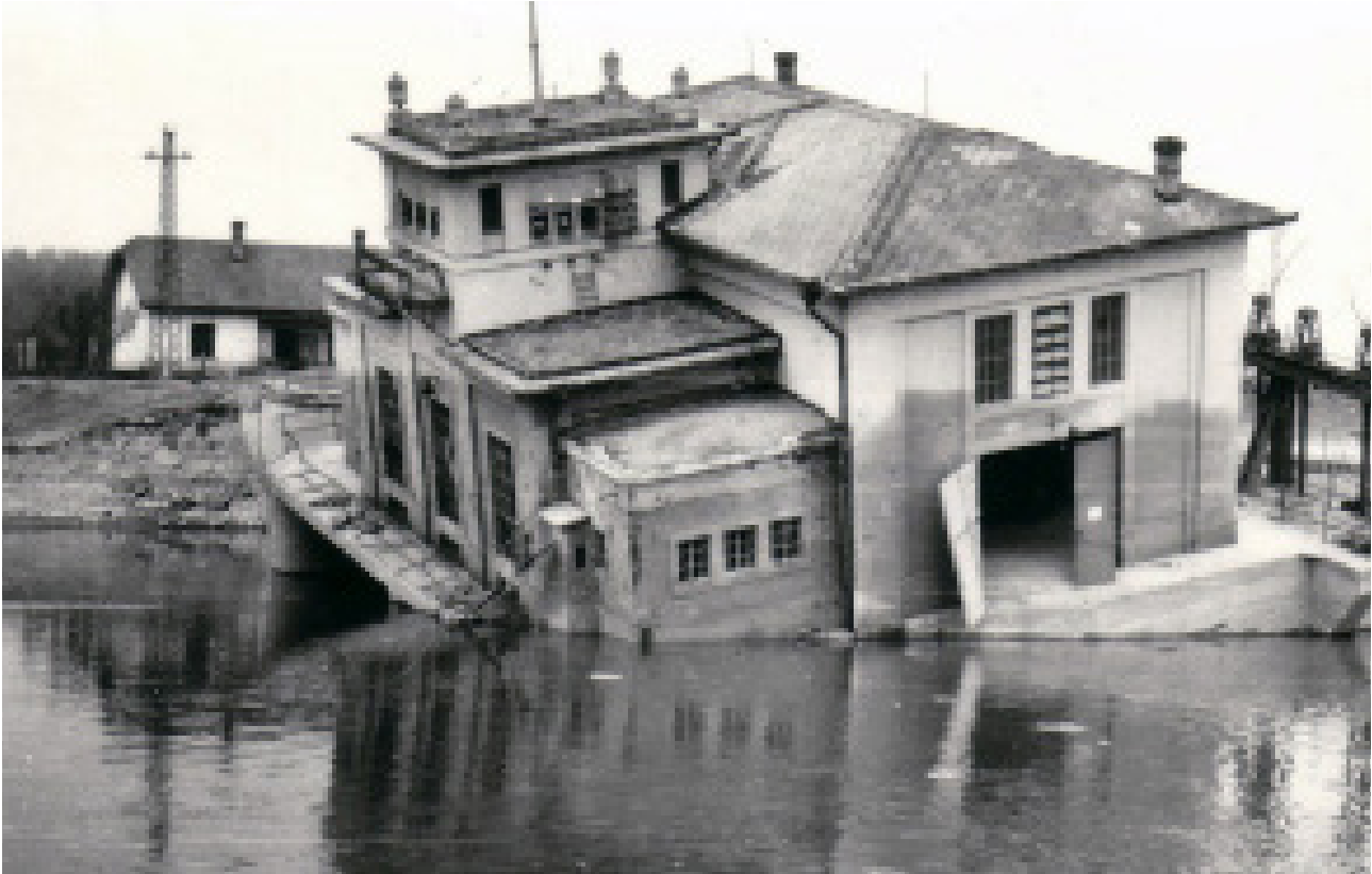
104. kép: Gátszakadás az 1956. évi árvíznél a Tassi zsilip mellett. A Soroksári Duna-ágból kifolyó víz alámosta a zsilipet is. A műtárgynak olyan erős vasbeton alaplemeze volt, hogy a helyreállításnál felmerült a visszabillentés lehetősége.
