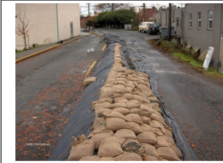
9. kép: Kellően át nem gondolt helyre épített homokzsákból készült nyúlgát (lehetetlenné teszi a mindkét irányú forgalmat)
