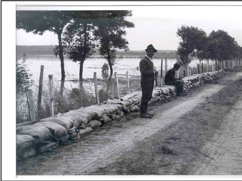
10. kép: Nyúlgát vízoldali pallófallal az 1932. évi tiszai védekezésnél
