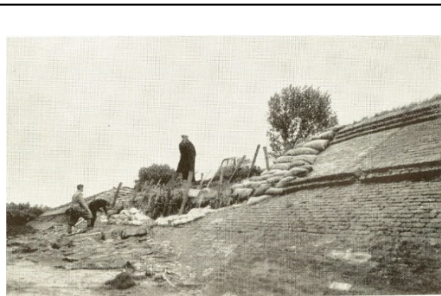
25. kép: 1940. áprilisi orkán hatása a téglá rézsűburkolatra Tiszaderzsnél. Jól azonosíthatóak a téglaburkolat több sorban beépített hullámtörői.
