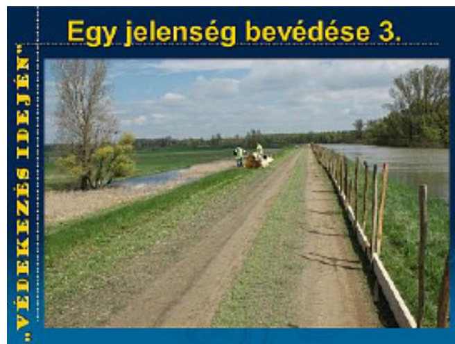
Ideiglenes védmű építésének előkészítése
