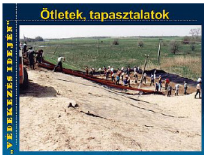
Anyagszállítás töltéscsúszás esetén 2.
