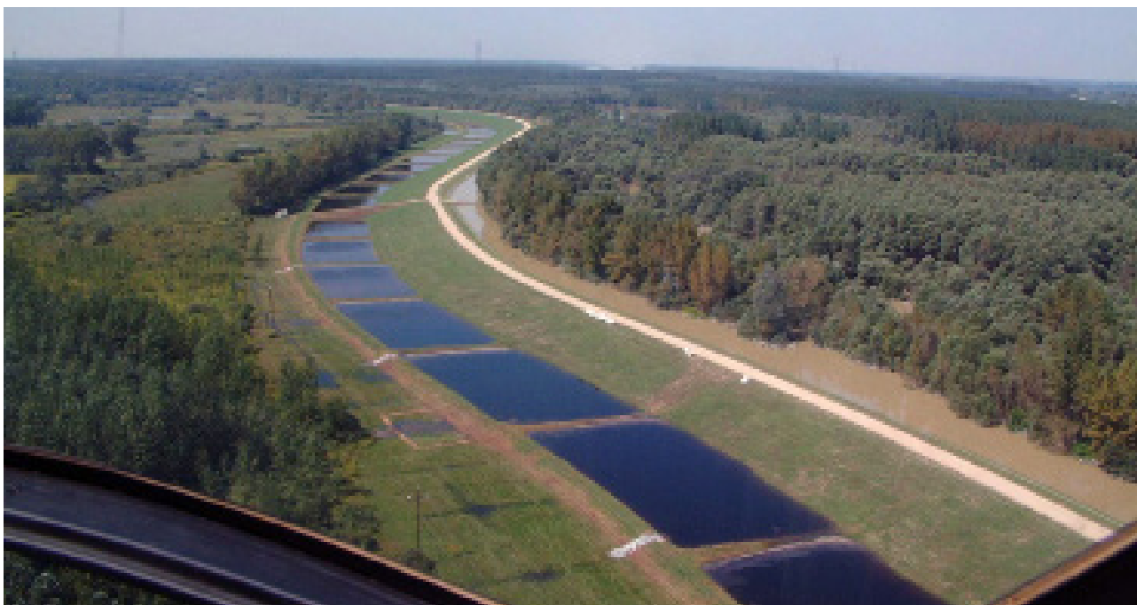
45. kép: A kavics altalaj fakadó vize tölti fel a mentett oldali ellennyomó medencéket a Szigetközben. A kavics altalaj miatt a víz saját maga alakítja ki ellennyomását, védelmét.
