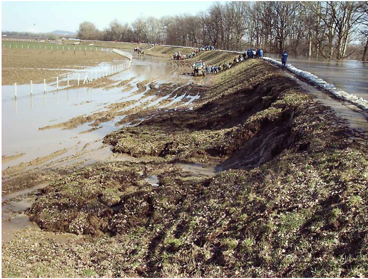
59. kép: Tarpai suvadás 2001-ben. Puha telített talajú rézsű lefolyt a töltéslábhöz és ott legyező-szerűen szétterült.
