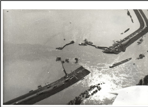
133. kép: Hosszúfoki gátszakadás bezárása acél szádlemezekkel 1980-ban
