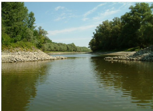
1.14.41. kép. A Vén-Duna mellékága a megnyitott mederelzáró kőgáttal (Duna jobb part, Gemenc)
