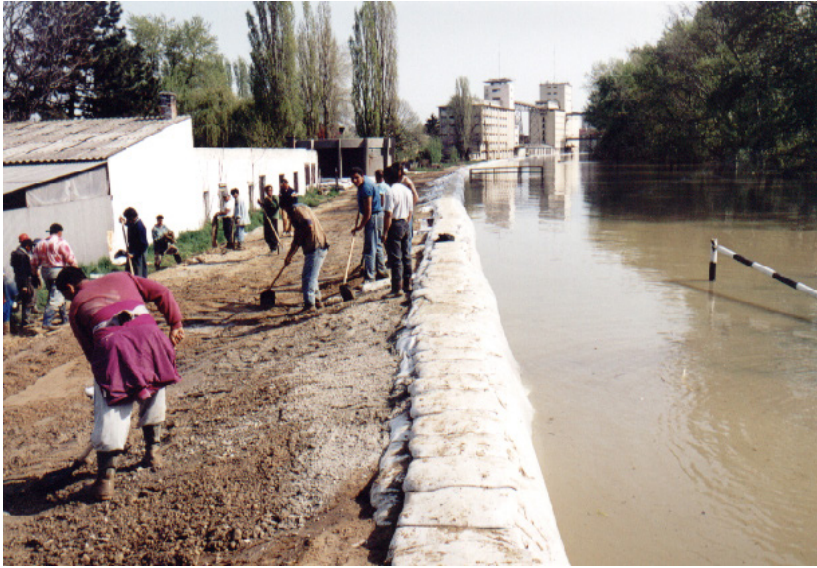
15. kép: Szolnok téglaházi szakasz parapetfal magasítás 2000-ben. A hozzá tartozó metszetet a 11. ábra.
