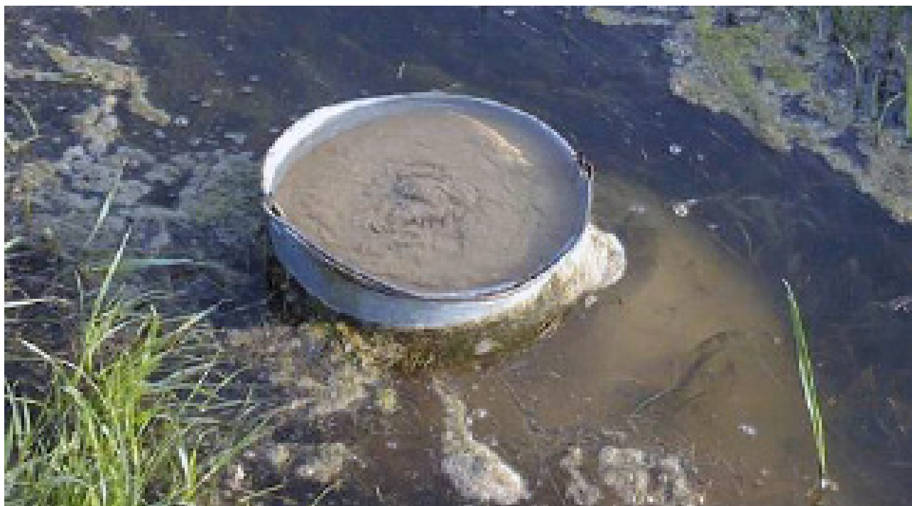
91. kép: Buzgár elfogás vödörrel (nem jó megoldás)
