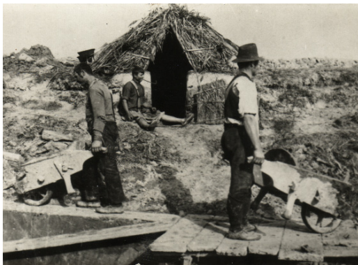
21. kép: Talicskás földszállítás a XIX. sz. végén
