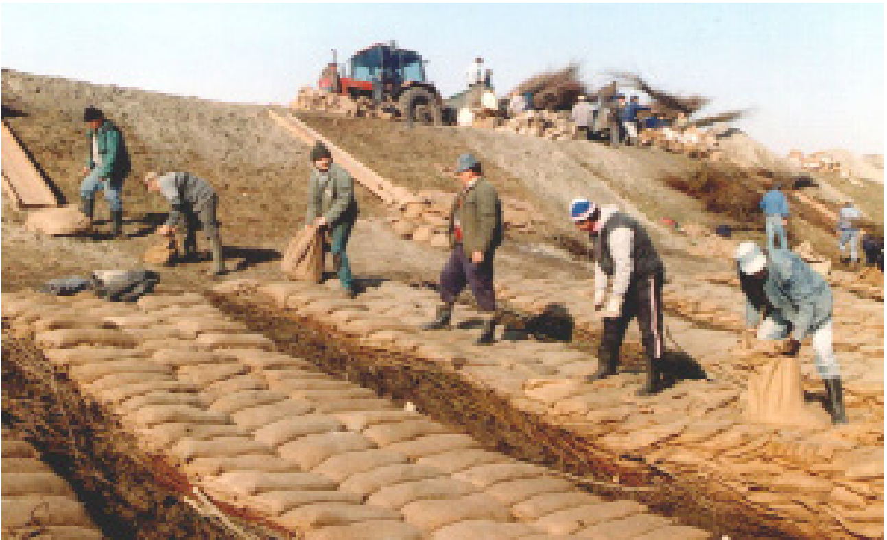
52. kép: Átázott töltésrézsű leterhelése. A víz kifolyásának biztosítására a homokzsák leterhelés rőzsére került.
