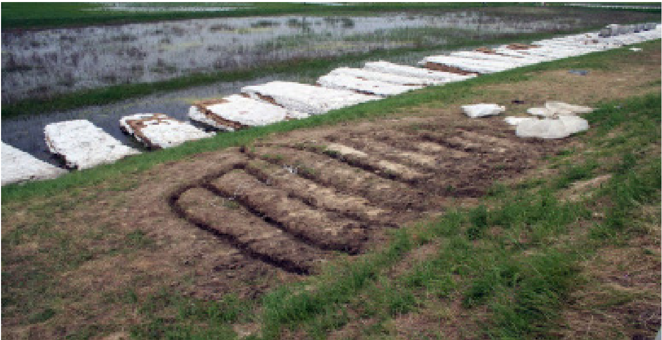
65. kép: A felszínt szárító folyókák, vízkivezetések
