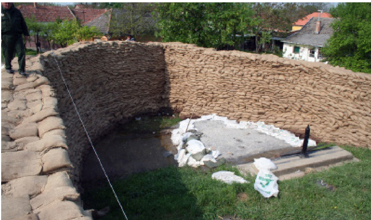
105. kép: Sárkányfarki zsilip bevédése a 2006. évi árvízkor
