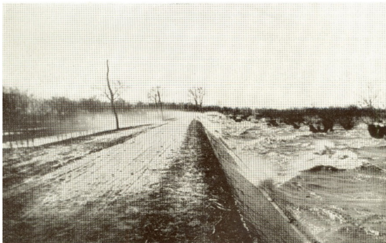
23. kép: A töltés koronán is átcsapó hullámok az 1940. évi áprilisi orkánnál. A vízszint a téglaburkolat hullámtörőjéig ért.
