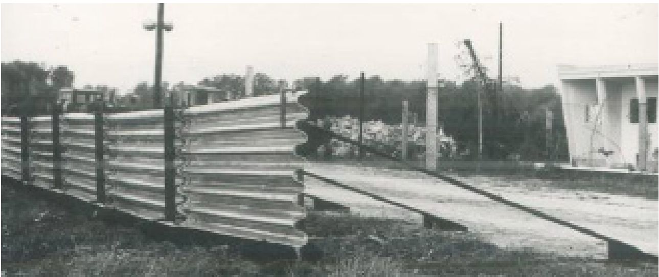
3. sz. kép: ARMCO hullámosított lemezekből álló árvízvédelmi fal az ÁBK SZ telephelyén Forrás: Árvíz és Belvízvédelmi Központi Szervezet (ÁBK SZ) gépészeti szakszolgálat
