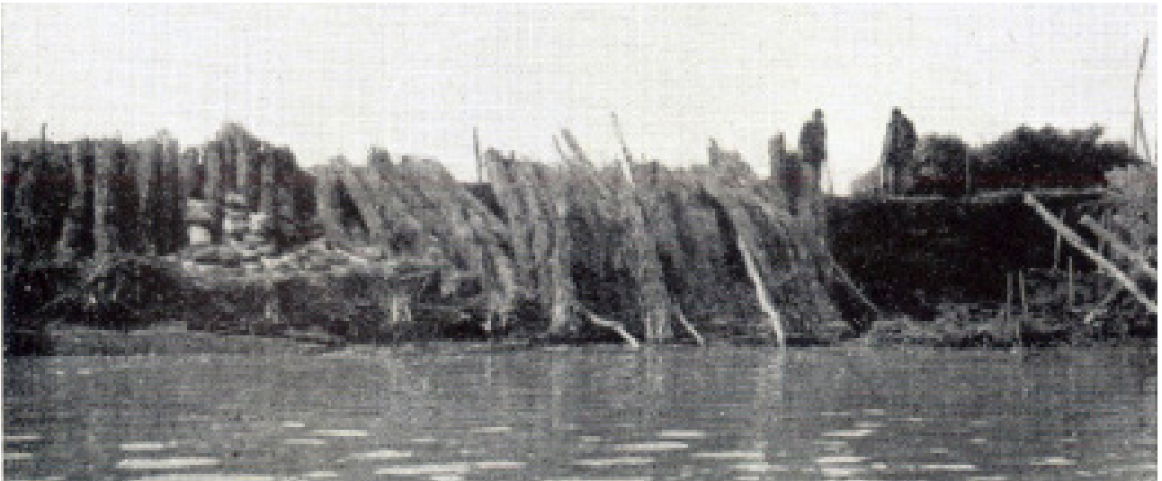
41. kép: Elhabolt rézsűjú gátat rőzsekévék belógatásával próbálták megóvni a gátszakadástól
