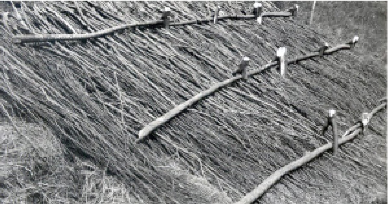
28. kép: Hullámvédő rőzse fekvőmű (fekvő rőzsepokróc) egy árvízvédelmi gyakorlaton. A rőzse alatti szalma (a korabeli szűrőszövet) a talaj erózióját akadályozta meg.
