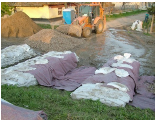
71. kép: Zúzottkő leterhelés készítése: a kő alá helyezett geotextíliával lehet megakadályozni az altalajba történő benyomódást
