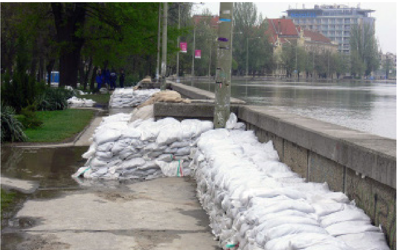
103. kép: Kulisszanyílások védelme 2006-ban Szegeden
