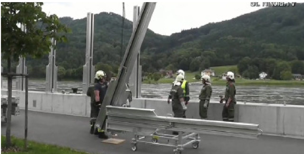
6. sz. kép: Több mint három méter magas mobil árvízvédelmi fal építése Forrás: Geriner Hochwasserschutz, St Nikola TV adás 2013. június 1-jén
