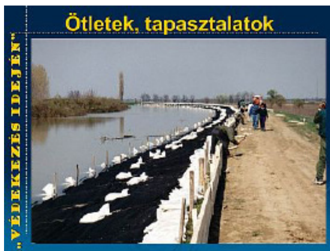
Jászolgát és hullámverés elleni védelem
