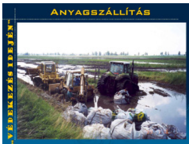
Anyagszállítás fakadóvízes töltéselőtérben 2.
