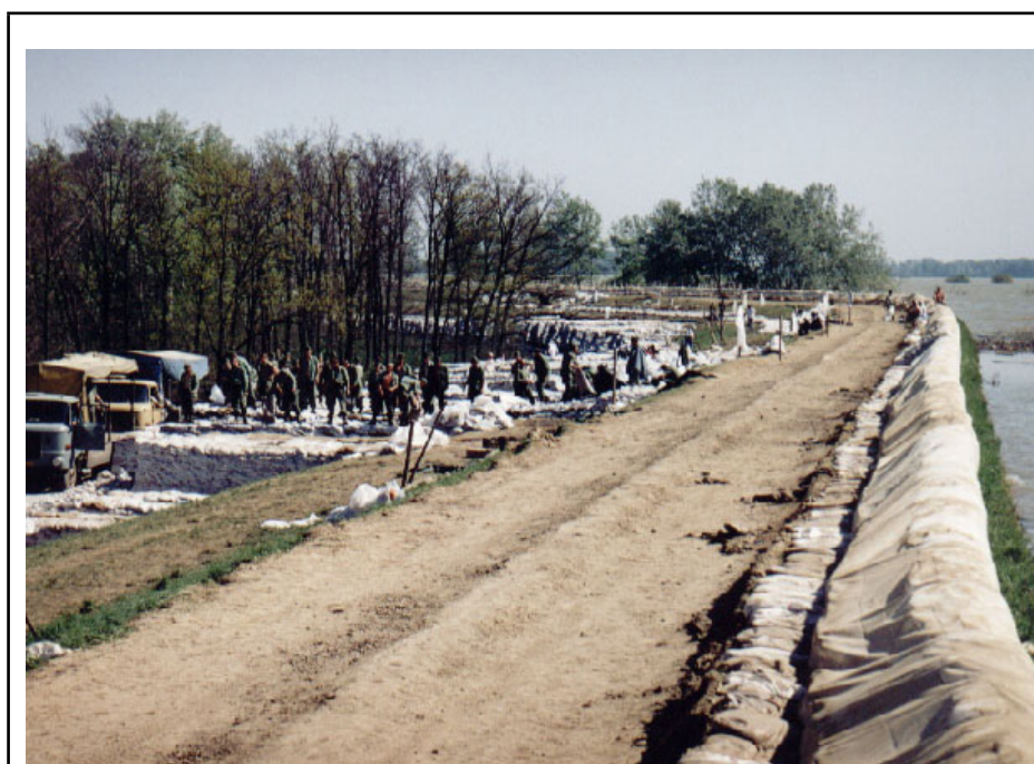
8. kép: Homokzsákból készült nyúlgát fóliával védve
