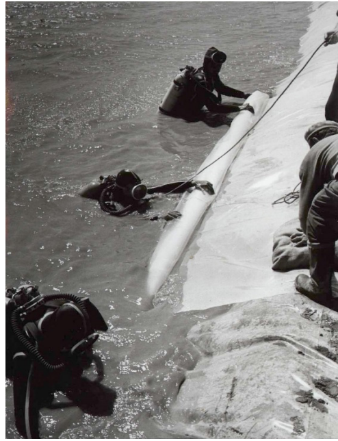
55. kép: Csurgás befolyó nyílásának műanyag fóliával való leterítése az 1970. évi Tisza árvíznél
