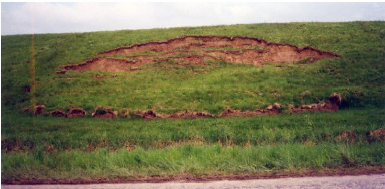
63. kép: A Szamos fenntartótöltés suvadása szemből
