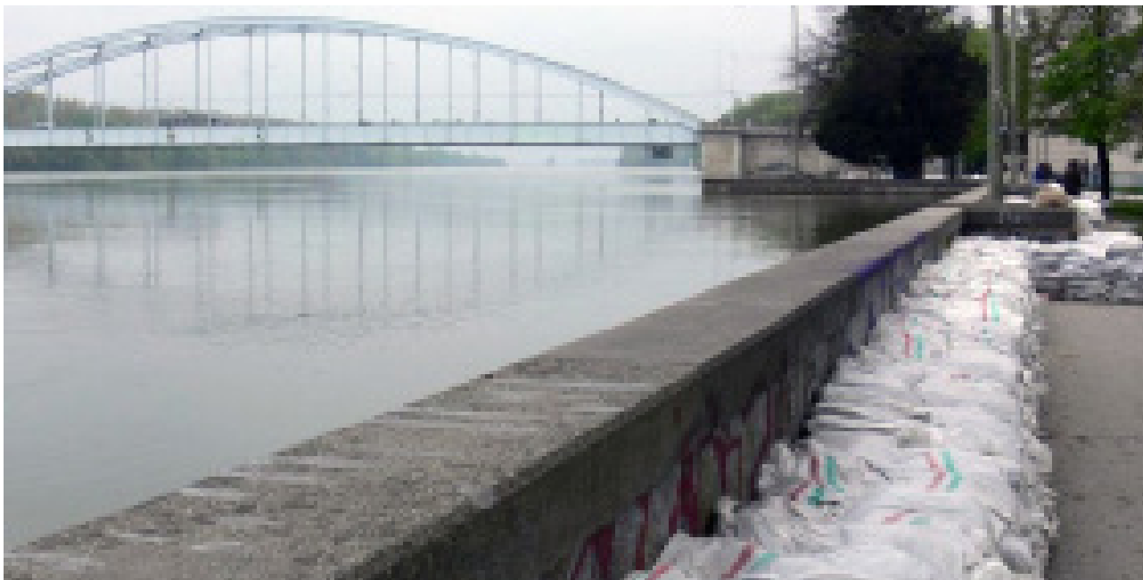
100. kép: A szegedi partfal megtámasztása 2006-ban
