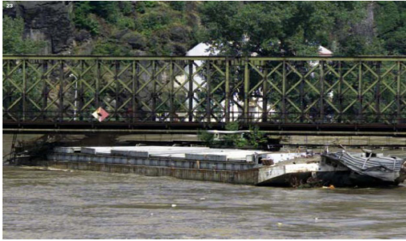
108. kép: Elszabadult hajó az Elbán 2002-ben beszorult a híd alá, nemcsak az acélszerkezetet, de a hídpillért is veszélyeztette
