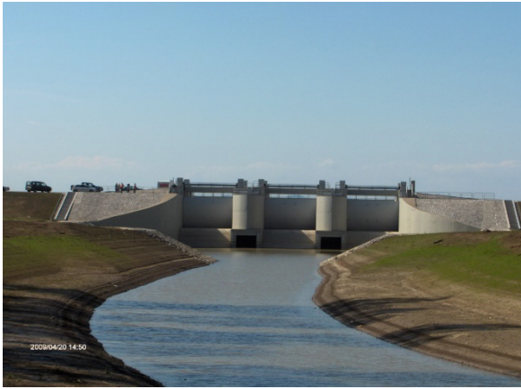
9. kép: A Cigánd-tiszakarádi árvízi tározó feltöltő műtárgya
