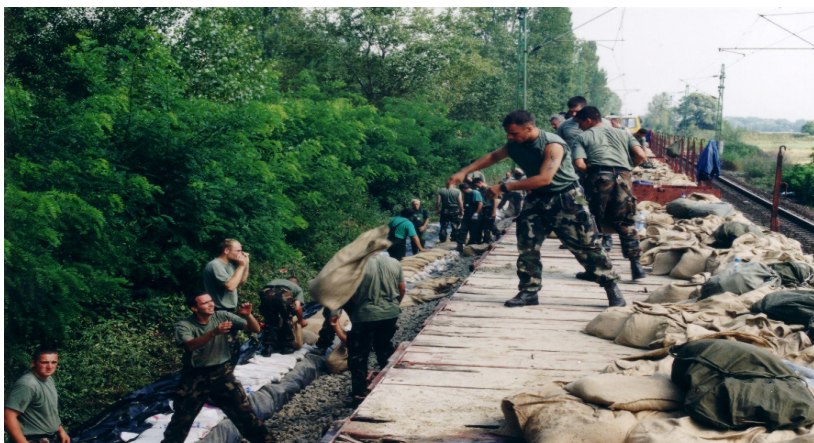
107. kép: Vasúti pálya védelme a Komárom – Almásfüzitő szakaszon. Azon kevés helyek közé tartozik, ahova a védelmi anyagot vasúton célszerű szállítani.
