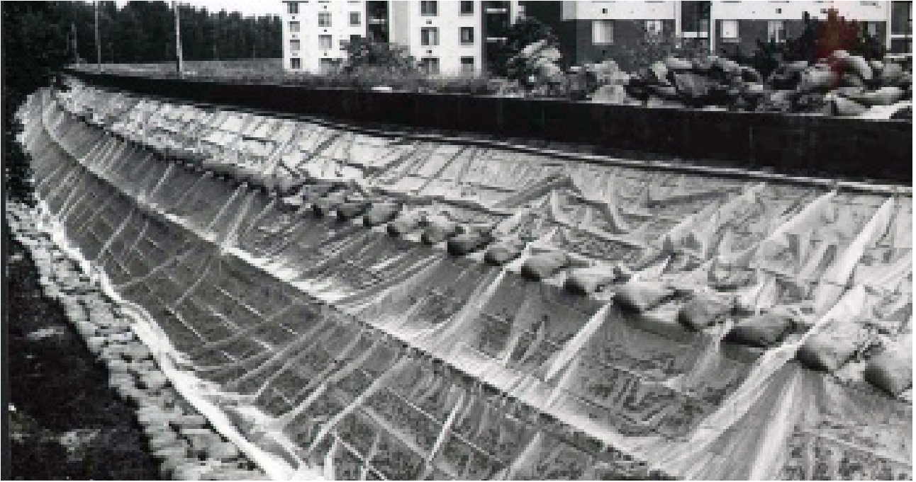
40. kép: Téglaburkolatú rézsű megelőző hullámvédelme (Szeged, 1970)
