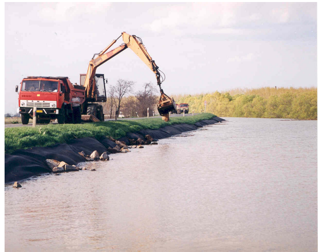
35. kép: Hullámvédelem geotextília terítése kő leterheléssel
