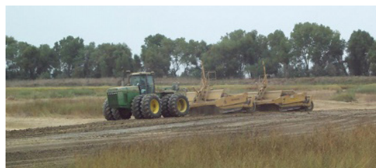
25. képek. Terület előkészítés földtolóval és nyesés földnyesővel
