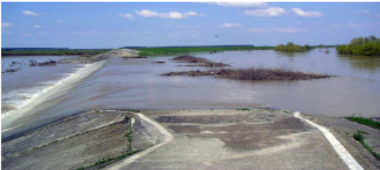
21. kép: Üzemben a fix bukós tamáshidai árvízi szükségtározó
