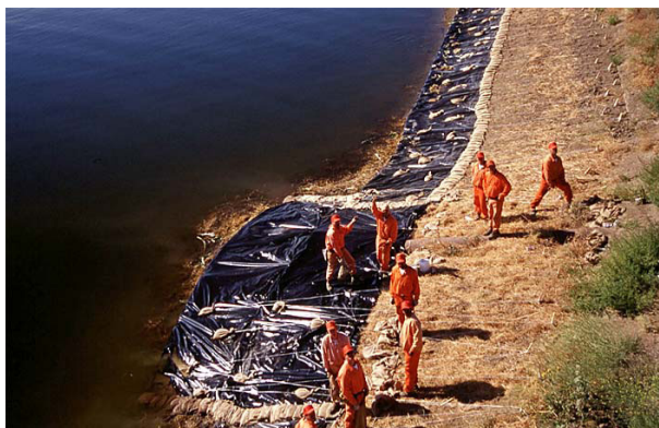
36. kép: Hullámvédelem fóliával (Kalifornia, 2001). A fólia leterhelése belógatott homokzsákokkal
