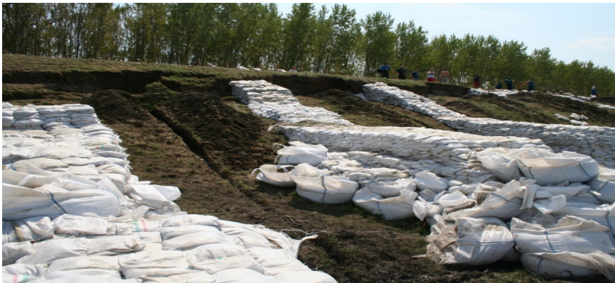
75. kép: Helytelenül kialakított megtá-masztás, amiből leterhelés lett. Ennek is köszönhető a talaj kigyűrődése a mentett oldali lábánál
