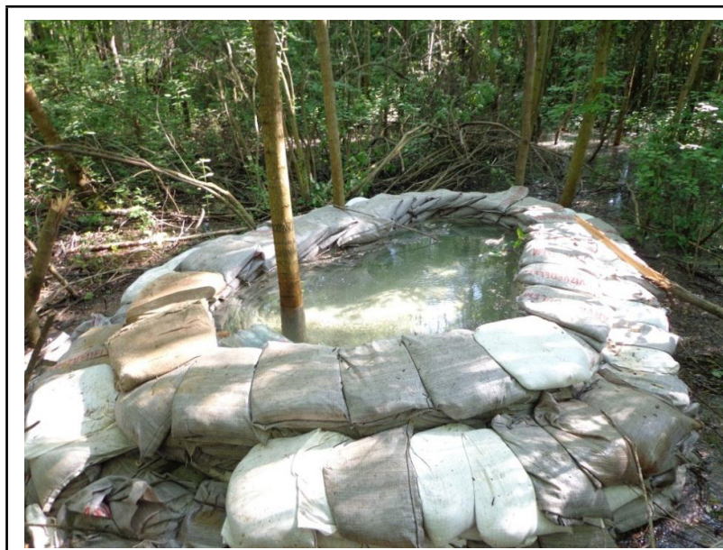
99. kép: A Mosoni-Duna bal part 13+980 tkm (Püspökerdő) buzgár, mentett oldali töltés-lábtól 36 méterre, az erdőben közel kör alakú ellennyomó medence lett kialakítva, nem teljesen szabályos kialakítású, nincs túlfolyója. A buzgár feltörő vize tiszta, a krátere környékén nem látható homokkihordás. A medence két zsáksorral alacsonyabb volt kezdetben, utólag magasították a képen látható szintre. A jelenség észlelése: a gát mentett oldalán az örök csobogás hallottak és intenzív talajfeltörést tapasztaltak.
