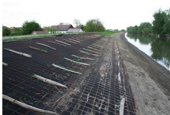
39. kép: Lehetséges, hogy a jövő évtizedek hullámvédelme a geotextília lesz, hegesztett hálóval lefogva és tüskékkel a talajhoz rögzítve
