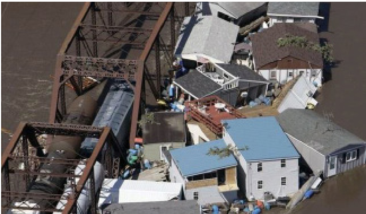
112. kép: Egy komplett város torlódott fel a vasúti hídon a Red folyó árvizénél. A vasúti szerelvény már vízben áll, a víznyomása az acélszerkezetet nyomja. Ehhez adódik a házakra ható víznyomásból az acél szerkezetre átadódó nyomás.
