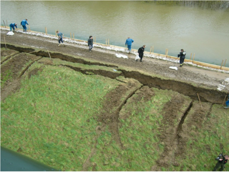
17. kép: Vízkivezető szivárgó csökkenti a terhelést a Csongrád nagyréti suvadásnál.
