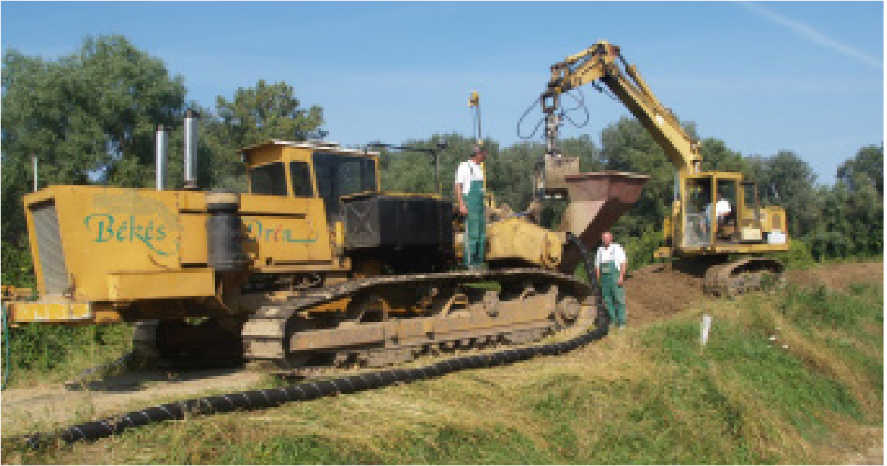
48. kép: Megelőző védekezés, kéményszivárgó (drén) építése gépi technológiával a töltés mentett oldalába. A drén megszakítja a szivárgási utat, nem jut terhelés a mentett oldalra.
