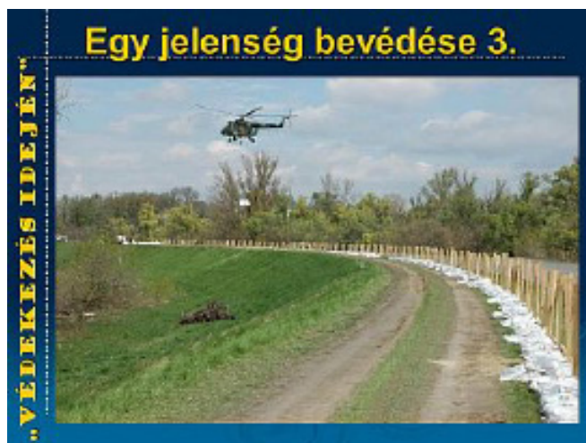
Anyagszállítás helikopterrel
