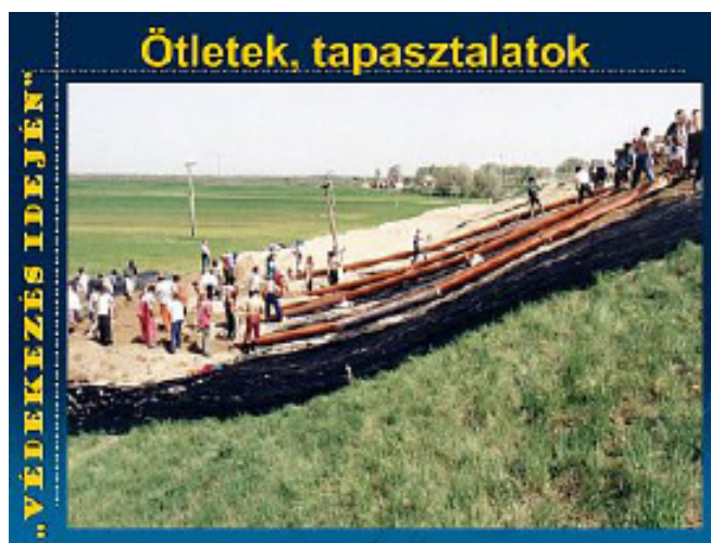
Anyagszállítás töltéscsúszás esetén 1.
