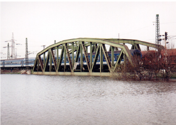
110. kép: Zagyva vízszintje elérte a szolnoki vasúti híd alsó élét 2000-ben. Az elhaladó személyvonat mögött látszik a híd leterhelésére beállított kővel rakott tehervonat.
