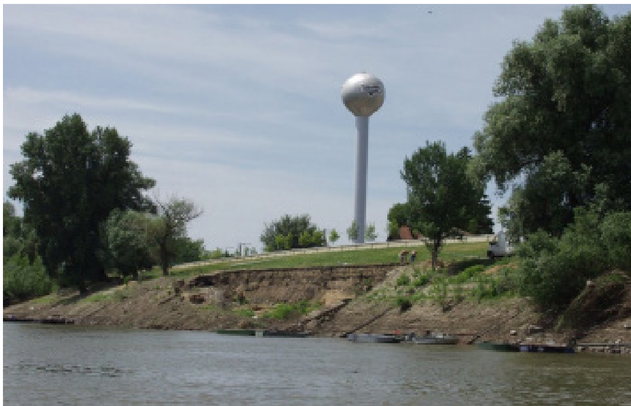
62. kép: Vízoldali suvadás Szolnok téglaházi szakasz, újvárosi gát
