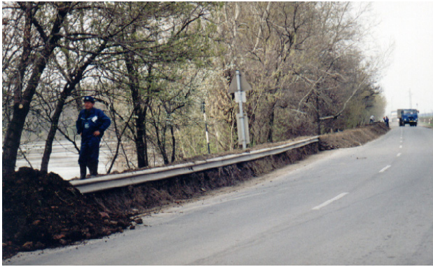
18. kép: A földből készült nyúlgát ráépült az útra és a védőkorlátra a Martfű feletti magasparton. A fényképhez tartozó metszet a 13. ábra.
