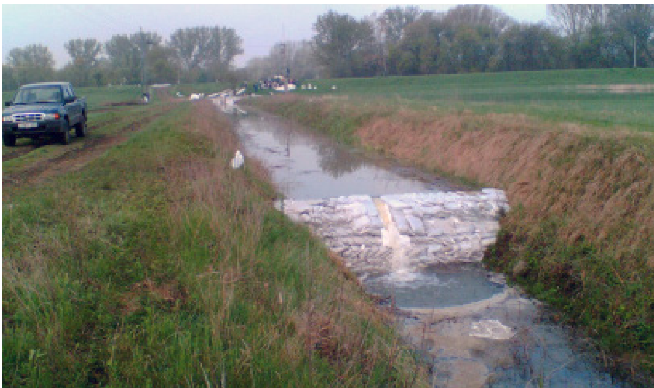
106. kép: Ellennyomó medence kialakítása szorítógáttal a műtárgyhoz vezető csatornában
