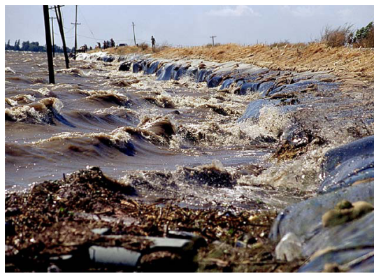
37. kép: Földrézsű hullámvédelme geotextiliával, előtérben az összegyűlt katré
