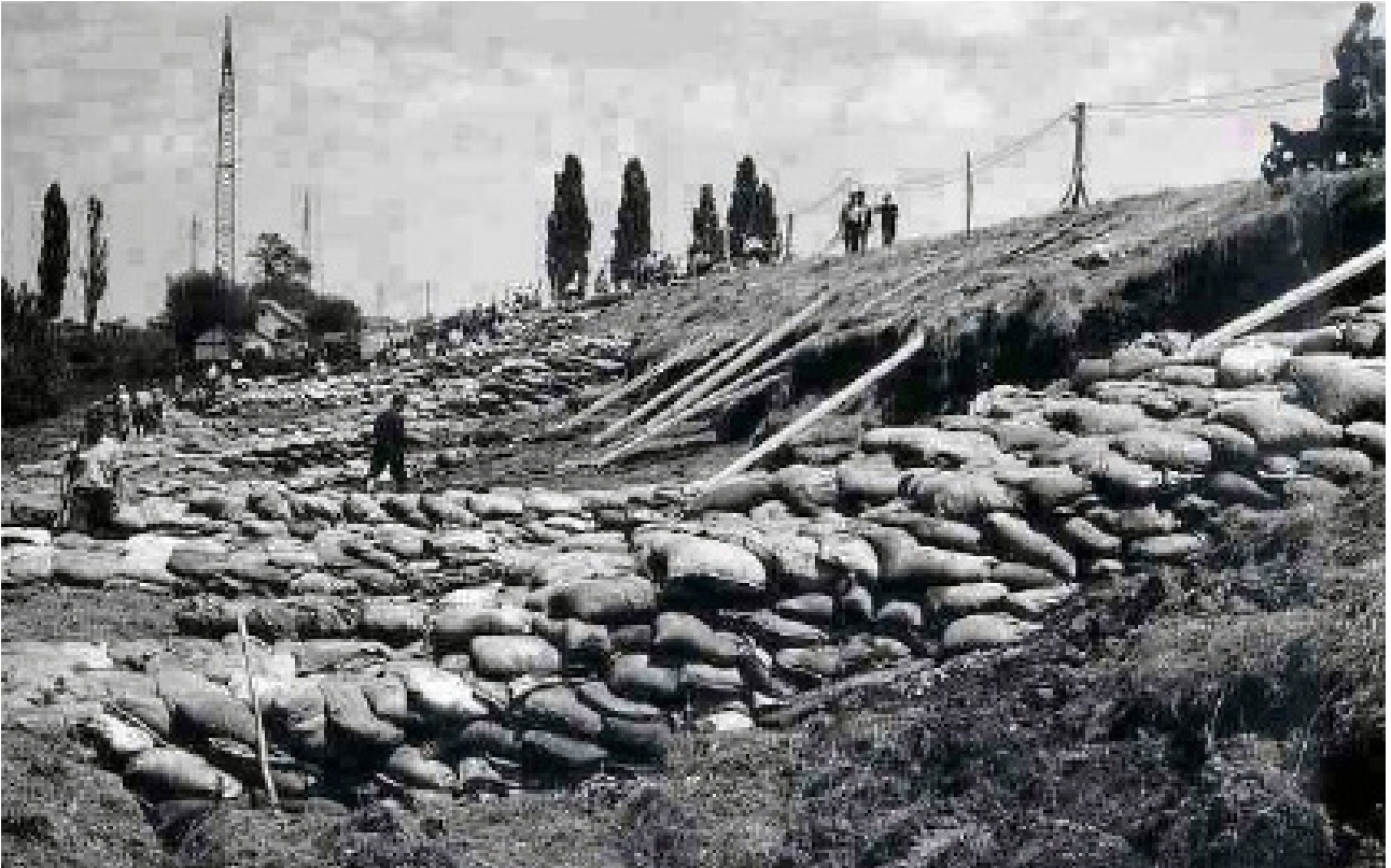
57. kép: Foki-híd alatti suvadás 1970 évi árvíznél
