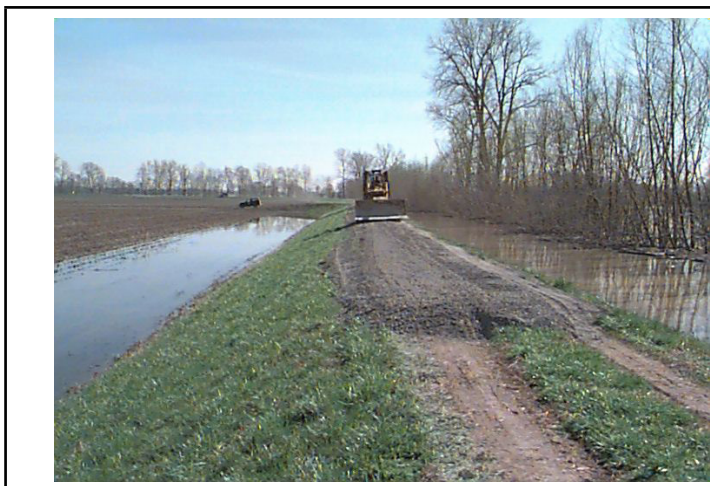
3. kép: Töltésfejelés teljes szelvényben az Egyesült Államokban, alighanem elfelejtettek lehumuszosítani. Ez a munka elég lassan halad, mert a dózer és a szállító jármű nem tudja kikerülni egymást a koronán. A talaj durva szemcséjűnek, túlságosan magas vízáteresztő-képességűnek tűnik, és ne feledjük, hogy dózerrel nem lehet tömöríteni!
