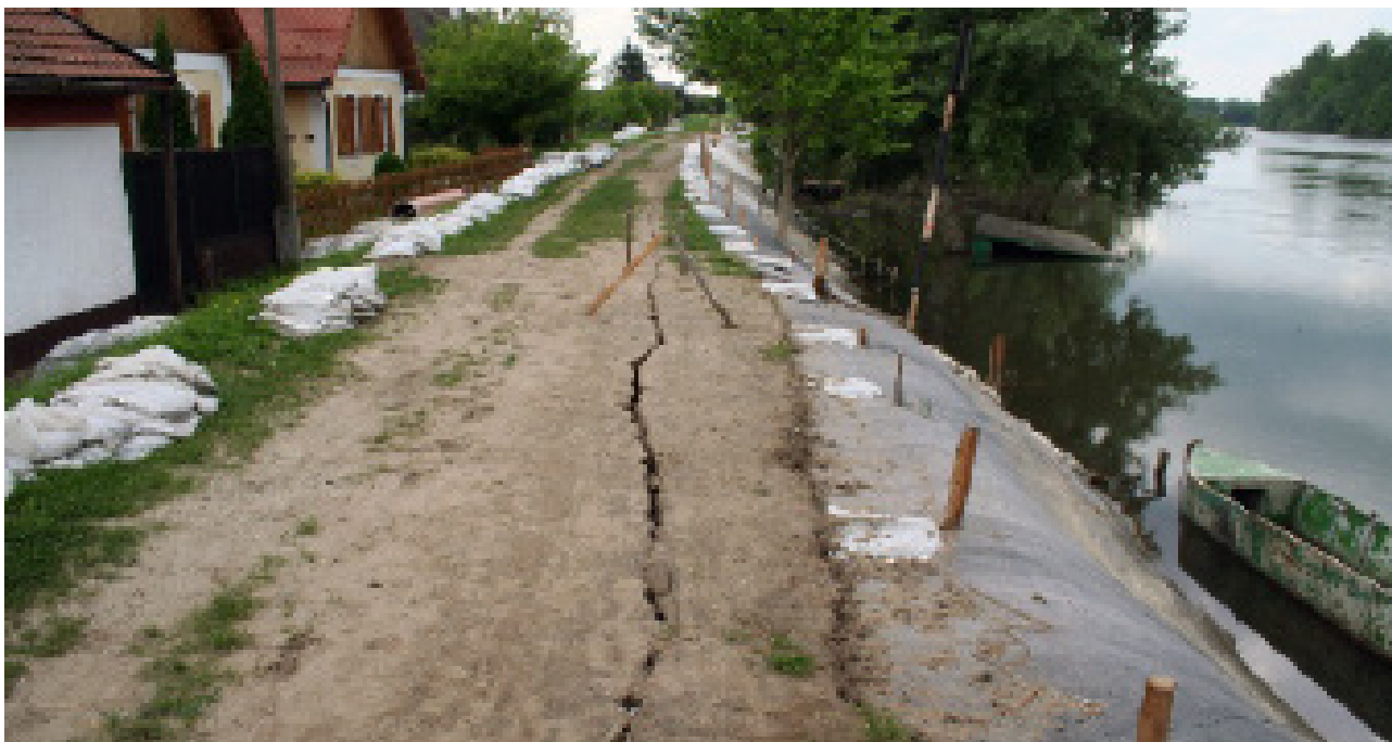
19. kép: Duzzadási repedés Vezseny északi részét védő alacsony gát koronáján, KÖTIVIZIG, 2006. Forrás: Szerző saját felvétele
