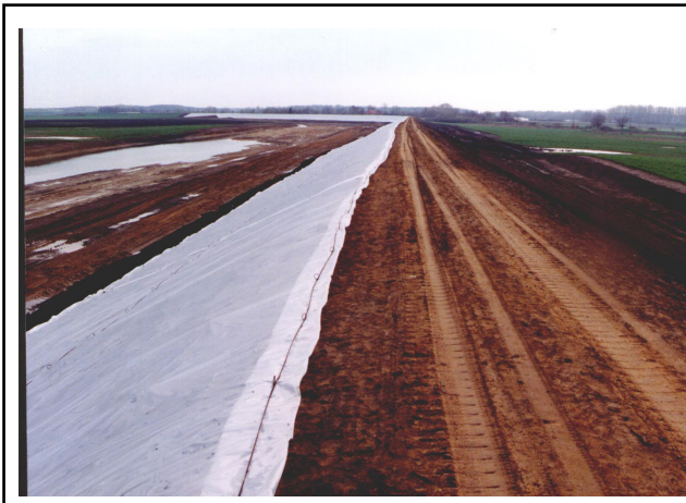
26. kép: Az épülő Kisdelta tározó ideiglenes hullámvédelme
