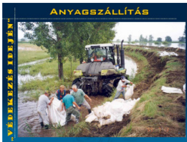
Anyagszállítás fakadóvízes töltéselőtérben 3.
