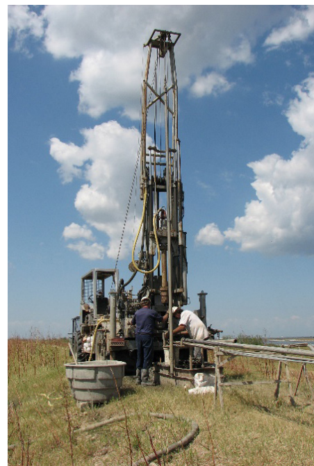
24. kép: Geotechnikai feltáró fúrás a gát koronáján Forrás: Szerző saját felvétele
