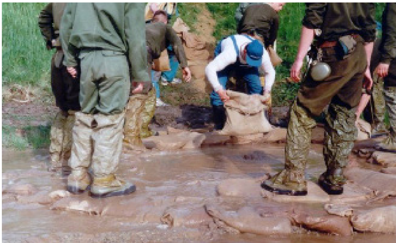
92. kép: A védekezés kezdete a tiszasasi buzgárnál
