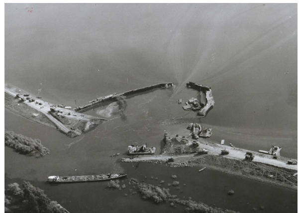
7. kép: Kettős-Körös jobb parti töltésszakadás ideiglenes elzárása (1980)
