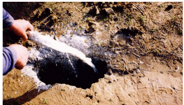
18. kép: Száradási repedés meszes vízzel történő feltöltése, Zagyva jp., 1991.
