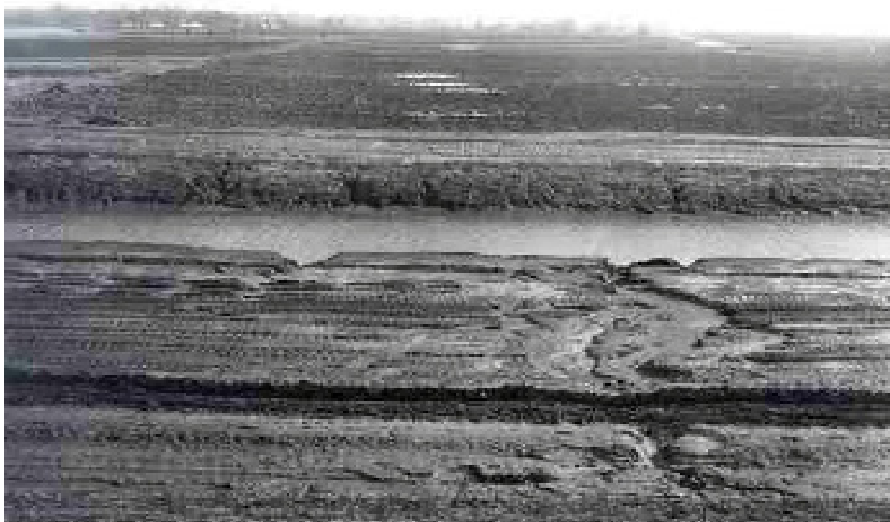
53. kép: Csurgás egy frissen elkészült gát mentett oldalán
