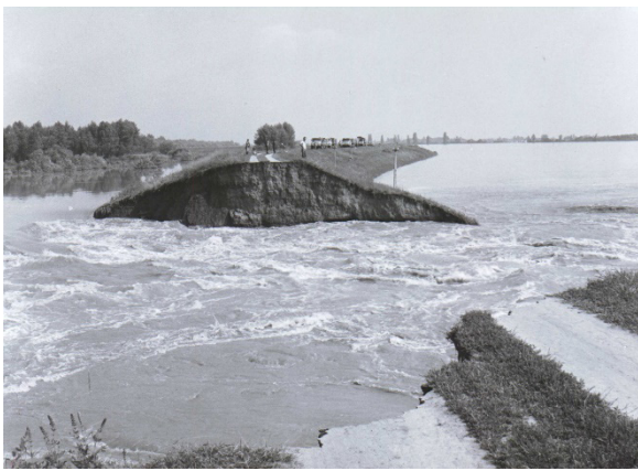
6. kép: Kettős-Körös jobb parti töltésszakadás Hosszúfoknál (1980)
