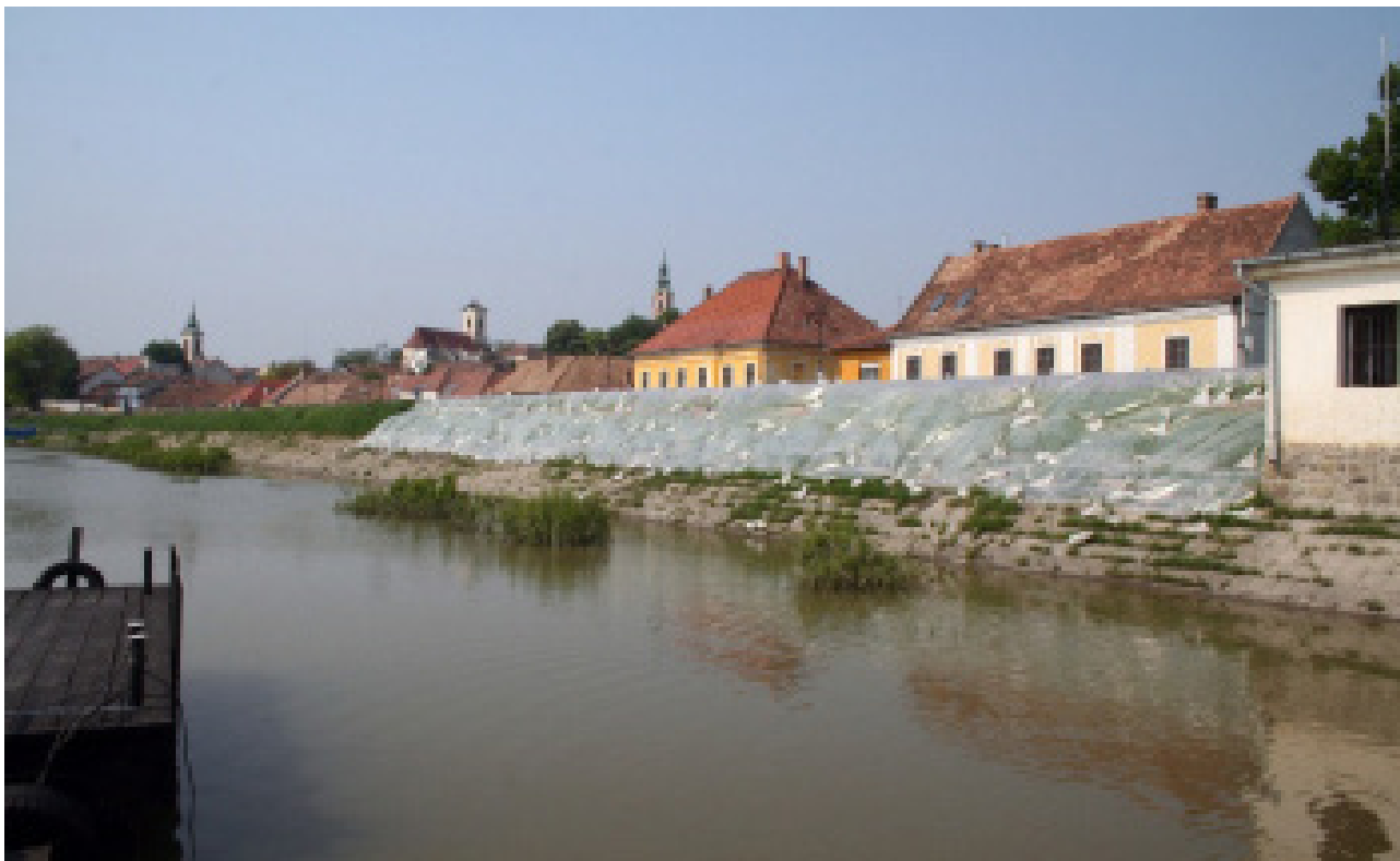
50. kép: A szivárgó vizek ellen lefóliázott vízoldali burkolat Szentendrén. A fólia nem hatékony szivárgás gátlás, mert nem tapad neki a rézsűnek.
