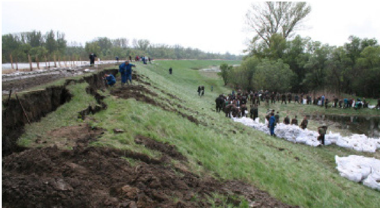
61. kép: Csongrád Nagyréti suvadásnál órák alatt kialakult egy méteres függőleges elmozdulás
