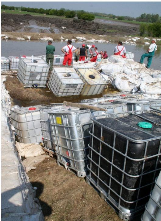
76. kép: Ballonok az Istvánházi suvadás bordái között, rendezett védekezés
