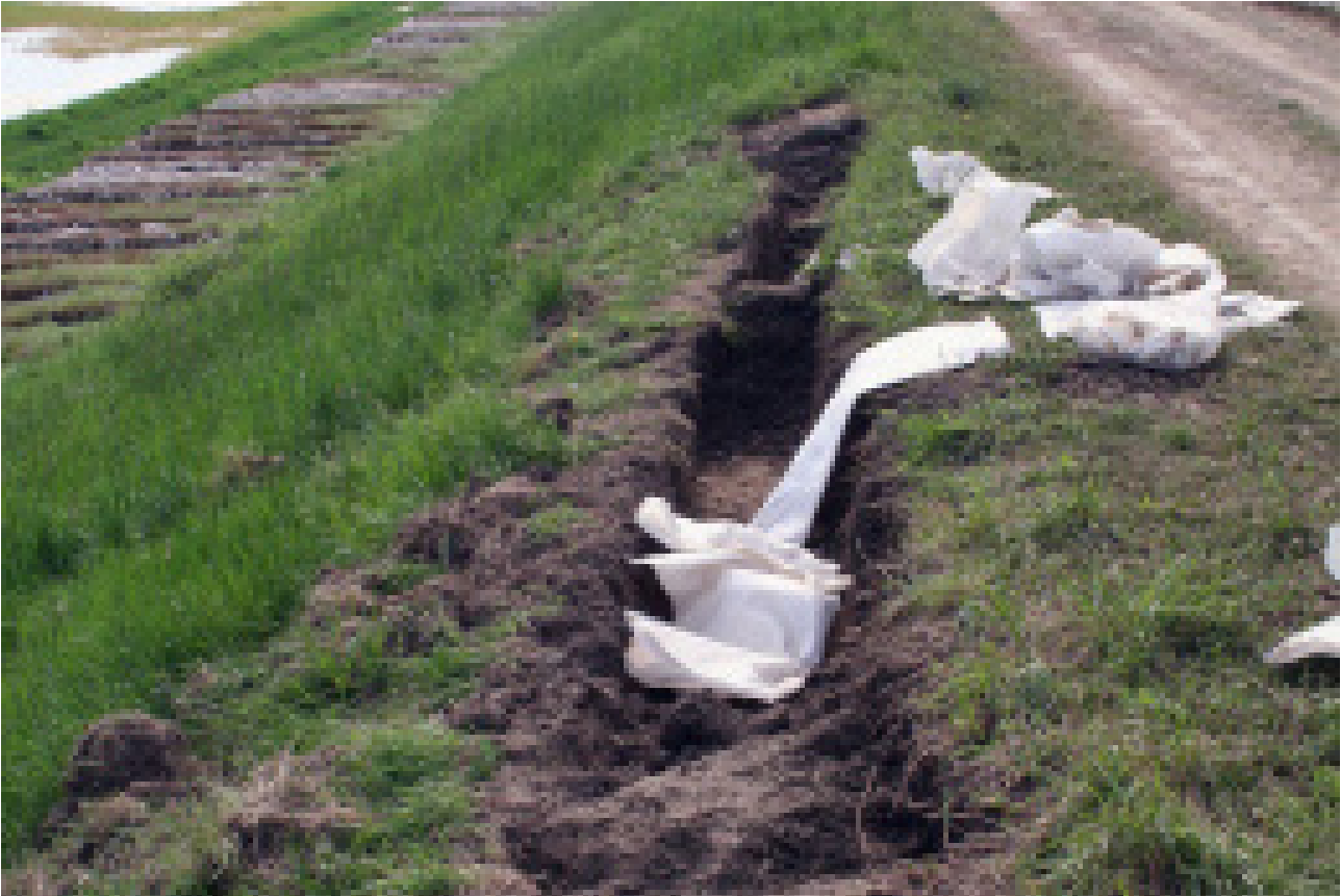
2. kép: Mentett oldali töltéskorona, mint anyagnyerőhely a 2006. évi árvízvédekezésnél
