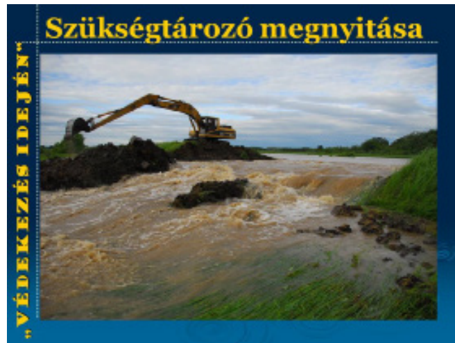
Szükségtározó megnyitása – fix nyitási helyen
