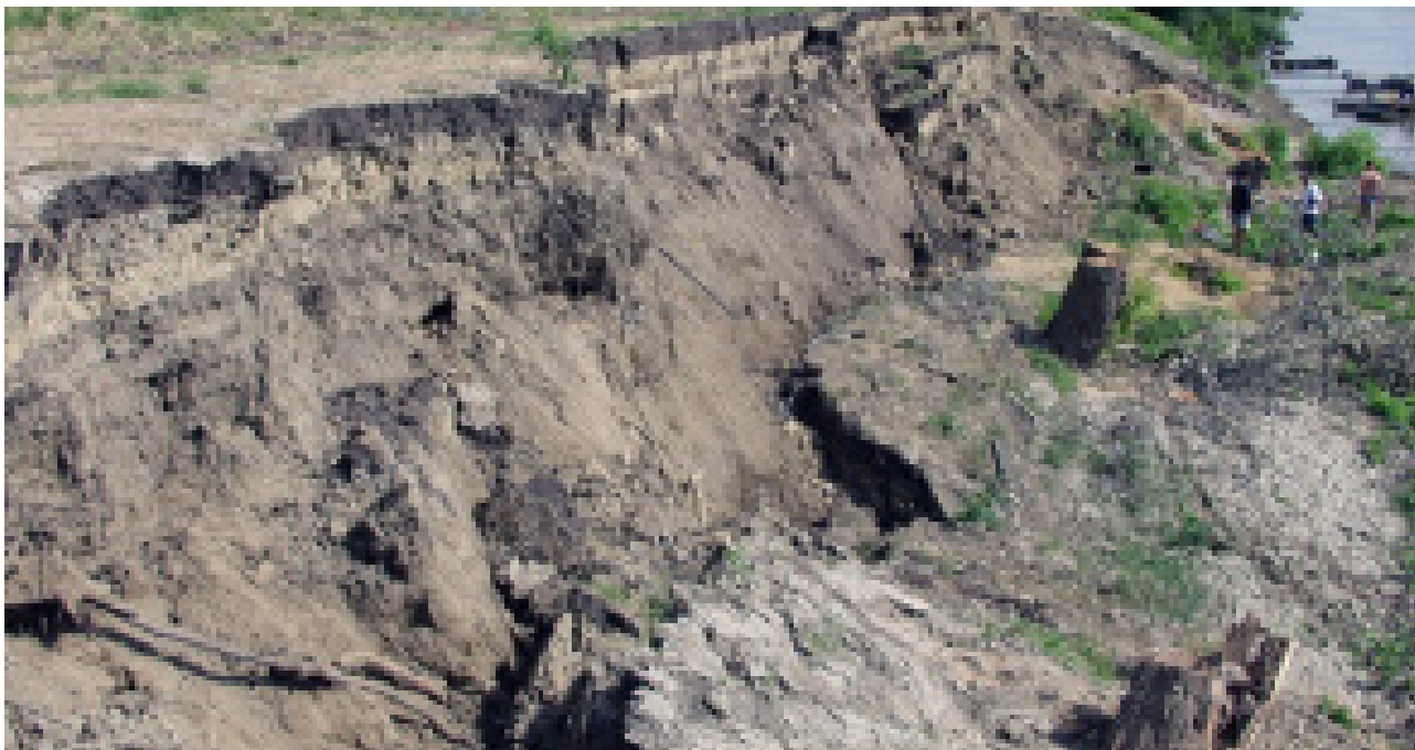
23. kép: Vízoldali suvadás Szolnok téglaházi szakasz, újvárosi gát Forrás: Szerző saját felvétele
