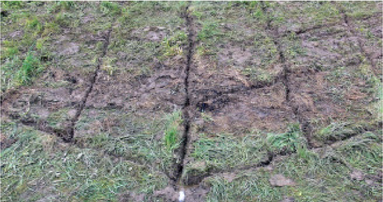
46. kép: Egy megoldás az átszivárgó víznek a töltéstartestből való kivezetésére kis vízhozam esetén. Ez a módszer 1-2 nap alatt ki tudja szárítani a töltés felső részét.
