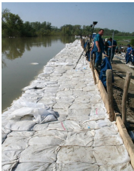
68. kép: A korona kiszélesítése a vízdal felé homokzsákokkal
