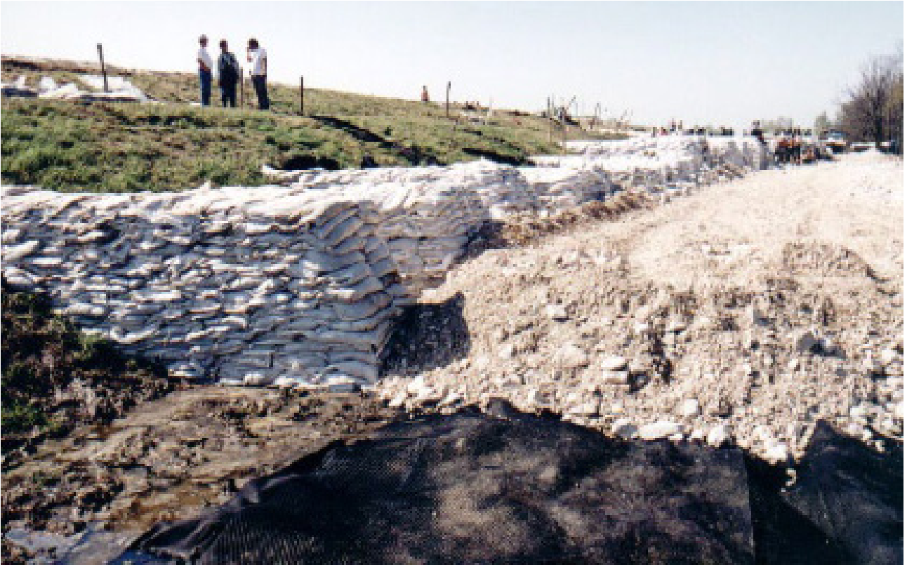
58. kép: A mentett oldali töltéslábhhoz épített leterhelő-megtámasztó kőpadka-út kialakítása a Kolopi rámpa felett 2000-ben
