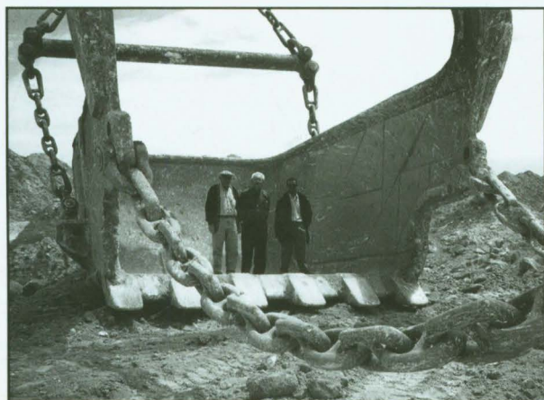
Pás escavadoras extraem 100 ton de rocha de cada vez
