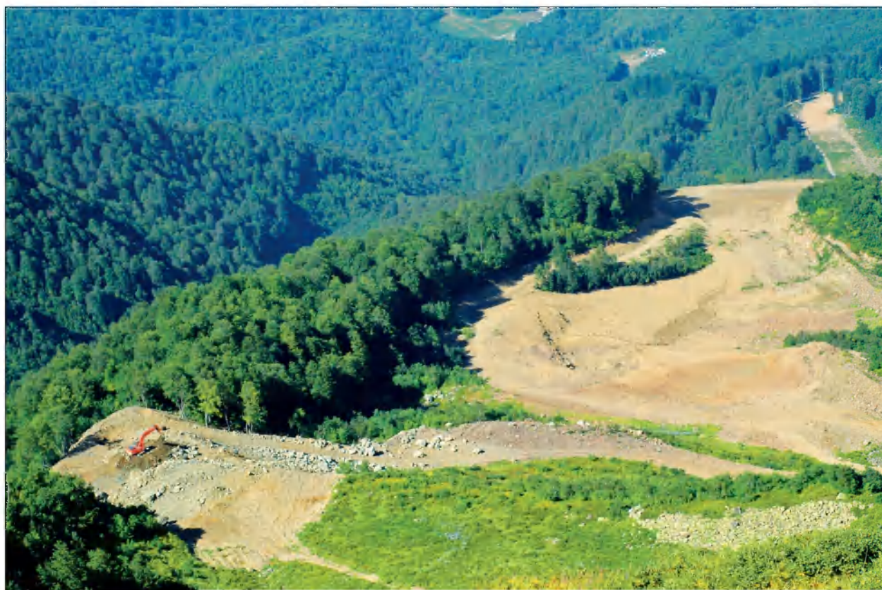
Рис. 12. Строительство дороги к границе Кавказского заповедника в ущ. р. Мзымта.
