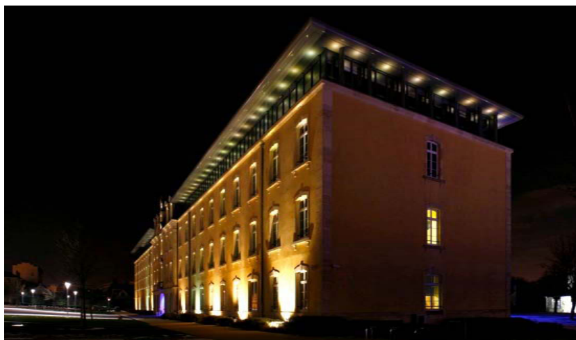
Image 18 Ancienne caserne réhabilitée. Photographie (panoramique par assemblage) d'une ancienne caserne réhabilitée (Dijon, 21), abritant les locaux de la communauté d'agglomérations du Grand Dijon. © Samuel Challéat, ThéMA, 2010.
