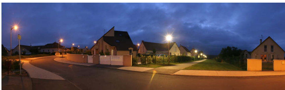
Image 43 Superposition de matériels divers en quartier résidentiel, Fontaine lès Dijon. Photographie d'un quartier résidentiel aisé à proximité de Dijon, mettant en évidence la superposition de matériels divers : luminaires de voirie, à la photométrie performante, et luminaire d'ambiance sur le cheminement piétonnier, à la photométrie horizontale. © Samuel Challéat, ThéMA, 2010.
