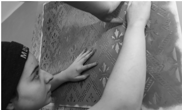
Abb. 5: Der bauzeitliche Befund einer schablonierten Farbfassung wird in der Technik des 19. Jahrhunderts rekonstruiert (Brehms Welt – Roland Horn)
