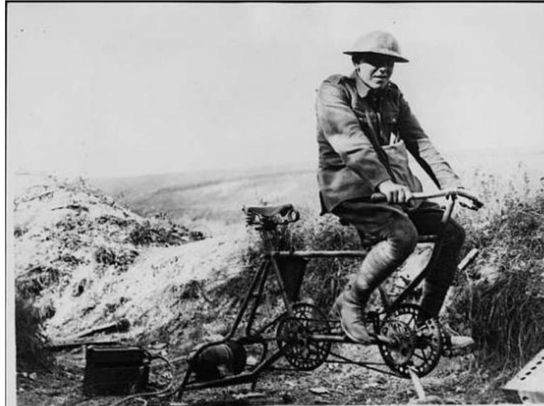
Figura 6.4 Como los alemanes generaban electricidad para los equipos de telegrafía inalámbrica en las trincheras. Fuente: <http://ww1ieper1917.wordpress.com/>
