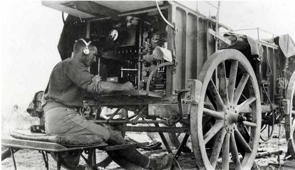
Figura 6.3 Transmisor de Marconi de 500W para establecer las comunicaciones aéreas. Fuente: <http://www.marconicalling.com/introstring.htm>
