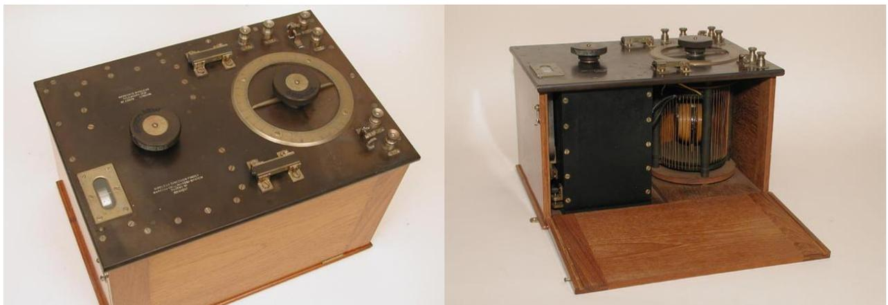
Figura 7.14 Equipo de radiogoniometría. A la izquierda se puede apreciar los controles de dirección de frecuencia. A la derecha el interior del equipo basado en el sistema de Bellini-Tosi. 1916.
