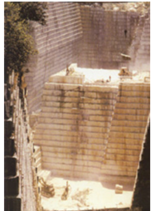
Lo que no permite la normativa de seguridad minera española. Véase el talud del fondo en particular.
