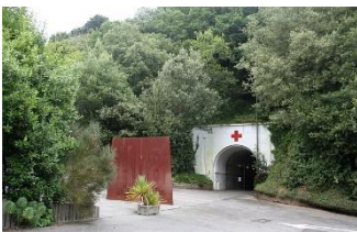
Figura 25: Hospital subterráneo en Bailía de Jersey, Reino Unido.
