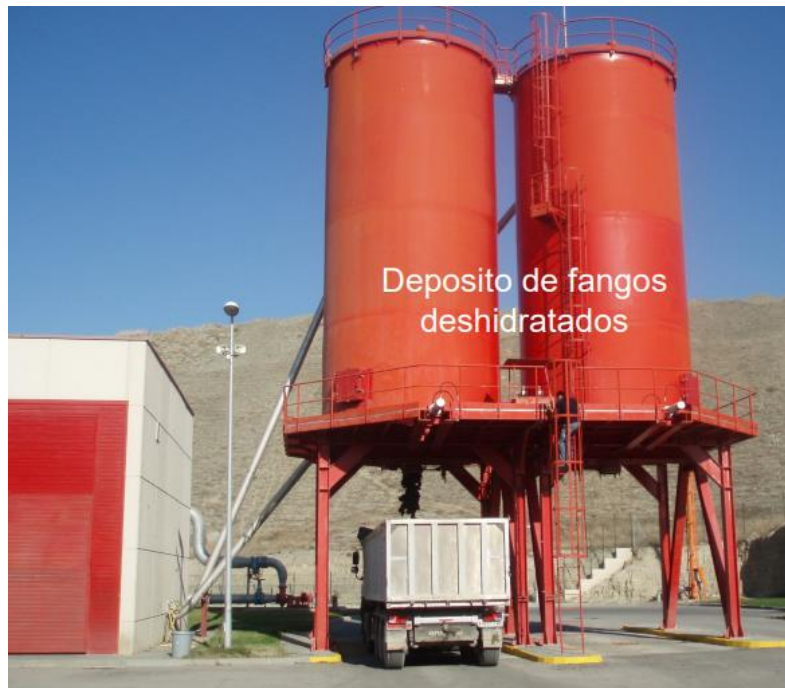
Figura 20: Depósito de fangos deshidratados.
