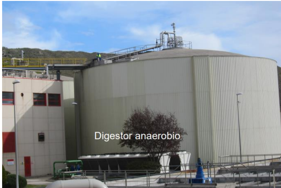
Figura 16: Digestor Anaerobio.
