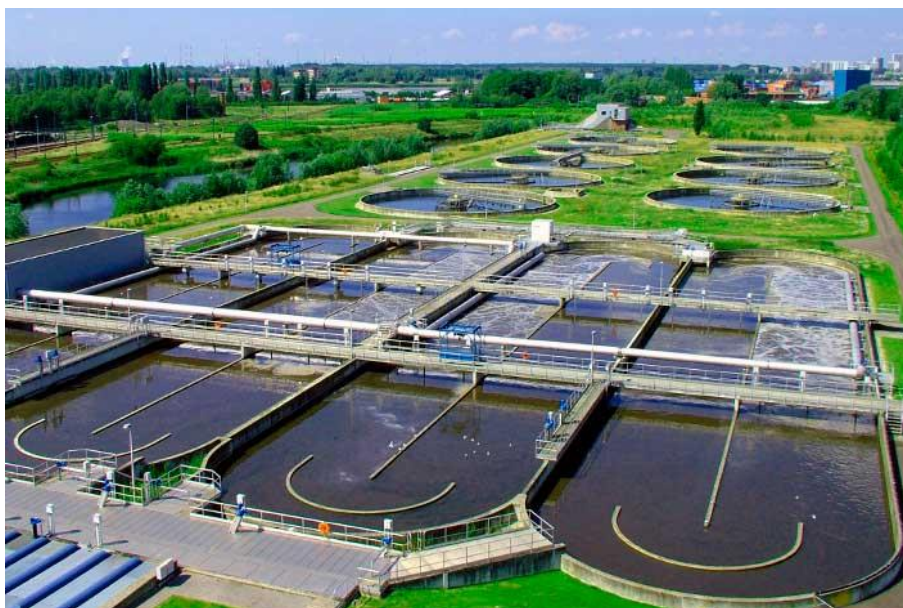
Figura 2: Estación Depuradora de Aguas Residuales (EDAR)
