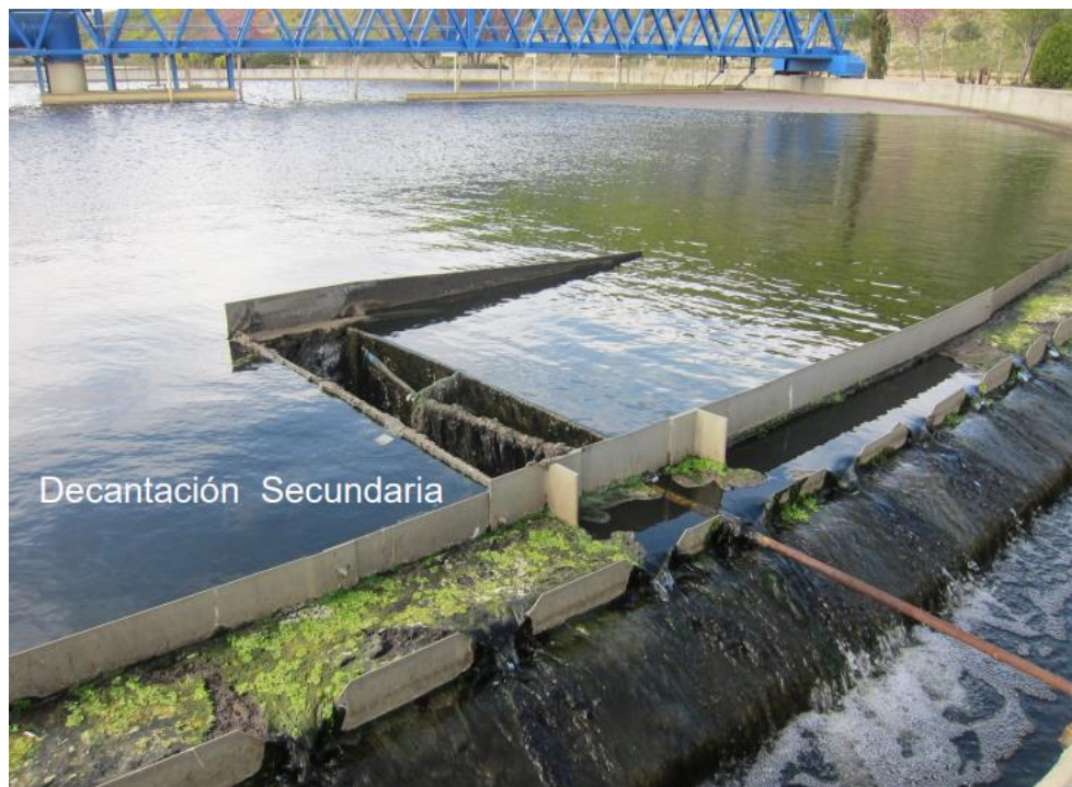
Figura 15: Decantación secundaria.
