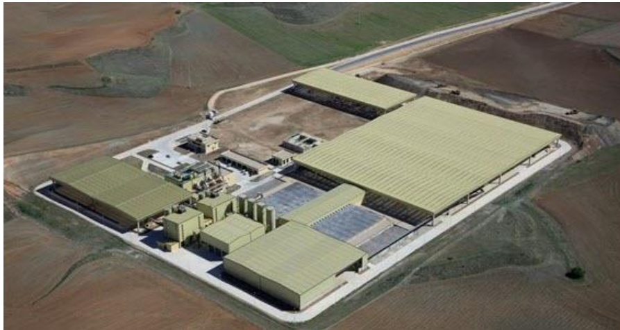
Figura 25: Planta de compostaje y secado térmico con cogeneración eléctrica de Loeches.
