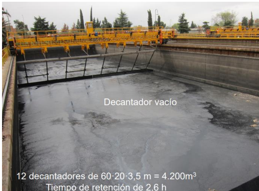
Figura 12: Decantador primario vacío.
