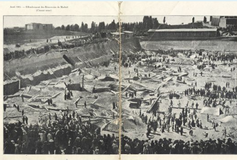
Tercer depósito del Canal de Isabel II, durante su construcción y después de su hundimiento.
