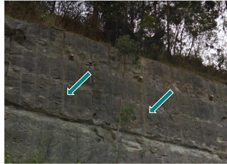
Talud ejecutado mediante voladura de precorte (Autovía E70). Fuente: Google Street View
