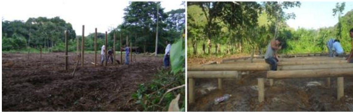
Fotografía N° 7 Detalle de los trabajos de hincado de pilotes para la construcción del Centro de Interpretación y oficinas administrativas. Obsérvese la explanación y limpieza preliminar que ya se había hecho con maquinaria pesada (trabajos realizados a finales del 2012)
