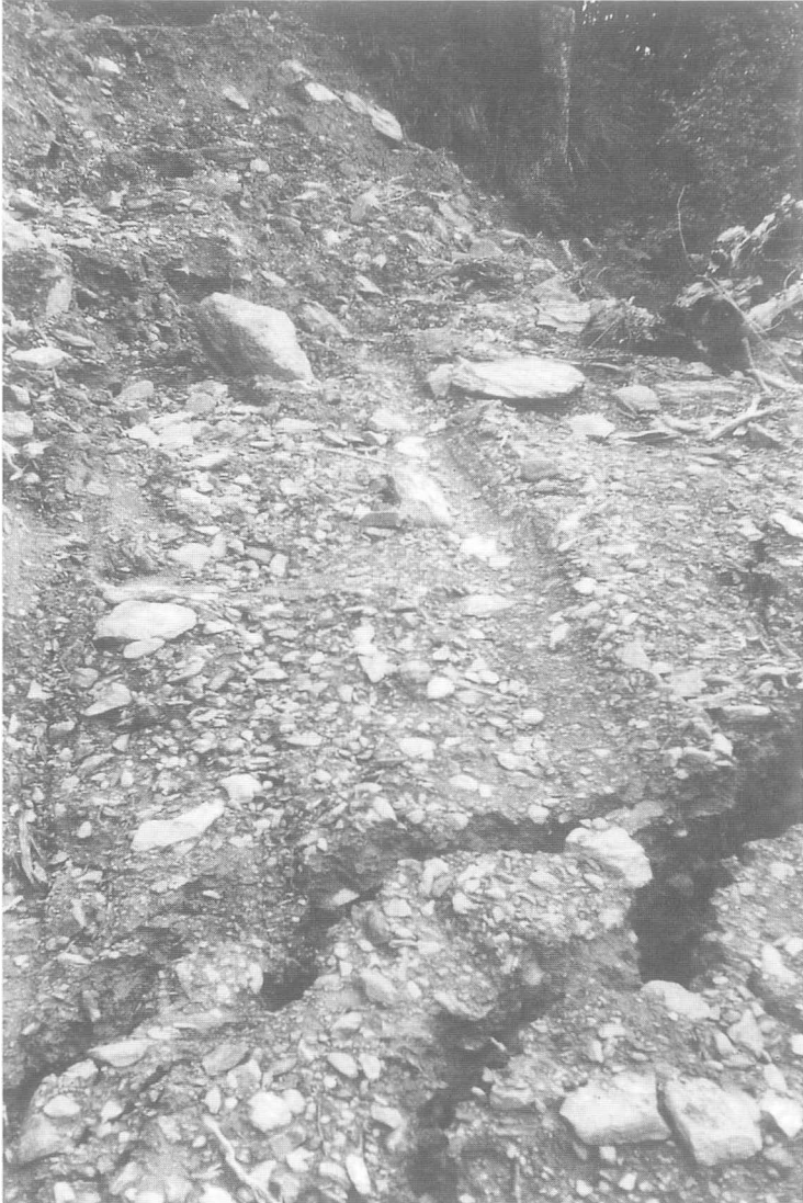
Abb. 9: Klaffende, gestaffelt angeordnete Zerrspalten am Südrand der Rutschung, im Bereich des mittleren Weges, zeigen die hohe Aktivität im Jahre 1992, sowie Scherdeformation am Rand der Rutschung an.
