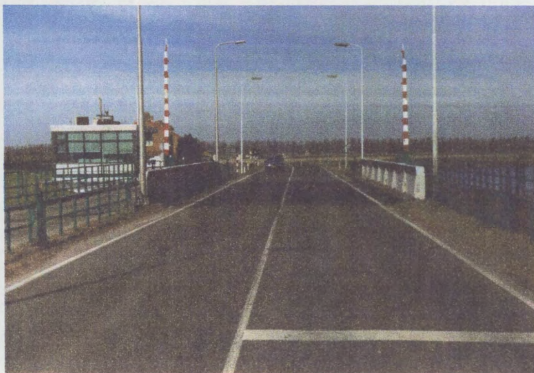
Figuur 4. Brug over de Zandkreeksluis
