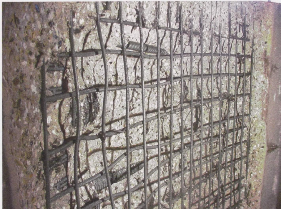
Figuur 1.1 Voorbeeld van het afspatten van het beton ten gevolge van brand.
