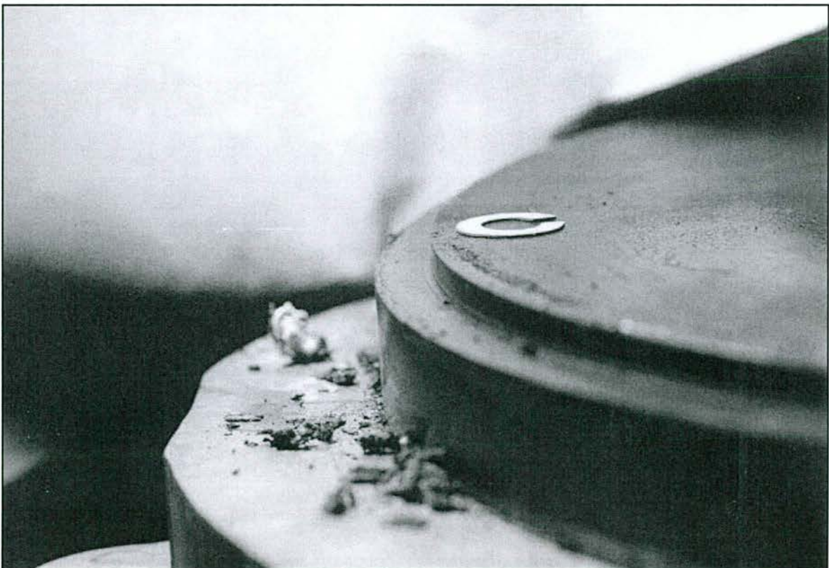
Abb. 9.21: Elastomerkissen nach Ausbau aus dem Topf: Detailaufnahme des Rondenrands bei C (in Kipprichtung)
