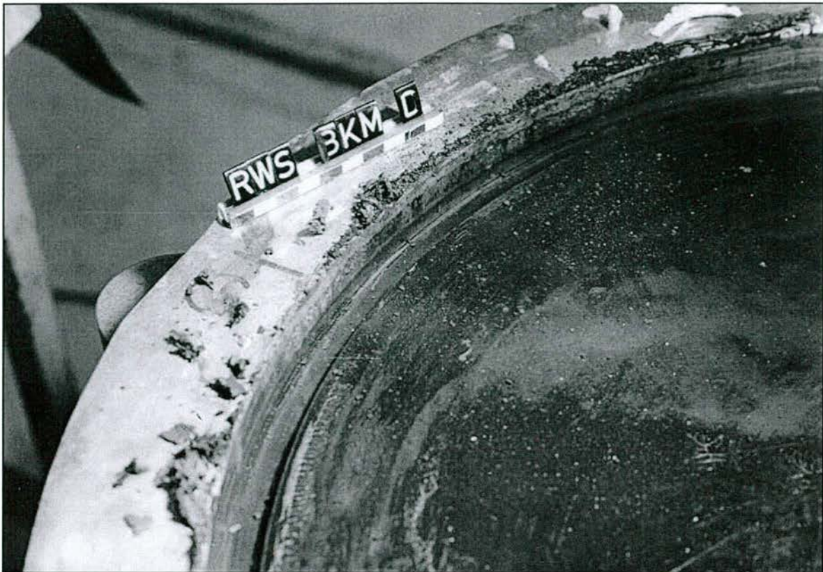
Abb. 9.9: Topf mit Elastomerkissen an der Stelle C (in Kipprichtung) nach Ausbau der UHMWPE-Innendichtung
