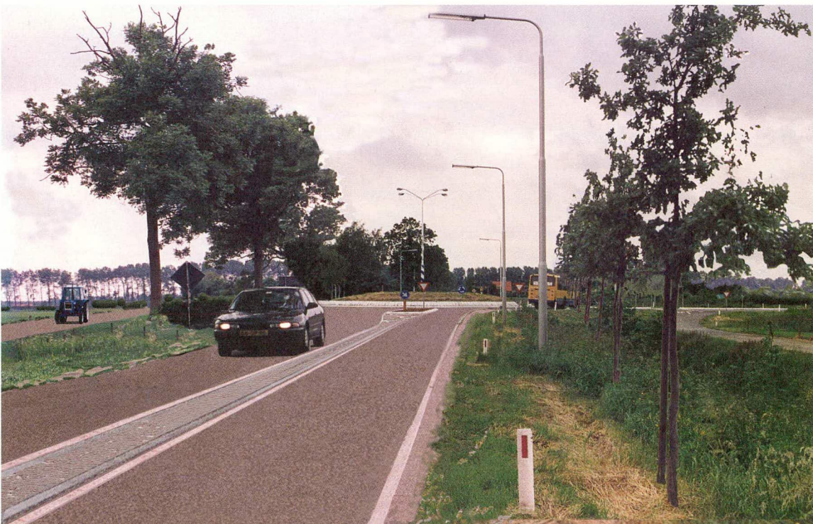
Een impressie van de aanpassingen welke van een 80-kilometerweg een Duurzaam Veilige gebiedsontsluitingsweg maken.
