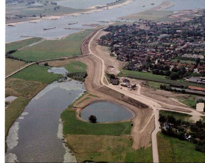
Dijkverzwaring langs de Waal bij Ochten in de zomer van 1995. Na het hoogwater van 1995 werden de in het Deltaplan Grote Rivieren aangekondigde dijkverzwaringen ongekend snel uitgevoerd. Twee jaar na het van kracht worden van de Deltawet Grote Rivieren, was de eerste fase van het Deltaplan Grote Rivieren al bijna geheel voltooid. In het Deltaplan Grote Rivieren werd voor de rivierdijkversterkingen in het Rijnstroomgebied (de Rijn en zijn takken, inclusief het benedenrivierengebied) bepaald dat het gehele dijkverzwaringprogramma in 2000 gereed zou moeten zijn. De uitvoering van het Deltaplan moest gebeuren volgens de uitgangspunten van de commissie Boertien. De dijkversterkingen van de onveiligste dijkvakken (onveiligster dan 1/100) moesten zoveel mogelijk in 1995 worden afgerond en uiterlijk in 1996. Voor de Maas werd een snelle uitvoering van de plannen van de Commissie Watersnood Maas (Boertien II) nagestreefd. De kades van de Maas zouden zo veel mogelijk in 1995 gereed moeten komen, met een uitloop naar 1996. Voor de overige onderdelen moest "de tijdhorizon van 2010 à 2015 aanmerkelijk worden vervoegd."
