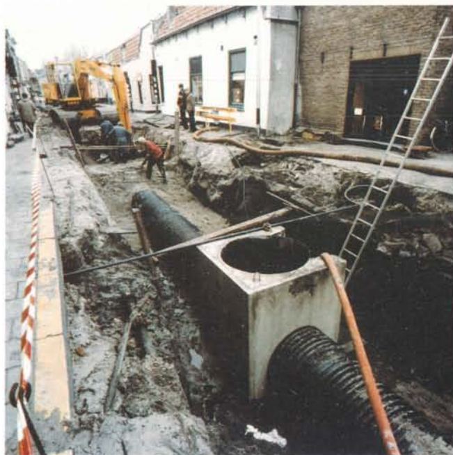
Foto 14. De aanleg van rioleringswerken in Gouda
