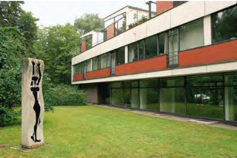
Altonaer Straße 1, Eternit-Haus, Wohnanlage, Gartenfassade mit Skulptur, 1957 von Paul G. R. Baumgarten, 2007
