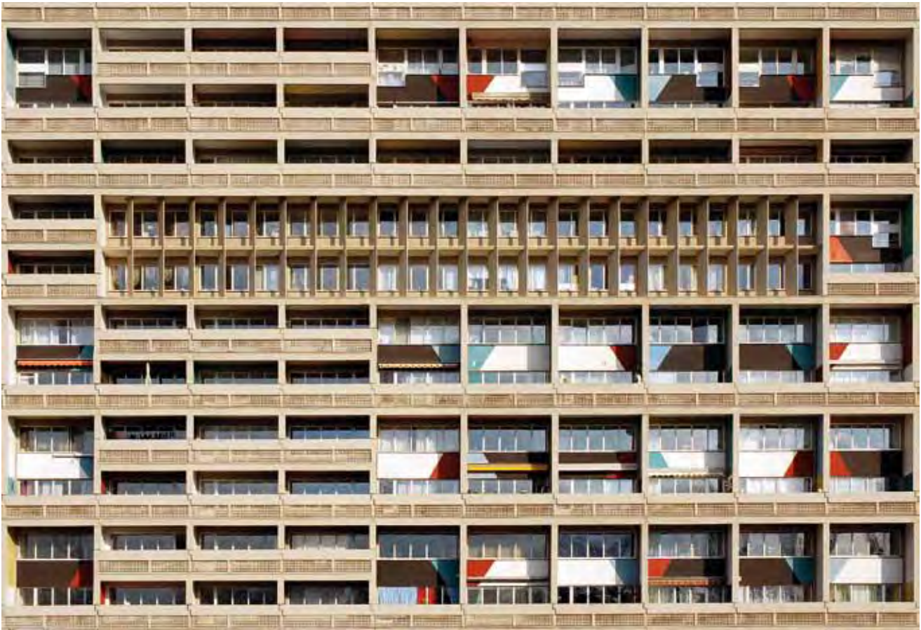
Flatowallee 16, Unité d'Habitation, 1956–1958 von Le Corbusier, 2007 Flatowallee 16, Unité d'Habitation, 1956–58 by Le Corbusier, 2007
