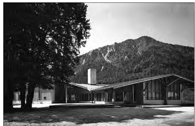
Fig. 8: The Prisank Hotel corresponding with the alpine landscape is one of the best evidences of the regionalism of the 1960s' generation (demolished). Architect: Janez Lajovic, 1961–62 Abb. 8: Das Prisank Hotel, das mit der Alpenlandschaft korrespondierte, ist einer der besten Belege für den Regionalismus der 1960er Jahre (zerstört), Architekt: Janez Lajovic, 1961–62
