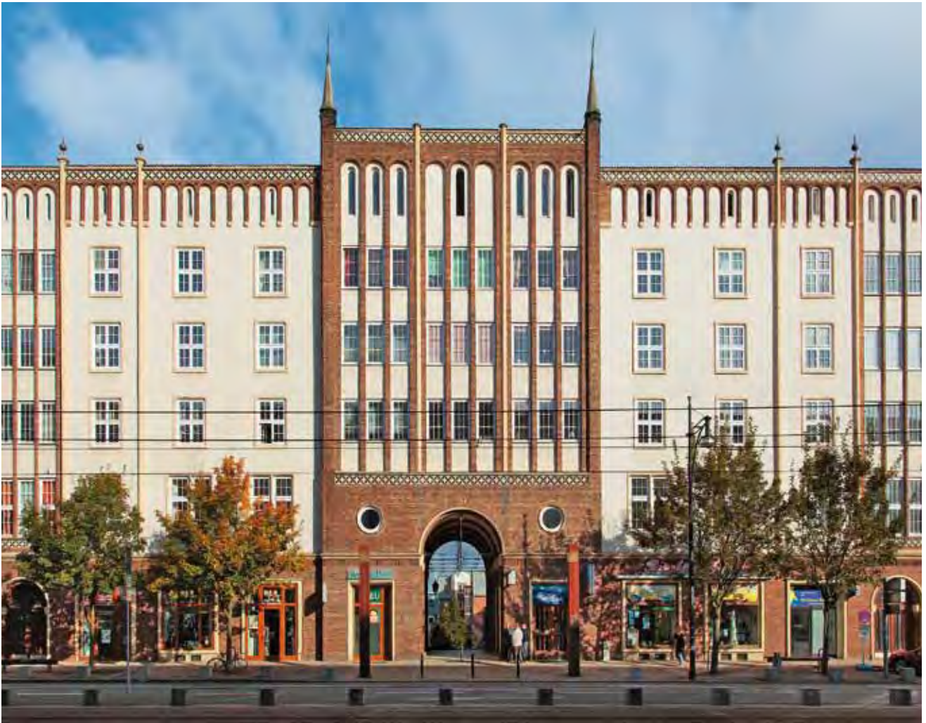
Abb. 2: Rostock, Lange Straße, Nordseite mit Fußgängerdurchgang, 2012 Fig. 2: Rostock, Lange Strasse, north side with pedestrians' passage, 2012
