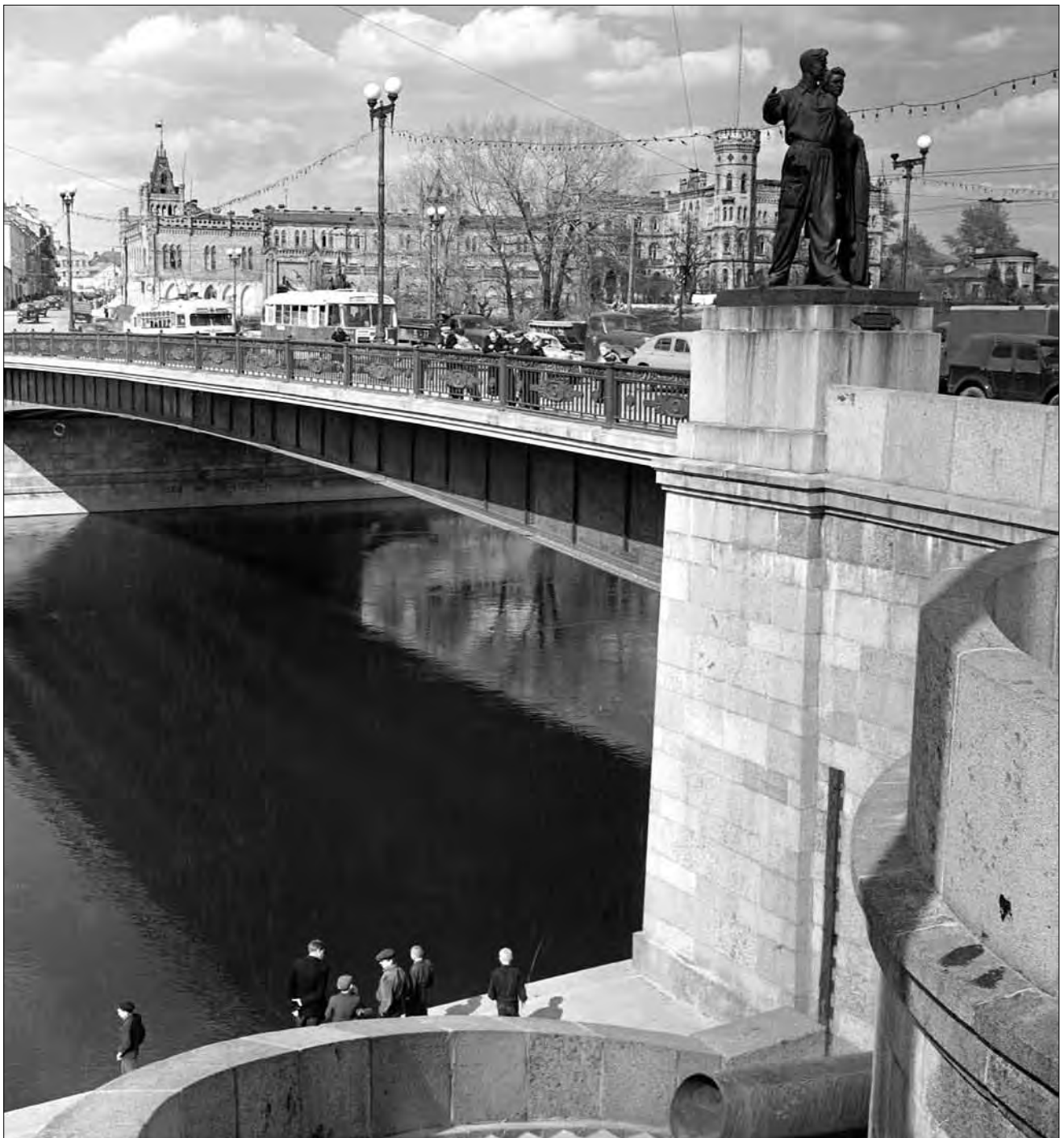
▽ Abb. 3: Brücke über die Neris in Vilnius, 1948–52, Architekt: V. Anikin
