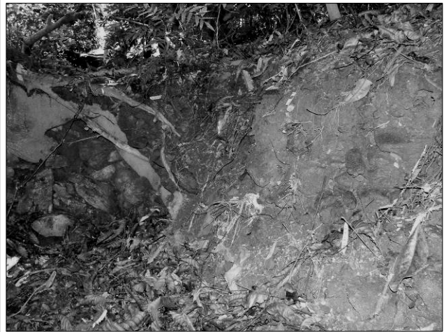
Figure 19: Muret de soutènement en contrebas de la zone horticole en fond de vallon
