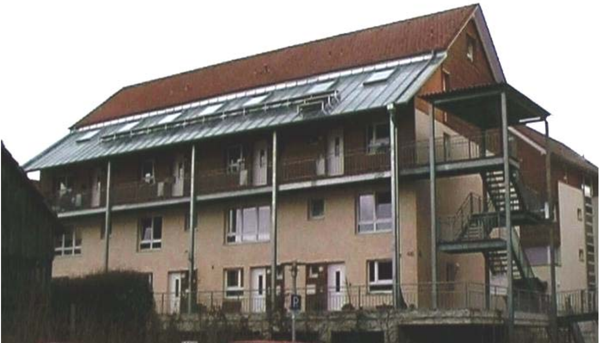
Abbildung 8-7: Neubauwohnungen des Ökozentrums Rommelmühle
