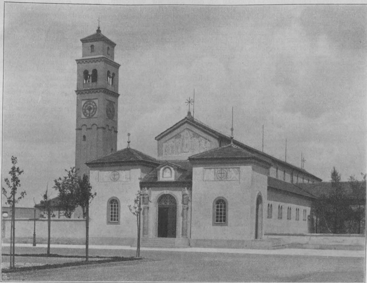
Leichenhalle und Glockenturm.
