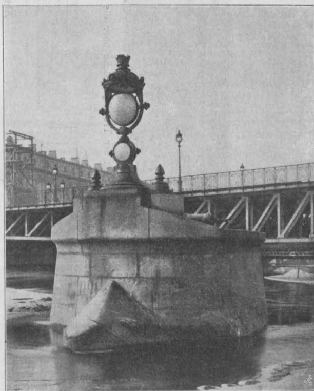
Abbildg. 8. Eisbrech- und Auflagerpfeiler vor dem Drehpfeiler.
