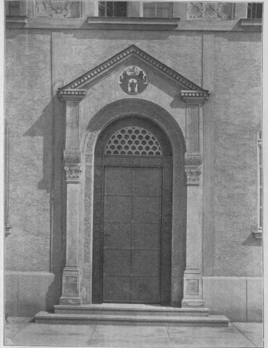
Portal am Verwaltungsgebäude.
