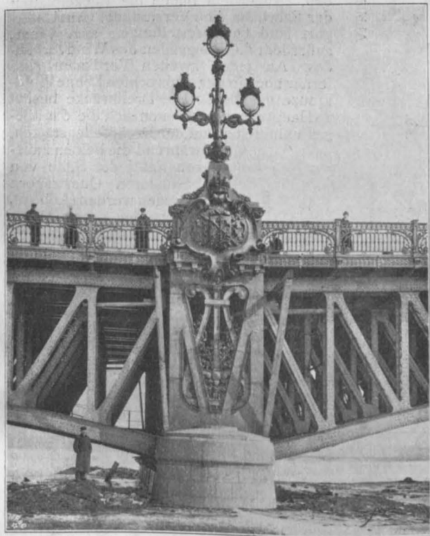
Abbildg. 11. Pfeiler des Ausleger-Trägers.
