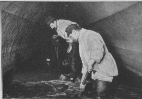
Abbildg. 24. Kanalfahrzeug Abbildg. 22 u. 23 im Betrieb.
