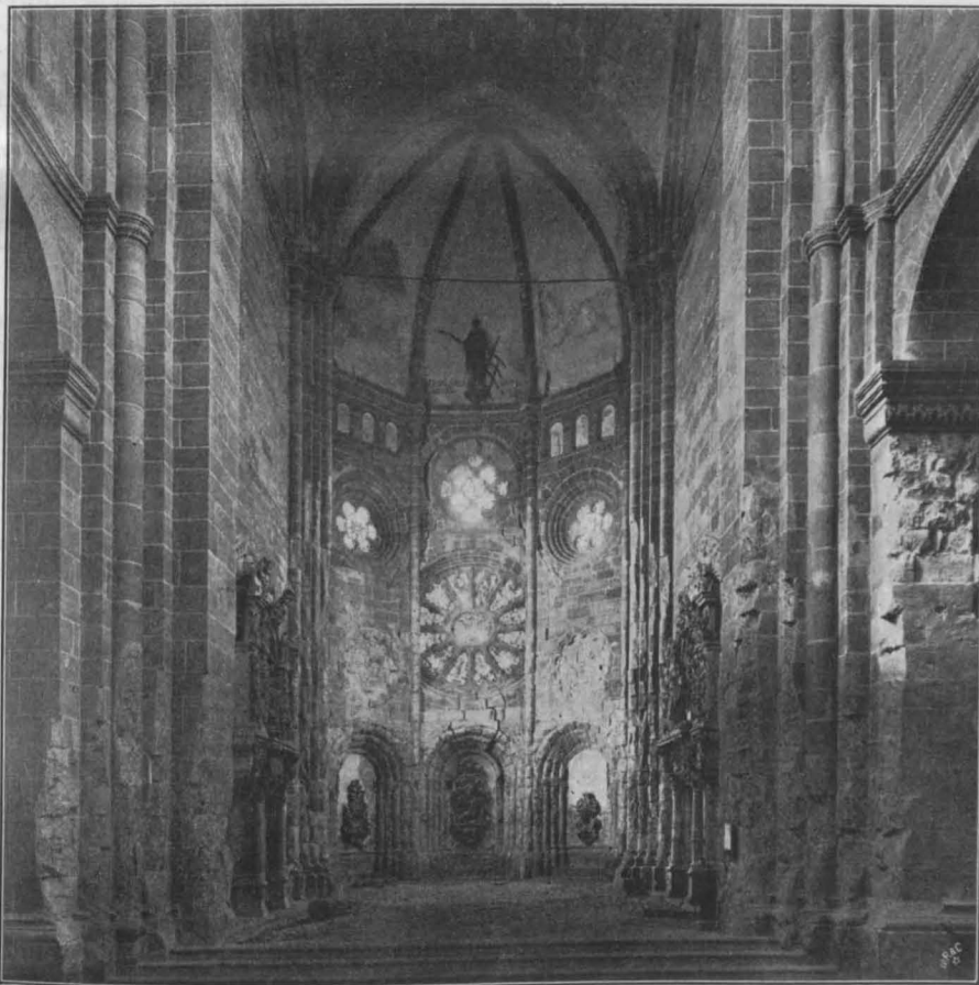
Abbildung 6. Einblick in den Westchor vor dessen Wiederherstellung. (Nach einer Aufnahme der Kgl. Preuß. Meßbildanstalt.)
