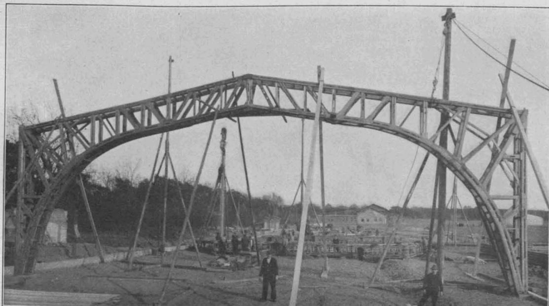
Abbildung 29. Ansicht des ersten aufgestellten Doppelbinders der Halle.
