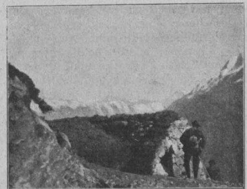
Abb. 27. Fast fertig hinterfüllte freistehende Mauer
