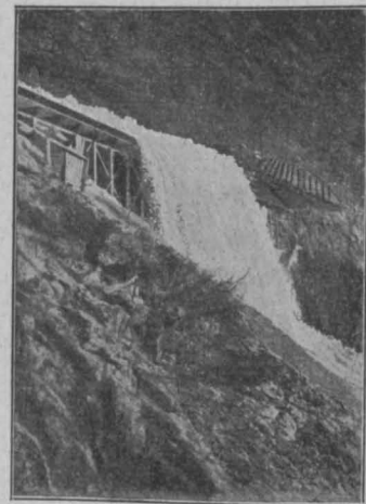
Abb. 11 Lawinengalerie im äußeren Mittelgraben
