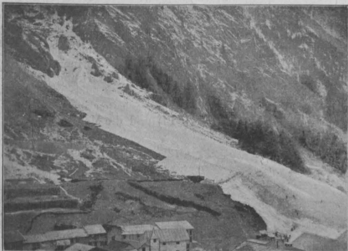
Abb. 5 Rotlawine am nördlichen Portal des Rotlawinentunnels am 23. Jänner 1910. Im Hintergrund die Stockgrabengalerie (Blick vom Installationsplatz am rechten Lonzaufer talauswärts)
