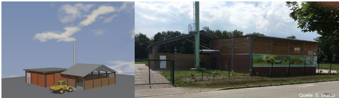
Abbildung 1: Holzhackschnitzelheizwerk mit Nahwärmenetz
