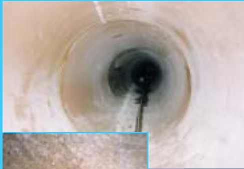
◀ Nach der Reinigung: starke Beton- korrosion / Bewehrung sichtbar!
