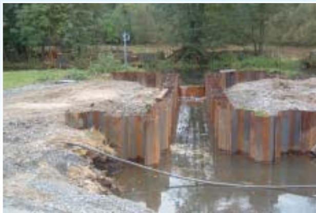
Staufufe Grebbinfließ im Bauzustand
