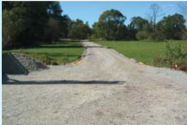
Bauzeitliche Zuwegung durch das BR Spreewald
