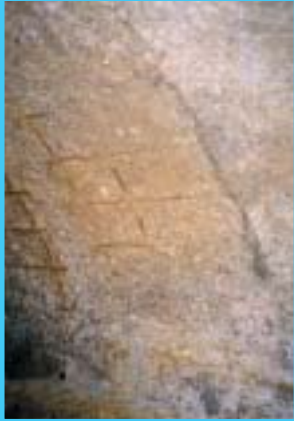
◀ Nach der Reinigung: starke Beton- korrosion / Bewehrung sichtbar!
