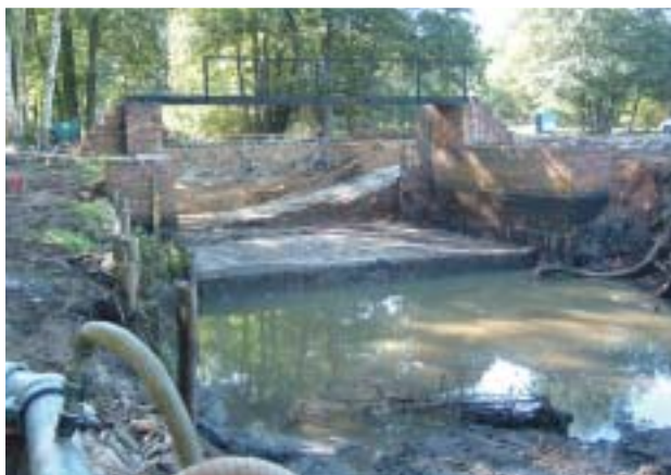
Altes Zeitzwehr vor dem Abriss
