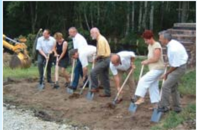
Spatenstich für den Ersatzneubau des Zeitzwehres am 16.08.2004
