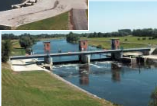
Bild 5 und 6: Ansicht der Gesamtanlage vom Oberwasser (linkes Bild) und Unterwasser (rechtes Bild) nach dem Umbau, Fa. TollenseCam Neubrandenburg, W. Schuster im Auftrag des Ingenieurbüros Döhler Neustrelitz
