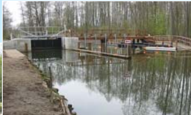
Staufufe Wehr 131 – fertige Anlage im März 2005
