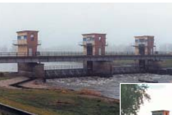
Bild 1 und 2: Ansicht der Gesamtanlage vom UW vor dem Umbau, LUA-Archiv
