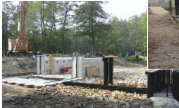
Staufufe Wehr 131 im Bauzustand - Wehr und Schleuse –
