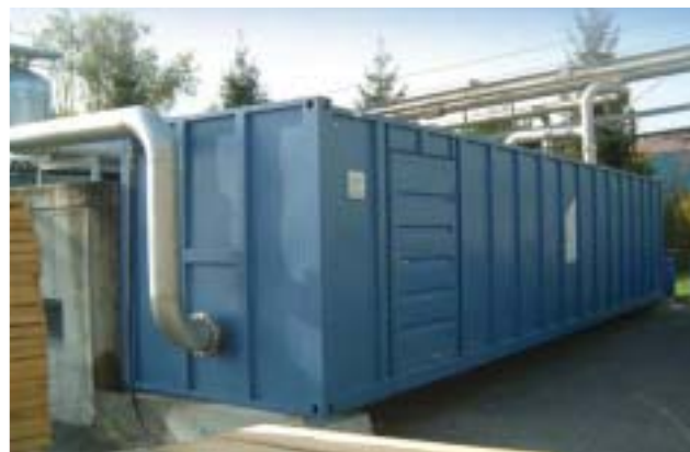
Geschlossener Biofilter: Reinluft Umwelttechnik Ing.-Ges. mbH
