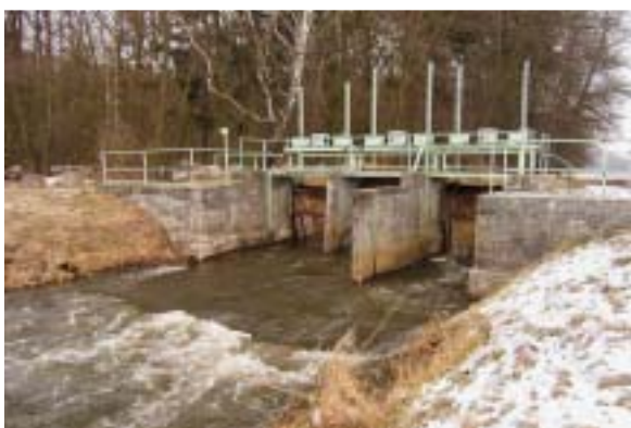
Ausgangszustand am Beispiel Wehr Stavenow, hier Ansicht von Unterwasser
