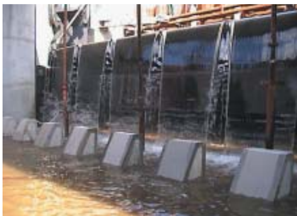
Bild 4: Probetrieb Verschlüsse und Tosbecken im linken Wehrfeld, D. Günther
