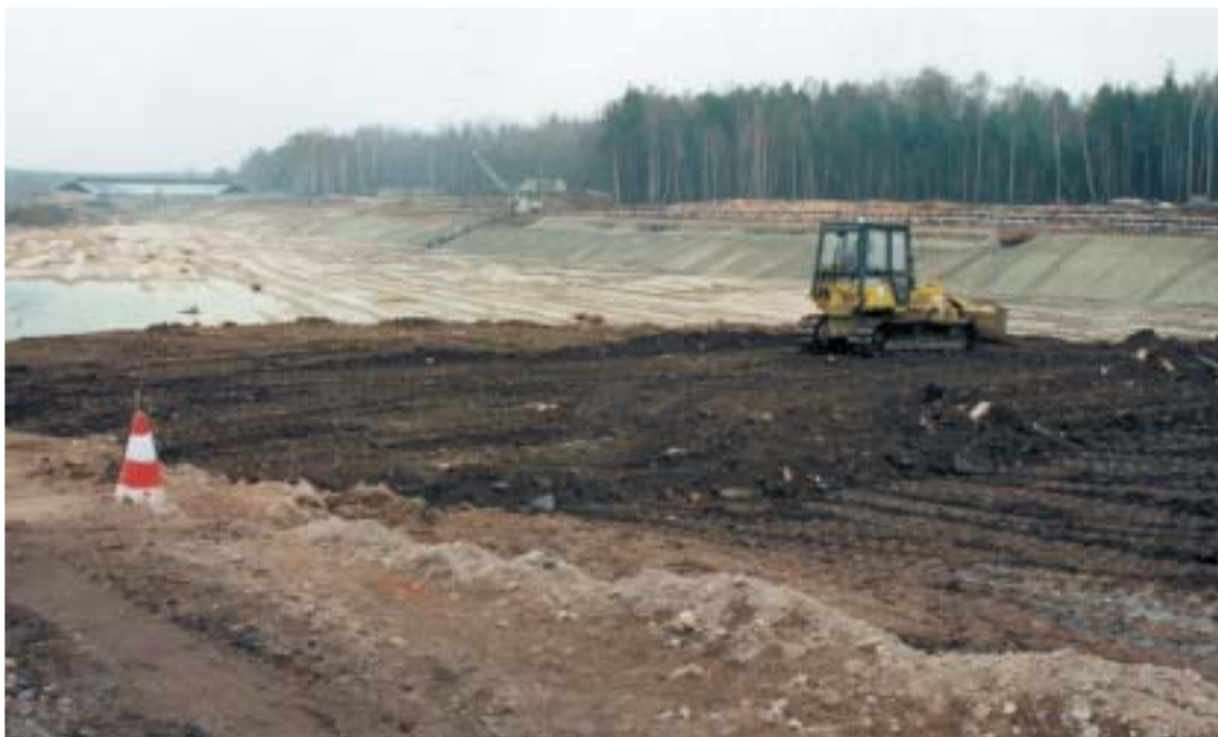
Wiedernutzbarmachungsarbeiten im Tontagebau Plessa (Verfüllung mit Bodenaushub)
