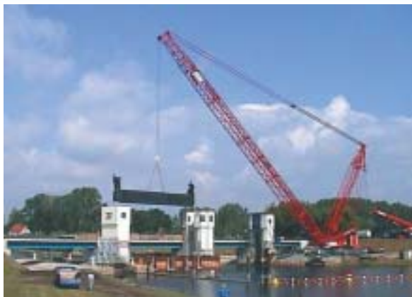
Bild 3: Montage des Grundschützes im linken Wehrfeld, D. Günther
