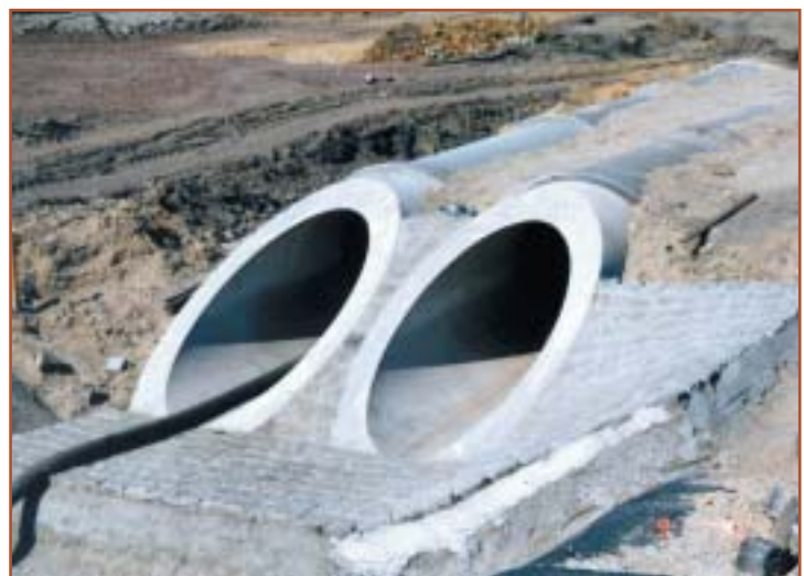
Entwässerung eines Umlagerungsbauwerkes: Ringgrabensystem in der Bauphase, Großprojekt Kokerei Lauchhammer, Foto: Archiv TZ
