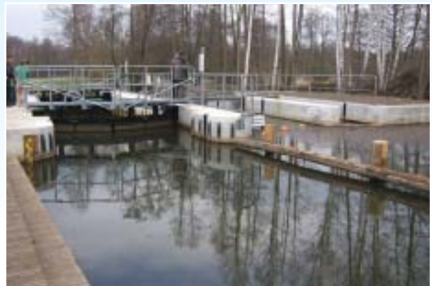
Ersatzneubau, Blick vom Oberwasser im April 2005
