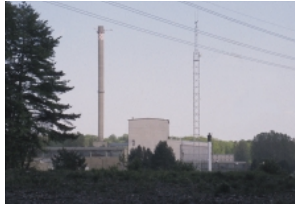
Soll vollständig zurückgebaut werden: das ehemalige Kernkraftwerk Rheinsberg
