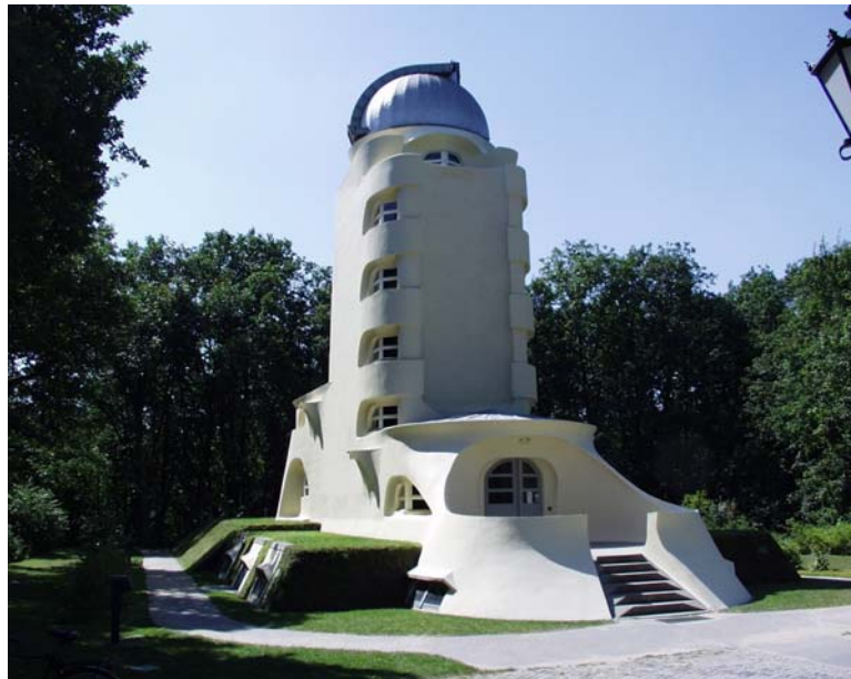
Abb. 18: Der 1924 durch Erich Mendelsohn errichtete Einsteinturm ist heute ein Symbol für den Wissenschaftsstandort Potsdam (Foto: Kühn)
