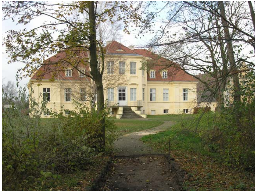
Abb. 1: Reckahn, Wegebauarbeiten im Gutspark 2004 (Foto: Volkmann)
