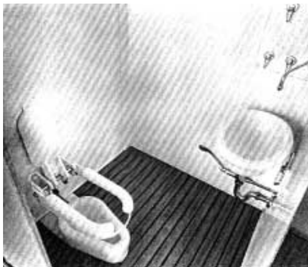
1.35 Toilette und Lavabo in der Sanitärkabine aus: Perriand, Charlotte: Un art de vivre. Paris 1985, Abb. 18
