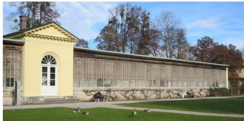
„Geranienhaus“, Ansicht von Südwesten mit Eingangspavillon und Ostflügel. Auf der Basis einer Befunduntersuchung erhielt der Pavillon 2015 einen Fassadenanstrich im Farbton „Nymphenburger Ocker“, Foto R. Herzog, 2016.
