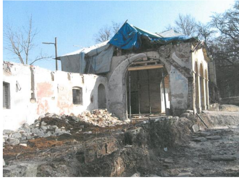
Blick in die Baustelle, 2011. Foto: Bayerisches Landesamt für Denkmalpflege, Höllerer.
