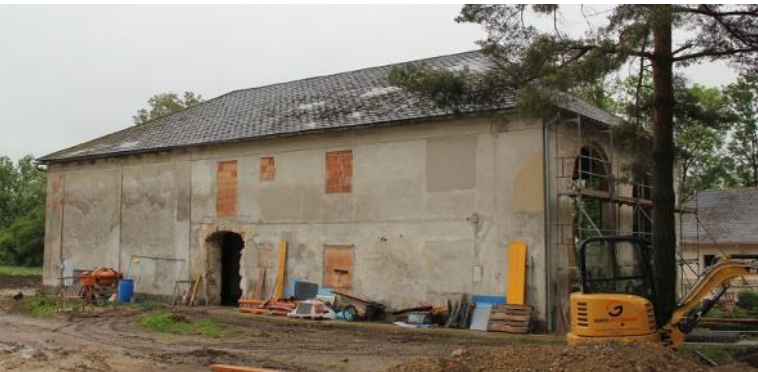
Feigenhaus Kremsmünster während der Sanierungsarbeiten, Foto C. Hlavac, 2016.
