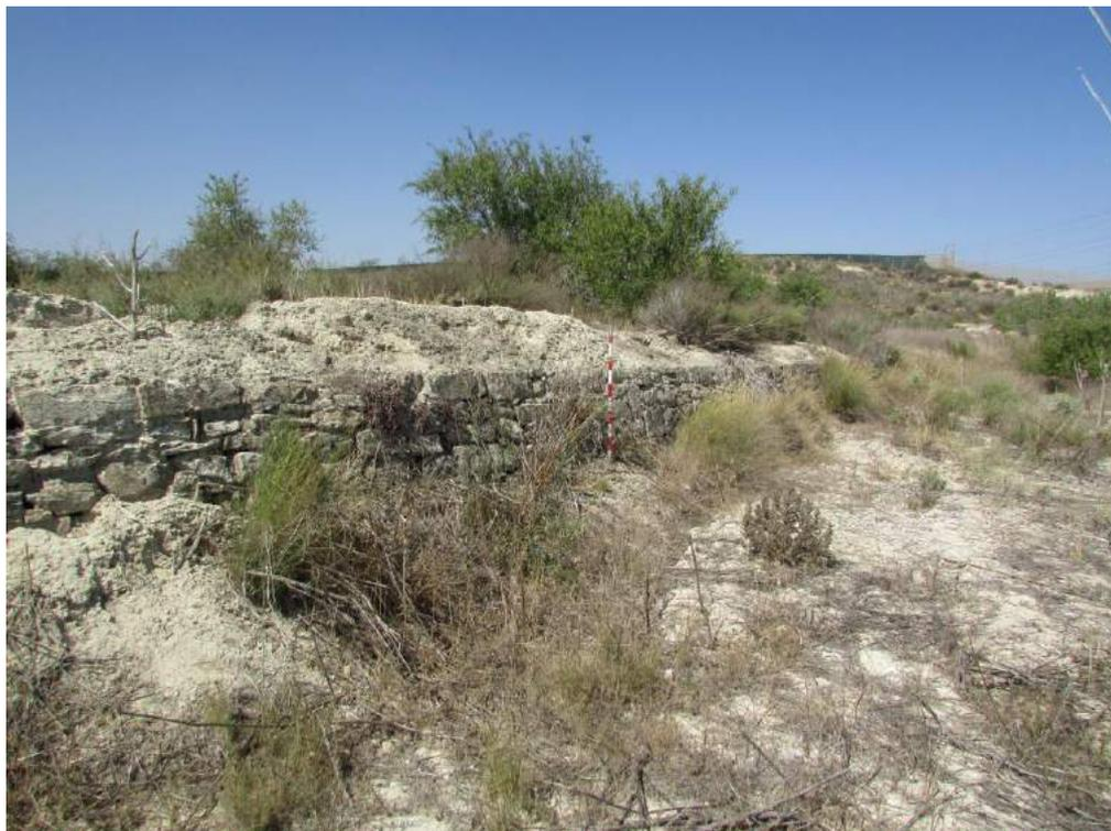
Foto 5. Muro de aterramiento contruido con calcarenitas de la zona dispuestas en seco.
