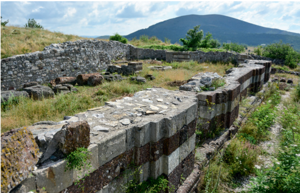
Сл. 19. Црква Светіої Николе, део јужної зида (1960. и 2016. године) Fig. 19. St Nicholas Church, a part of the south wall (1960)
