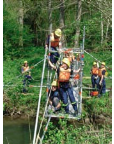
Gemeinsam wird der EGS-Steg vorangebaut.
