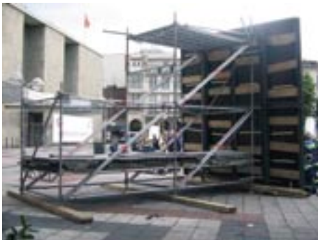
Eine ausgeklügelte Stützkonstruktion.
