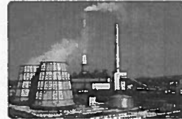
UST-ILIMSKAYA CHP 525 MW
