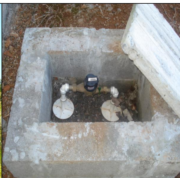
FOTO 06 – Hidrômetro
