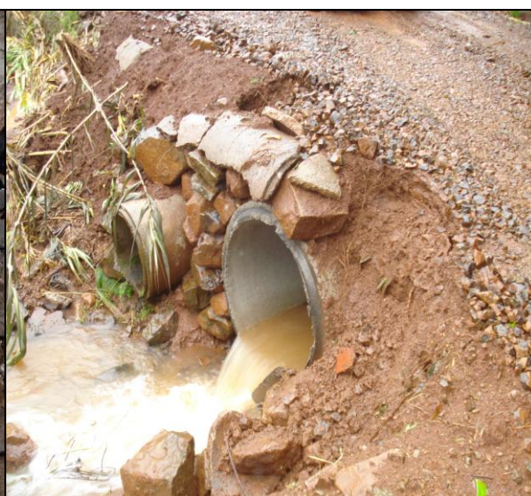
FOTO 06 – Disposição Final das Águas Pluviais
