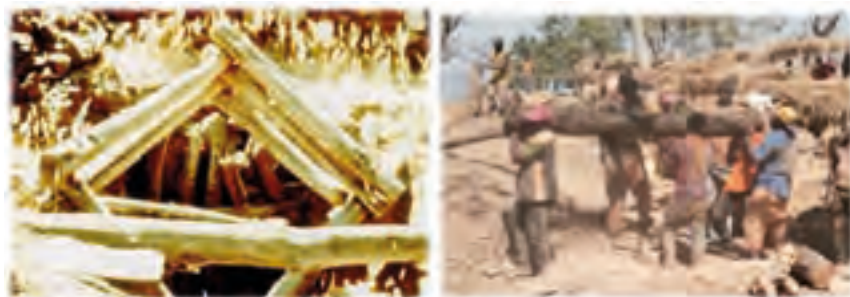
Figure 53 : Système de boisage utilisé pour le soutènement des ouvrages miniers (site de Bida, Burkina Faso).
