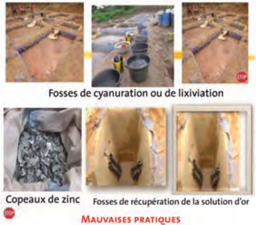
Figure 37 : Méthodes de la récupération de l'or par cyanuration en fosses (Sites de Kéniéba, Ouest Mali).
