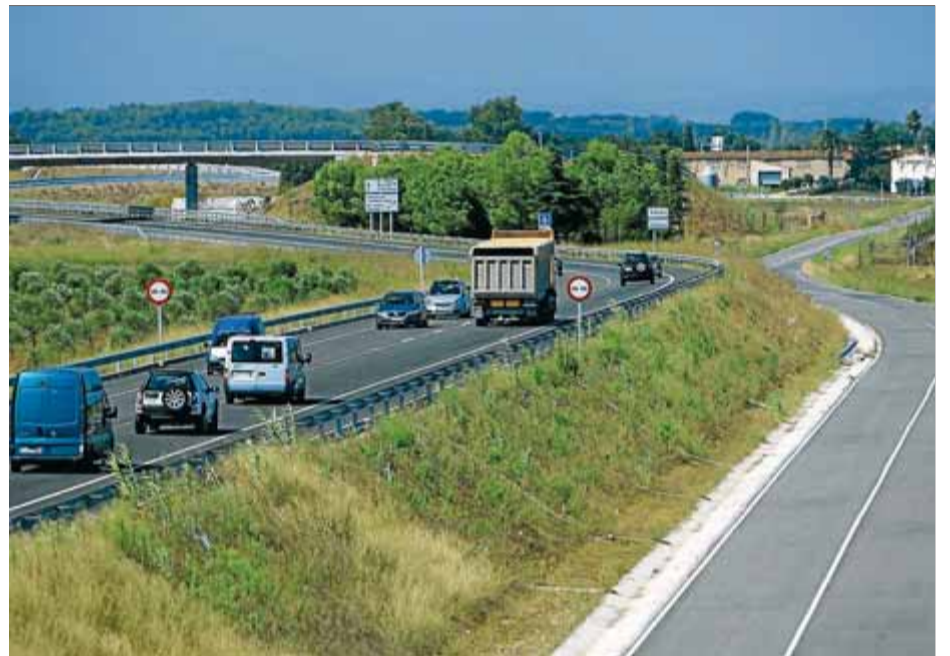
Una imatge de la carretera C-31 a l'altura de Viladamat. Fa un any i mig que es va acabar la construcció d'aquest tram de via ■ MANEL LLADÓ
