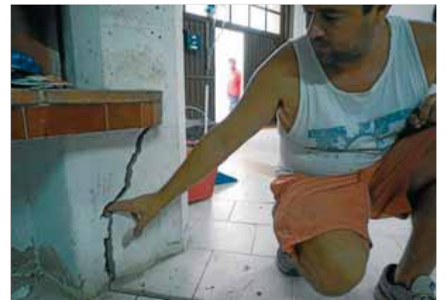
Escletxes en un mur d'una casa particular de Barberà de la Conca ■ TJERK VAN DER MEULEN
