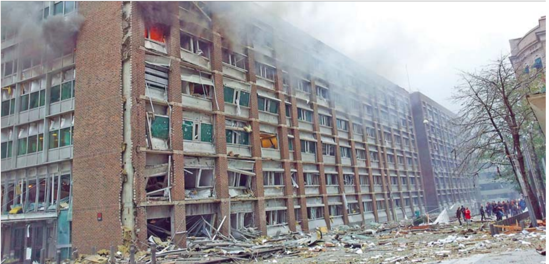
Un dels edificis governamentals afectats per l'explosió d'una bomba, ahir al centre de la capital noruega ■ REUTERS
