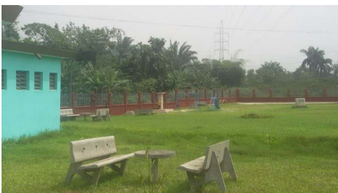
Photo 5 : Vue d'une portion de clôture construite
