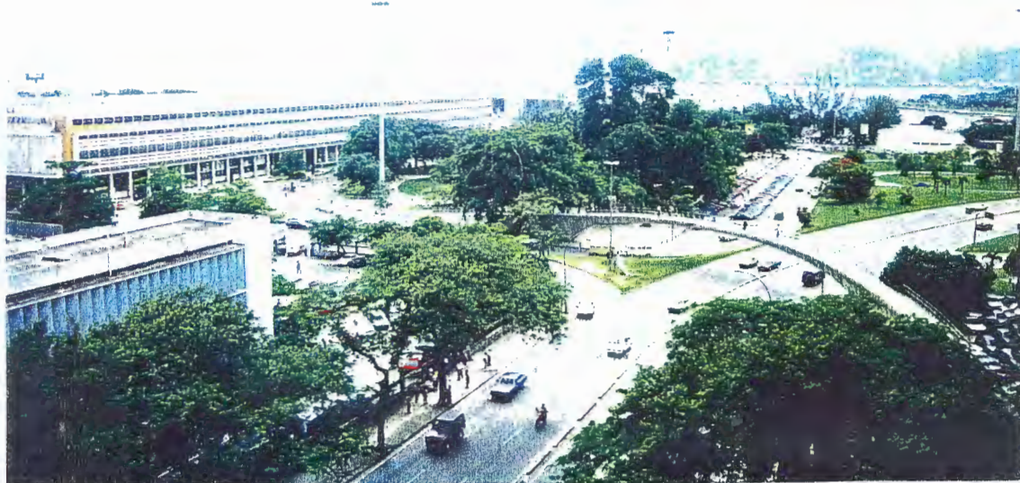
Ilustração 4.1: Vista geral da Praça Salgado Filho. Em primeiro plano, a passarela que atravessa a "freeway" e ao fundo e à esquerda o prédio do Aeroporto Santos Dumont.
