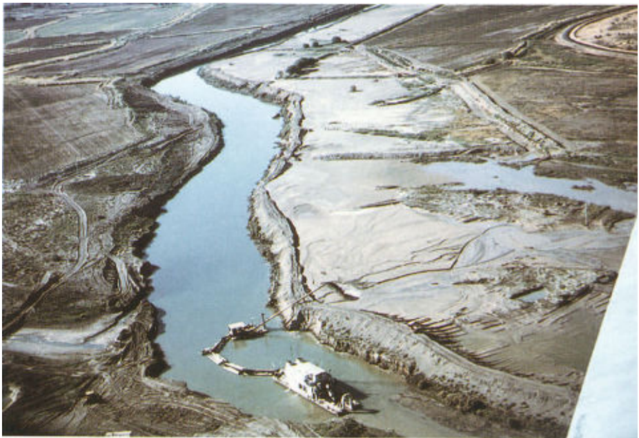
Bildtafel 7. Oben: Delta des Amu-Darja nördlich von Nukus. Das Foto zeigt die Größenordnung der Bauwerke, die für die Bewässerung angelegt wurden, sowie den Baumwoll- und den Reisanbau in diesem trockenen Ökosystem. Unten: Der Kanal wird gerade von einem Saugförderbagger ausgebaggert. Dieser schleudert das Schwemmaterial auf das Kanalufer. Dieses Foto zeigt gut, wie sehr die Umwelt im Bereich der Kanäle und der Bauten zur Bewässerung zerstört wurde (Aufnahmen: M. Mainguet, 1990)
