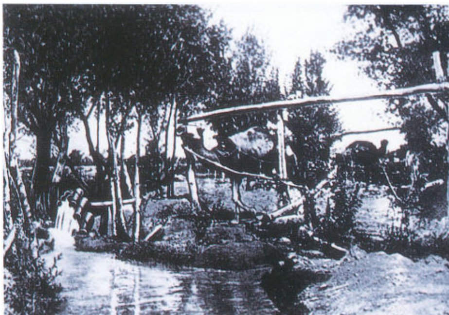
Bildtafel 23. Ober: Russisches Fort in Turkestan, mit schlichten Mitteln auf einer Anhöhe aus Erde errichtet, die von einem Graben umgeben und von einem Holzzaun begrenzt ist (nach einer Gravur von 1840). Es erinnert durchaus an die kleinen Forts, die die amerikanischen Pioniere bei der Eroberung des wilden Westens bauten. Unten: Ein urtümliches Schöpfrad (Schirik) in der Gegend von Chiwa. Die Schaufeln sind Tonkrüge aus gebrannter Erde. Das Kamel, das die Achse antreibt, hat verbundene Augen (nach einer Fotografie von Suslow 1946)
